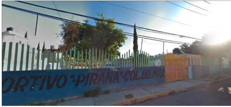
Ilustración 9. Fachada principal exterior del módulo deportivo Piraña donde se observa un sitio deteriorado y abandonado.
