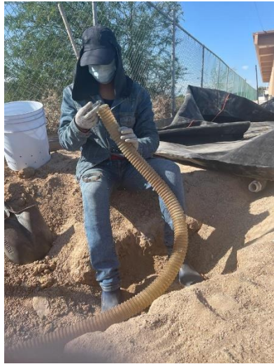
Puesta de tubería para estanques
