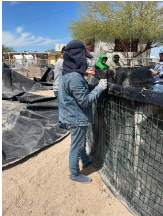
Estanques de geomembrana con malla
