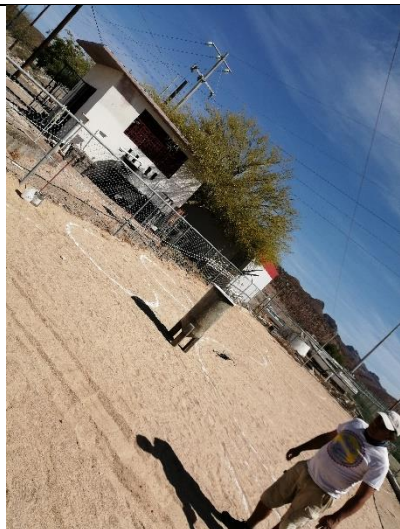
Terraplén de terreno para estanques.
