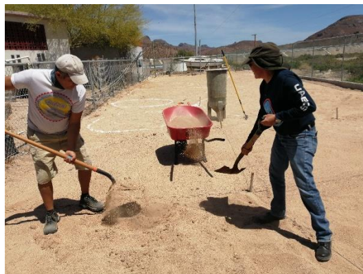
Nivelación de terreno para estanques de geomembrana
