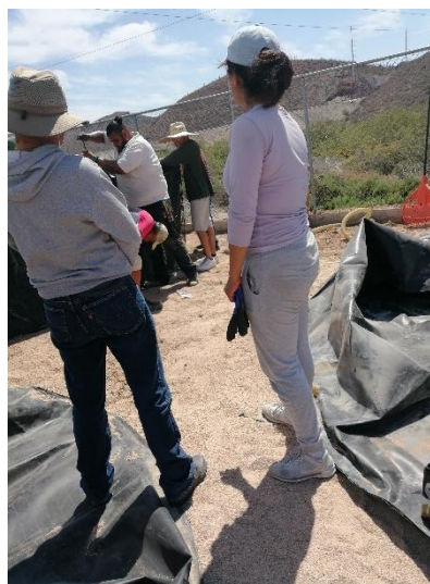
Puesta de estanques de geomembrana
