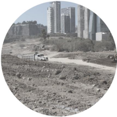
EXCAVACIONES Y RELLENOS
