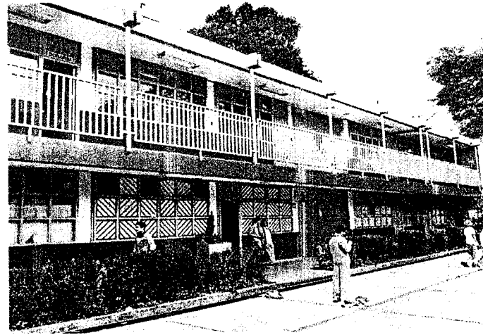
APLIACION DE PINTURA EN EDIFICIO
