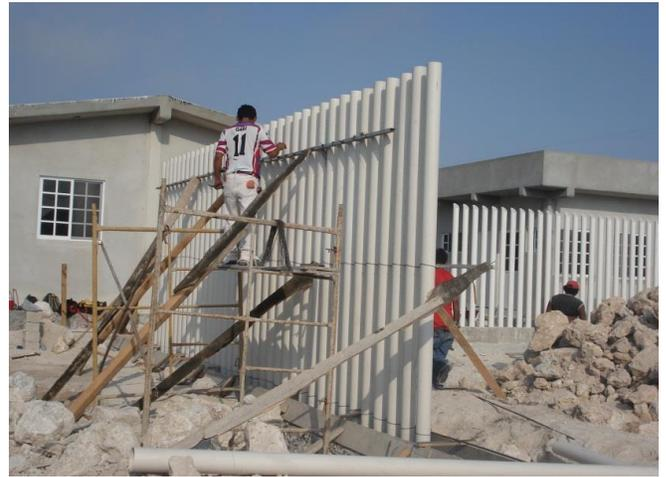
Se concluyó con la colocación de tubos de la barda perimetral abierta.
