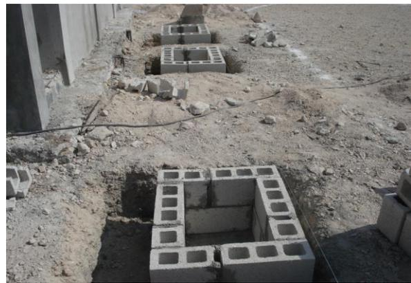
Se continúa con la excavación de cepas para construcción de registros para la colocación de tubos.
