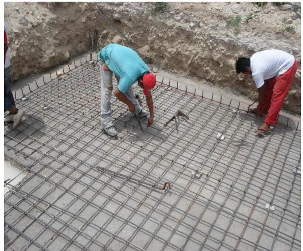
Se efectuó trazo y nivelación, excavación, relleno y compactado, colado de plantilla, así mismo se realizó la colocación de acero para la losa de cimentación
