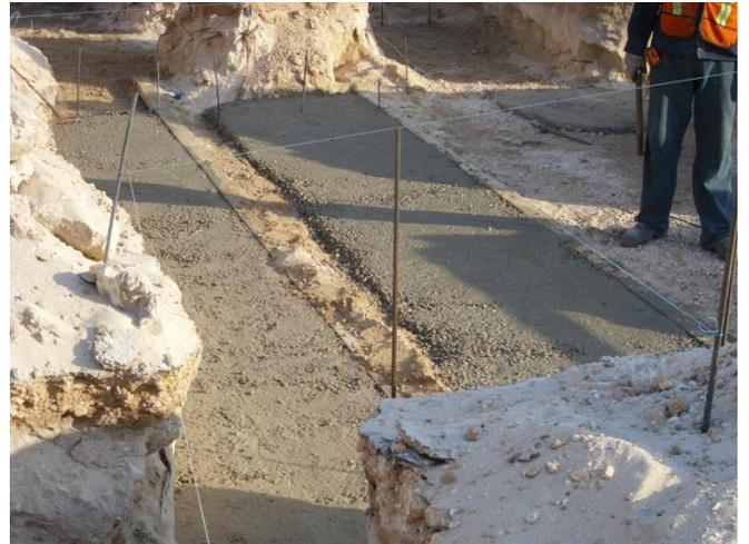
Se realizó trazo y nivelación con equipo de topografía en el área de desplante de la cimentación, dejando referencias y niveles en una superficie de aproximadamente 186 m<sup>2</sup>. Se realizó excavación para cimentación en x ml aprox. por medios mecánicos en zona "A" material seco tipo uno, para desplante de zapatas de concreto armado.-
