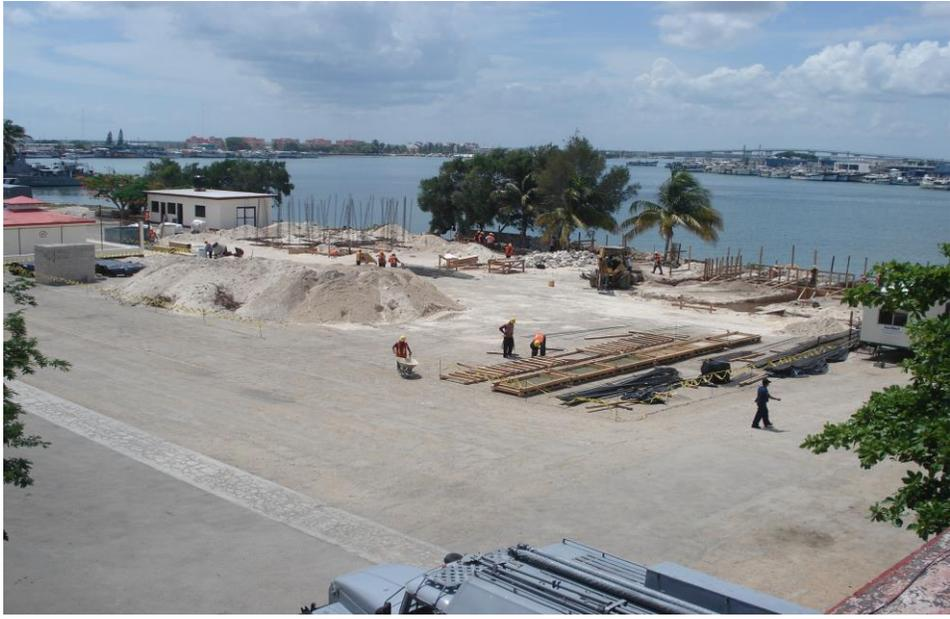
Se inicio con la colocación de piedra braza de la región para la construcción del muro de contención a un costado del edificio del centro de operaciones con alojamiento para 8 personas.
