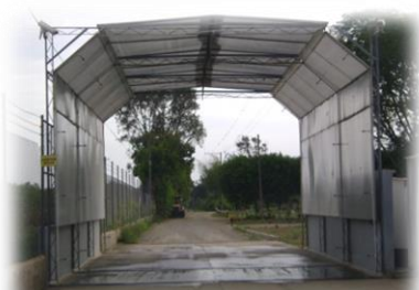
Figura 15. Arco Sanitario Vehicular
