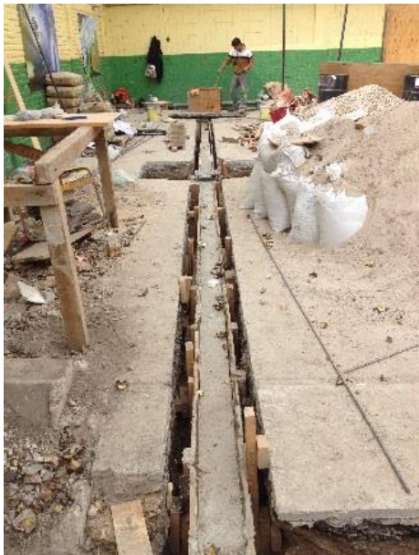
Se inicia la descimbra de la cimentación escuela Republica de Colombia
