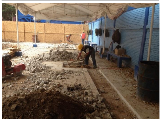
Se inician trabajos de excavación en escuela Prof. Manuel S. Hidalgo
