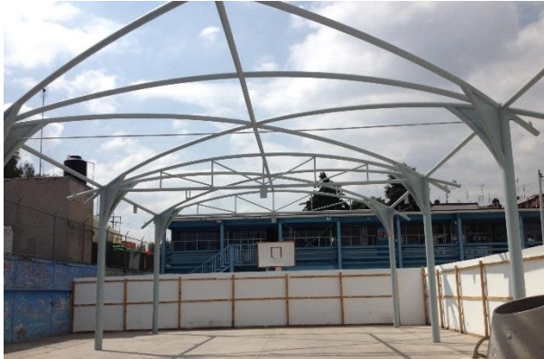
Estructura montada por completo con primera mano de anticorrosivo escuela Tecayehuatzin
