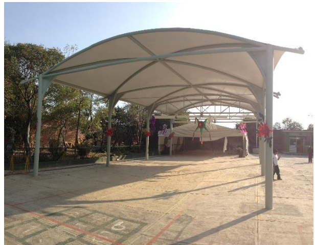
Proyecto completado Membrana arquitectónica escuela Lic. Antonio Martínez de Castro
