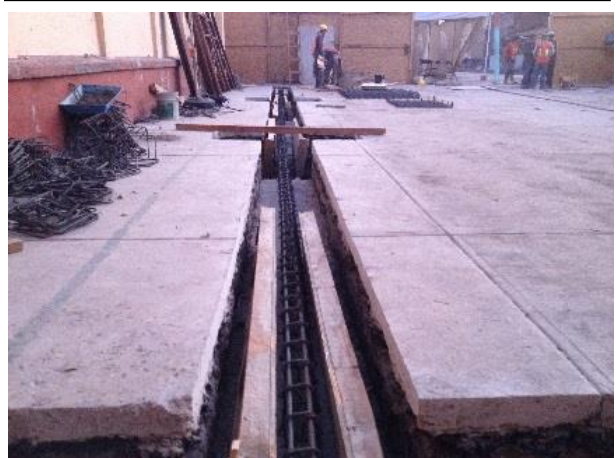
Se coloca la cimbra en cimentación escuela Francisco de Paula Herrasti
