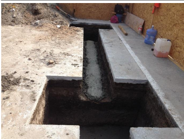
Se coloca la plantilla de cimentación escuela Mtra. Ema Godoy
