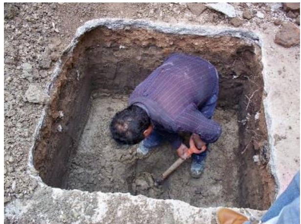
Se encuentra en excavación presencia de arcillas escuela Lic. Alfredo V. Bonfil Pinto
