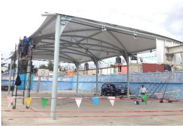
Se coloca los mecanismos para las cortinas escuela Tecayehuatzin
