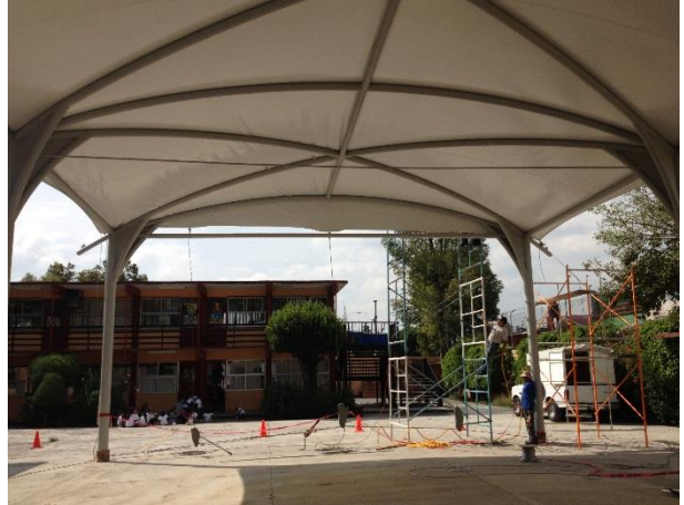
Se realiza el tensado de la lona escuela General de División Marciano Jiménez
