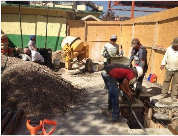
Se coloca la plantilla de cimentación escuela Mtra. Ema Godoy
