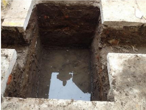
Se encuentra en excavación manto freático escuela Leyes de Reforma
