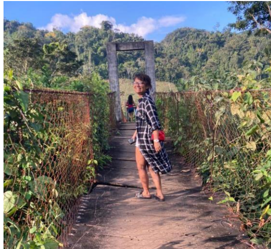
Ilustración 1: MPSS puente colgante Paraíso, Tulija, 2020.
