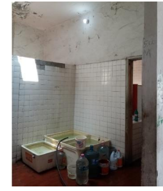
B. Área de sanitarios
