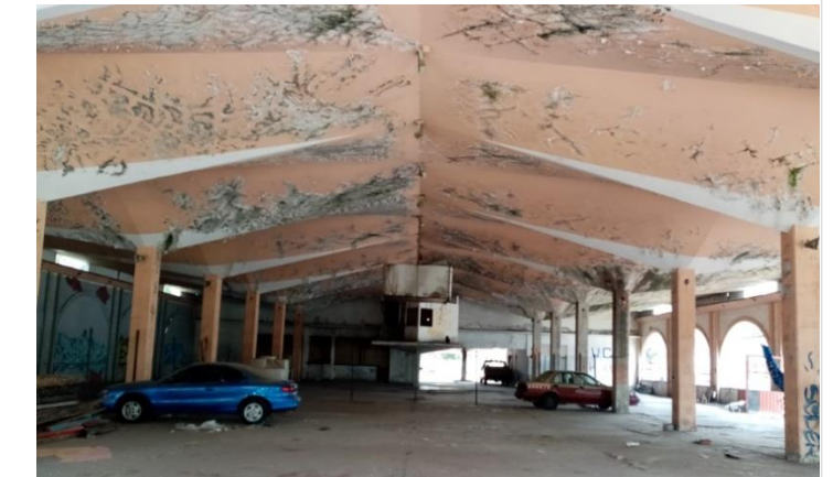
D. Estructura de paraboloides
