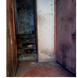
I. Escalera en área de servicios
