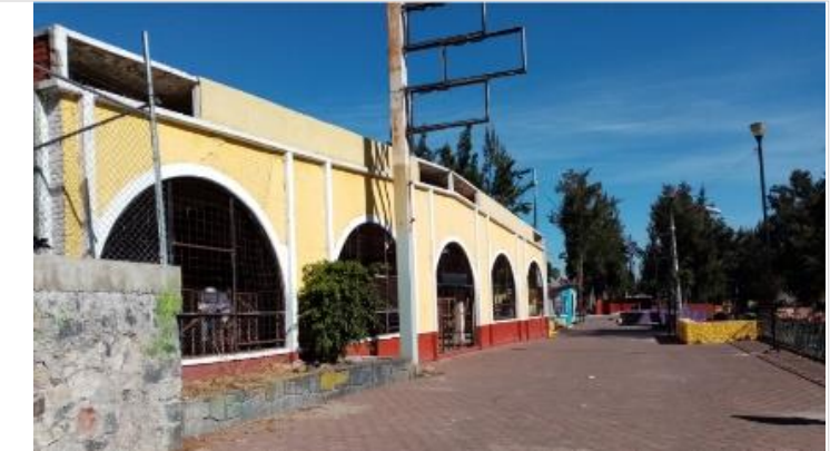
B. Fachada sureste
