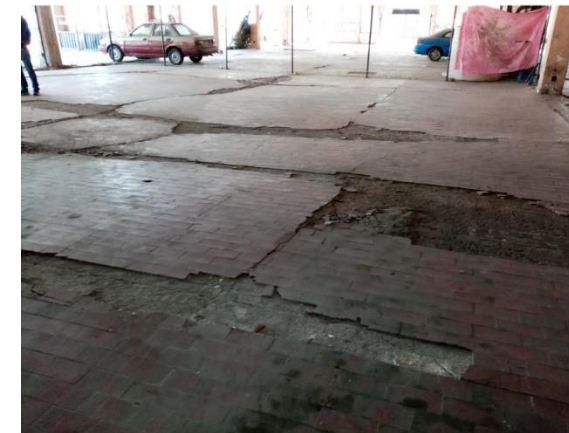
C. Piso al interior de la construcción
