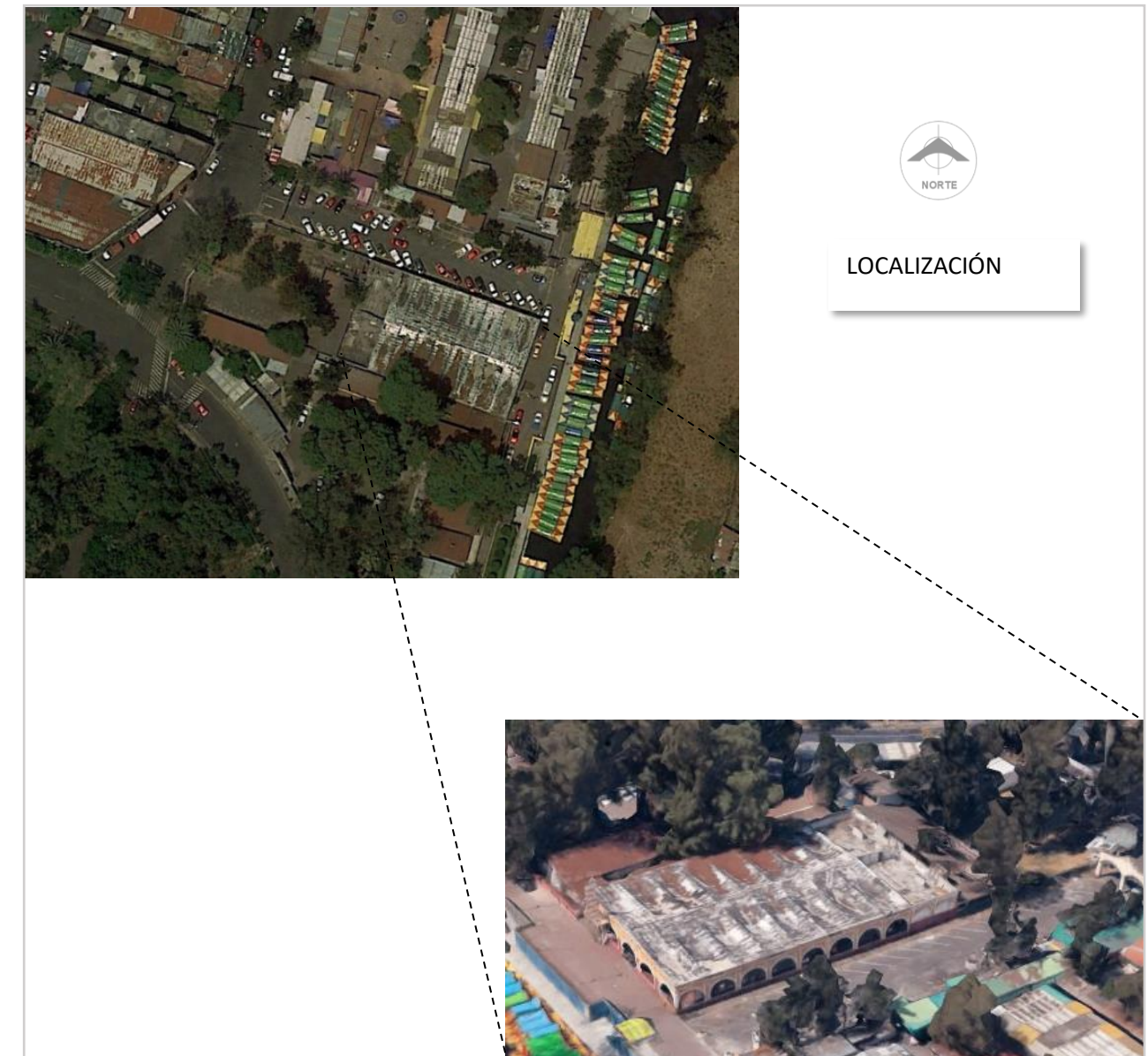
Imagen 85. Localización del inmueble Restaurante Las Flores en la zona de estudio de SMNN (Elaboración propia con imágenes obtenidas de Google maps, 2019).
