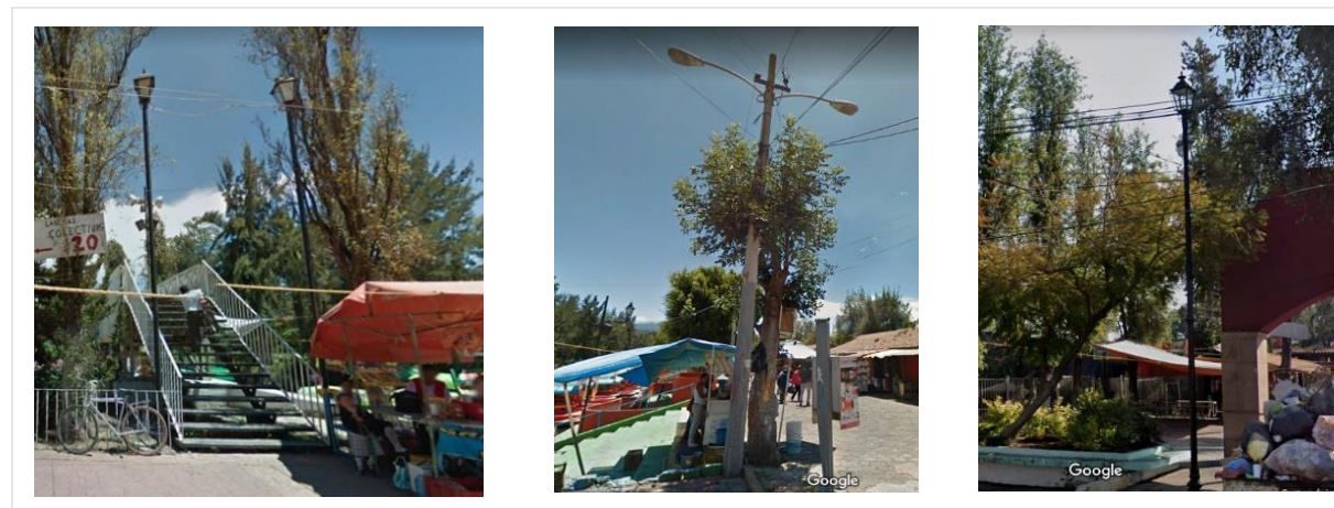
Imagen 77. Tipo de infraestructura para alumbrado público en área de Embarcaderos (Google Maps, 2019).
