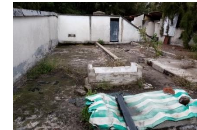
H. Azotea de área de servicios
