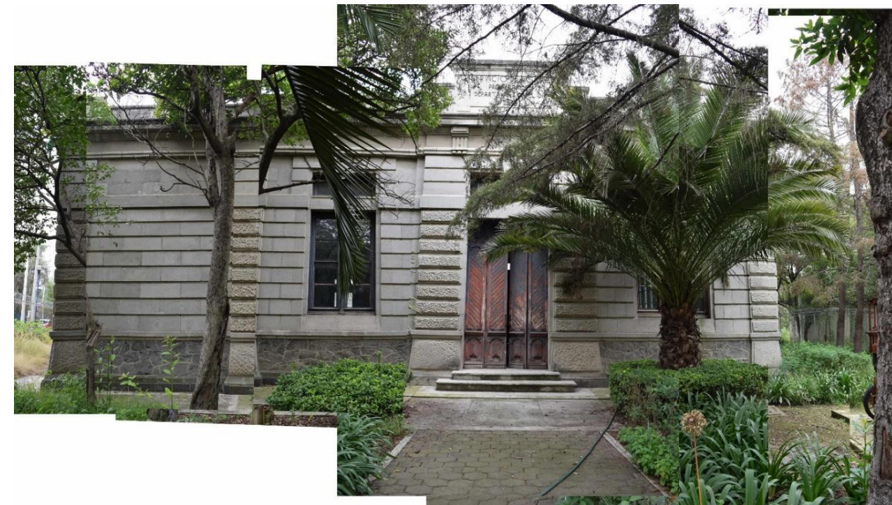
Imagen 42: Mosaico fotográfico de la fachada principal (oriente) de la Casa de Bombas No. 5. Fuente: Elaboración propia, Junio 2020
