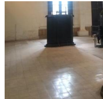
Imagen 55: Piso interior Casa de Bombas No. 5. Fuente: Autores, Junio 2020
