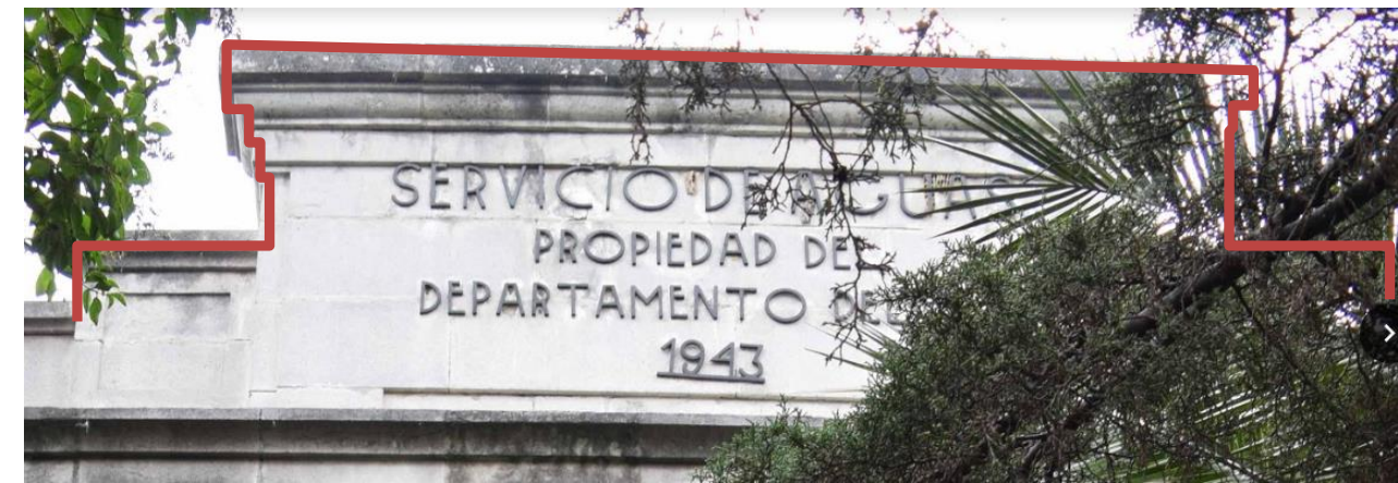
Imagen 45: Remate del edificio sobre las fachadas principales (oriente y poniente). Fuente: Elaboración propia, Junio 2020
