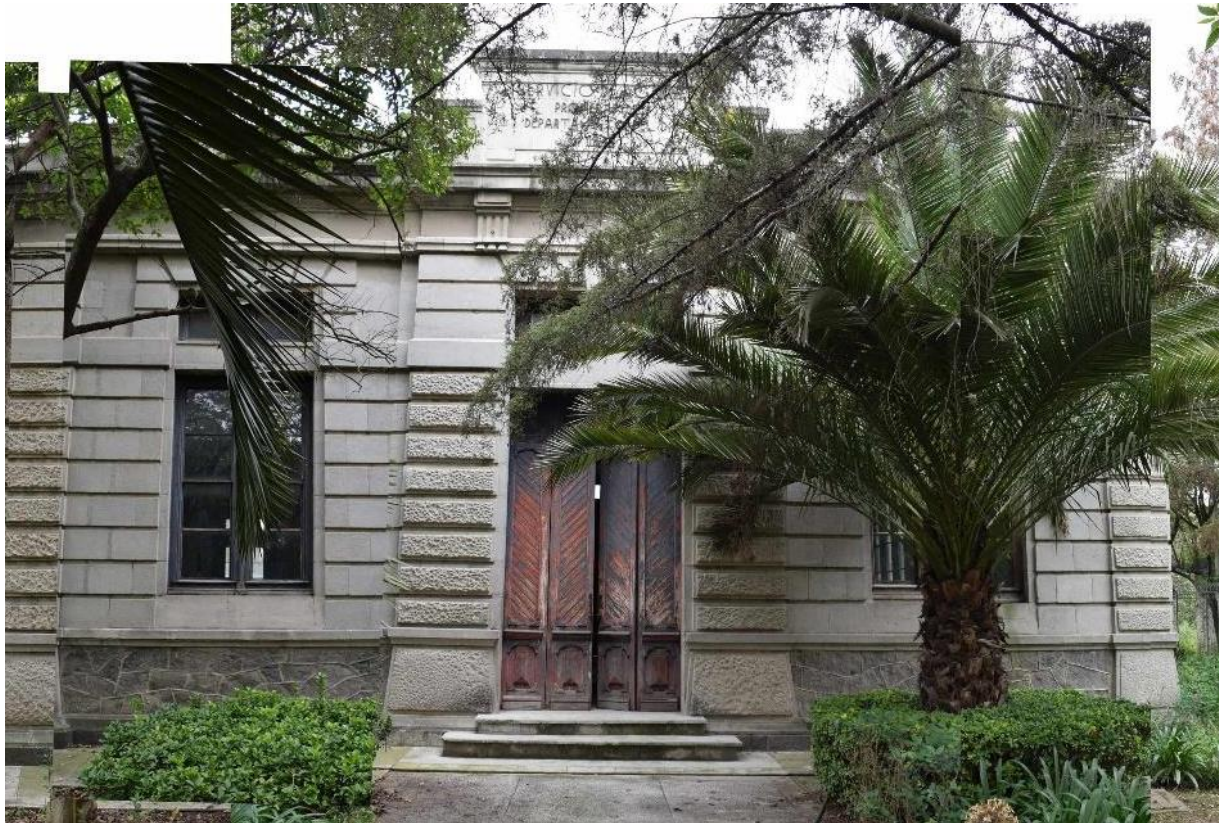
Imagen 50: Detalle de puerta y ventanas sobre fachada principal (oriente) de la Casa de Bombas No. 5. Fuente: Autores, Junio 2020
