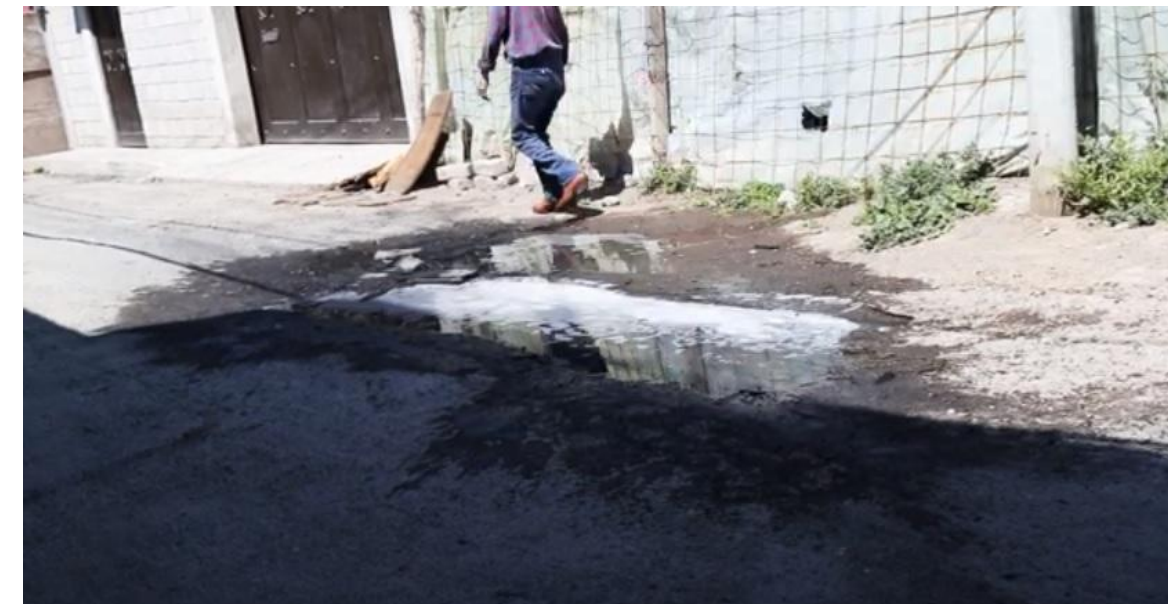
Imagen 34: Fugas de aguas negras en vía pública. Fuente: Autores, Mayo 2020
