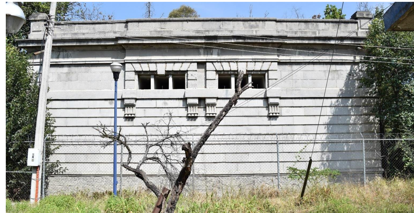
Imagen 51: Fachada sur de la Casa de Bombas No. 5. Fuente: Autores, Junio 2020
