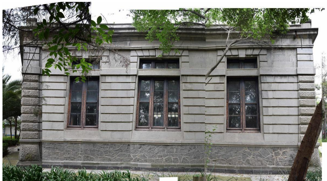
Imagen 54: Mosaico fotográfico de la fachada norte de la Casa de Bombas No. 5. Fuente: Autores, Junio 2020
