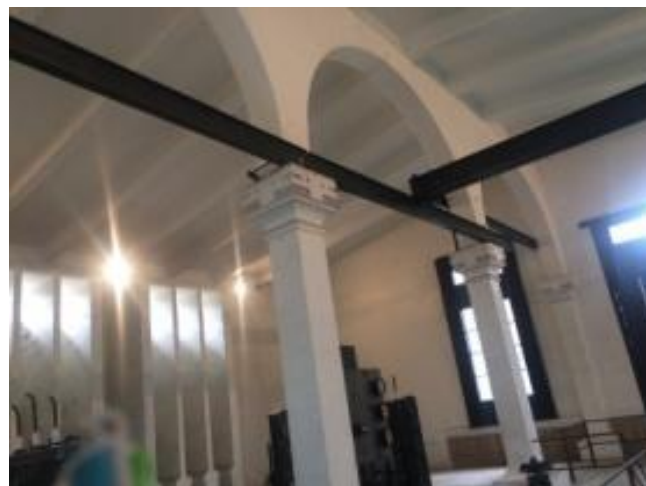
Imagen 62: Columnas y arcos interiores de carga Casa de Bombas No. 5. Fuente: Autores, Junio 2020
