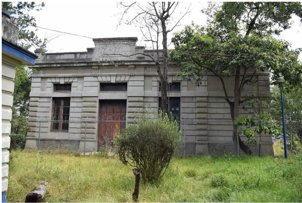
Imagen 53: Fachada poniente de la Casa de Bombas No. 5. Fuente: Autores, Junio 2020
