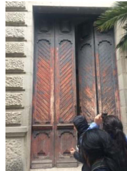
Imagen 59: Puerta sobre fachada principal (oriente) de la Casa de Bombas No. 5. Fuente: Autores, Junio 2020
