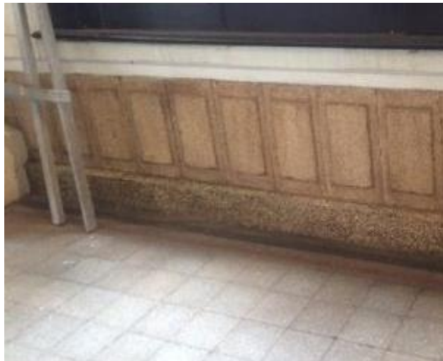
Imagen 57: Rodapié en el interior de los muros de la Casa de Bombas No. 5. Fuente: Autores, Junio 2020
