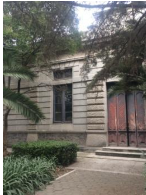
Imagen 61: Detalle de la puerta y fachada principal (oriente) Casa de Bombas No. 5. Fuente: Autores, Junio 2020
