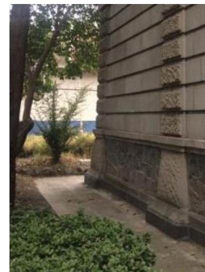
Imagen 56: Piso exterior perimetral a la Casa de Bombas No. 5. Fuente: Autores, Junio 2020
