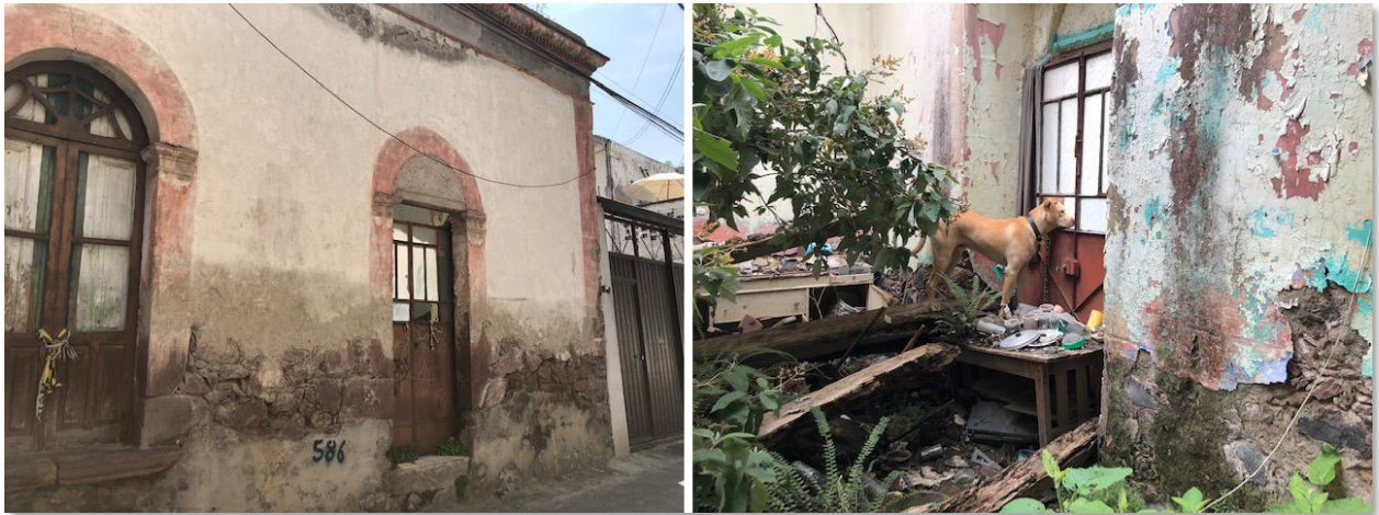
Fig. 22 A la izquierda fotografía de la fachada a calle Del Calvario y a la derecha parte del interior de la casa. Elaboración propia
