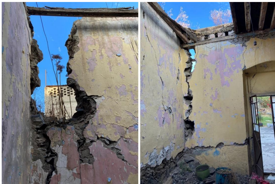
Fig. 16 Imágenes desde el interior muros nororiente y suroriente. Elaboración propia
