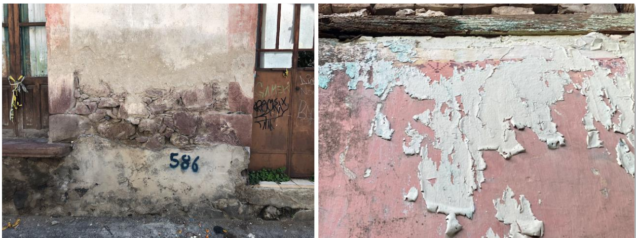
Fig. 17 Fotografía en detalle de la fachada exterior y detalle del acabado interior. Elaboración propia
