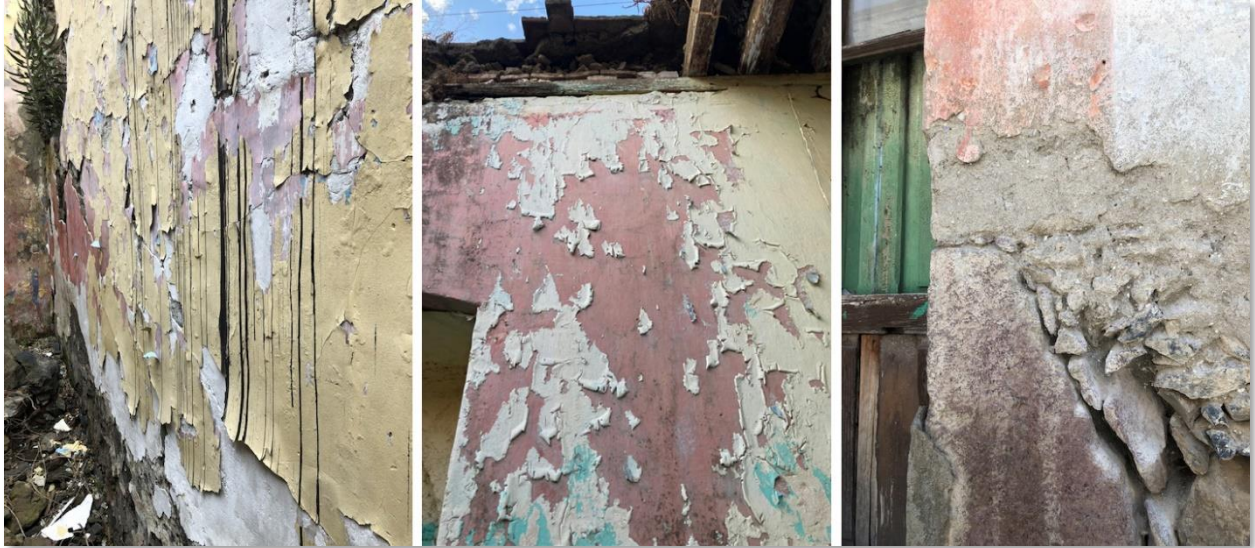
Fig. 31 Fotografías en detalles de acabados interiores y exteriores. Elaboración propia
