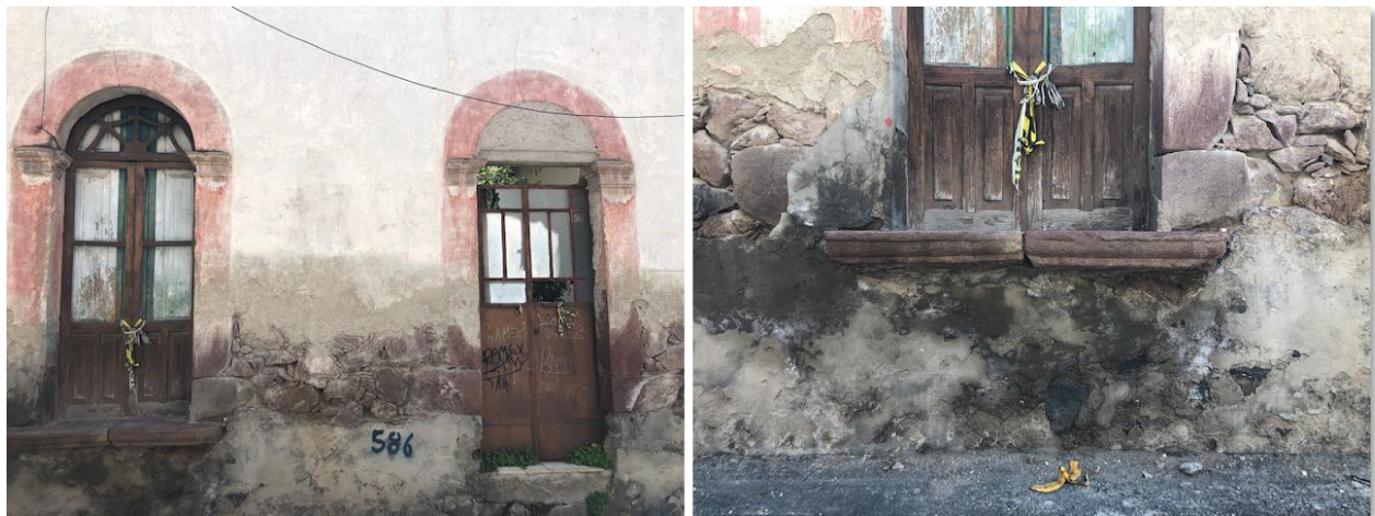
Fig. 30 Vanos exteriores. Elaboración propia
