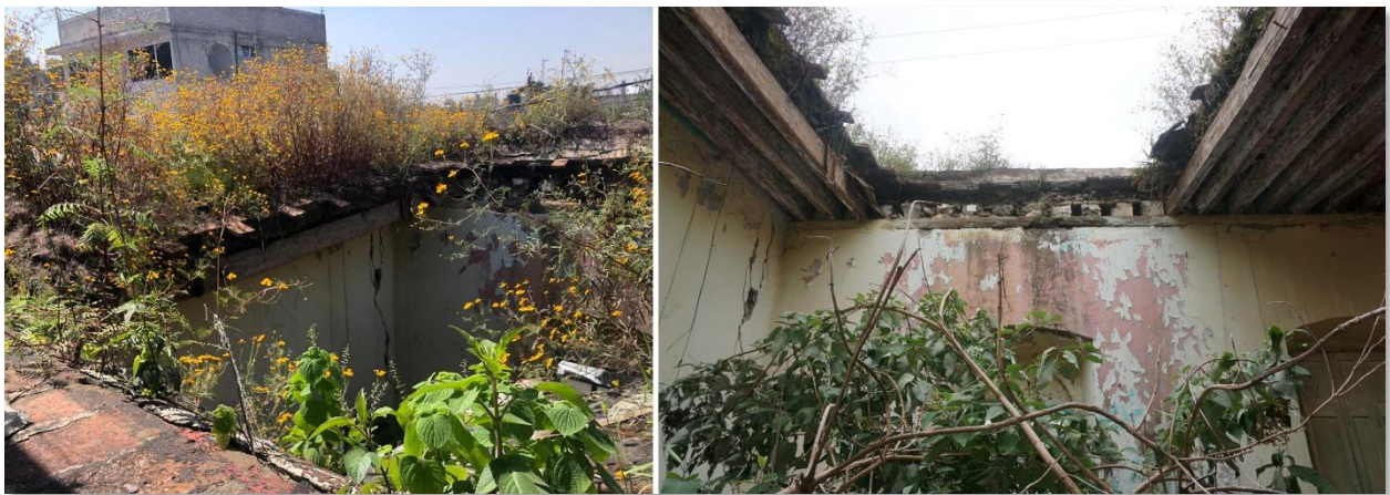
Fig. 29 Fotografías del sistema de techumbre. Elaboración propia
