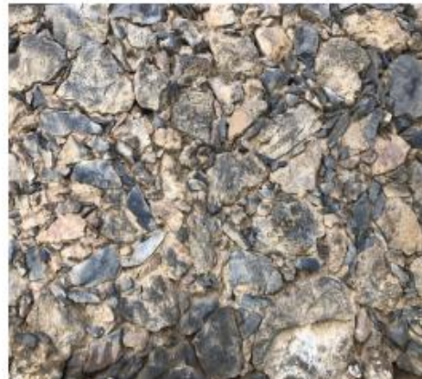
Imagen 114. Rodríguez K. 2020. Fotografía fabrica de muro C. Elaboración propia.
