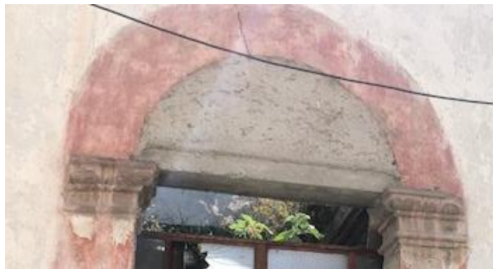
Imagen 107. Recubrimiento de arco puerta principal casa de piedra. Elaboración propia
