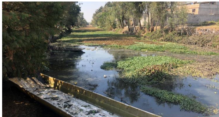
Imagen 8. Rodríguez, K. 2019. Elaboración propia. Zona de embarcadero – Casa de Bombas Santa Cruz Acalpixca
