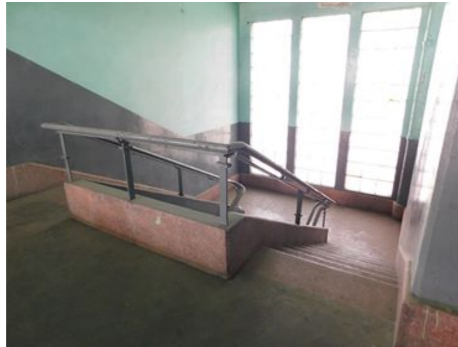
Ilustración 61: Escaleras. Fotos del Autor
