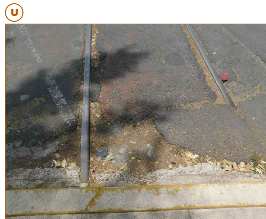
VISTA A DETALLE DONDE LA VÍA SE TAPA MEDIANTE EL CAMELLÓN
