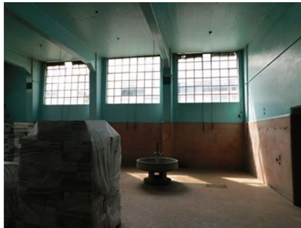
Ilustración 58: Área de regaderas. Fotografía del Autor.
