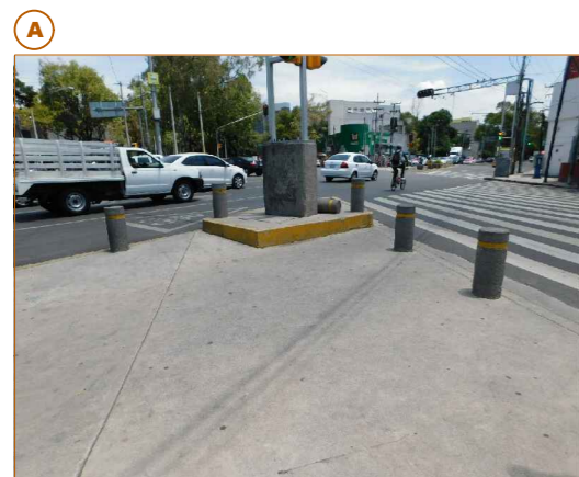
Esquina de Marina Nacional y Mariano Escobedo, Mobiliario urbano derribado y sin mantenimiento
