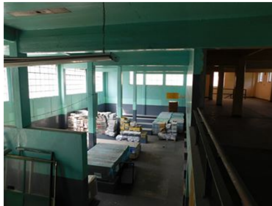
Ilustración 55: Ala poniente, espacio a doble altura. Foto del autor.
