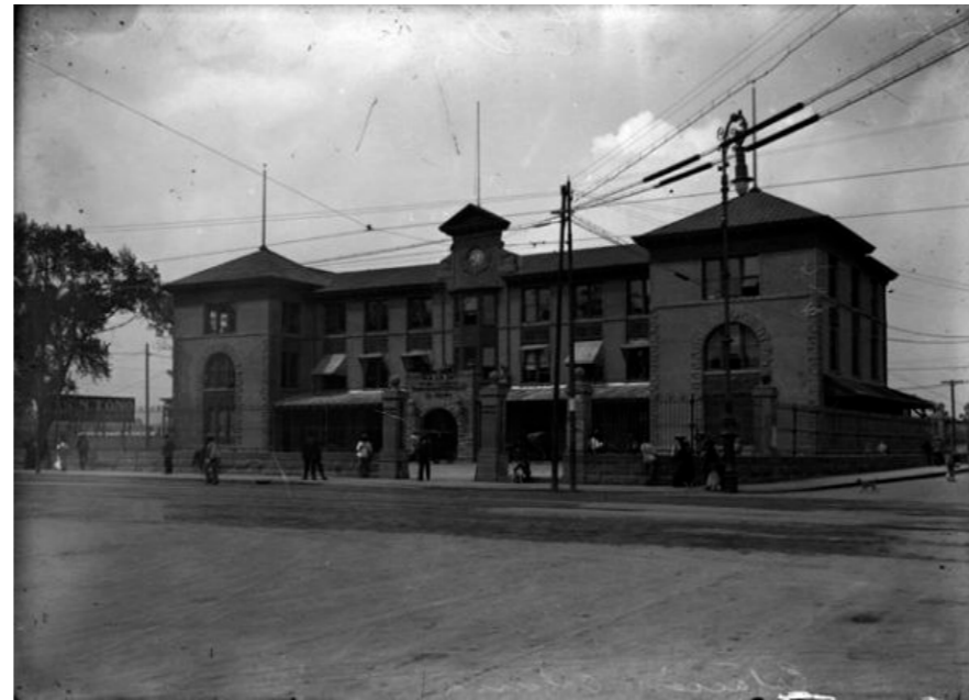
Ilustración 21: Fototeca Nacional INAH. (1918). Estación Colonia [Imagen]. Retomada el 6 May 2020, de: http://luisrodriguez.mx/mirada/en-pro-de-una-ciudad-moderna-el-desmantelamiento-de-la-estacion-colonia-en-la-ciudad-de-mexico/ .
