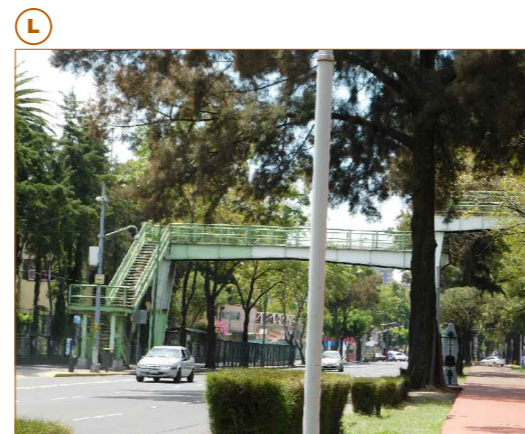
LUMINARIAS INSUFICIENTES, EQUIPO DE GIMNASIO Y PUNTE PEATONAL SUB-UTILIZADOS
