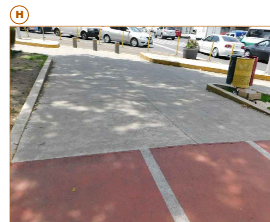
CAMBIO DE MATERIALES, Y EQUIPAMIENTO, SON ESCASOS PERO SE COLOCARON CONTENEDORES DE BASURA.
