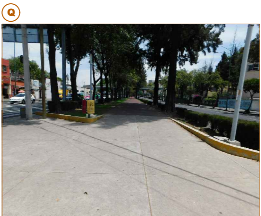
CAMBIO DE PISO EN ÁREA DE CORREDORES, COMIENZA CON CONCRETO Y CONTINUA CON PISO TIPO TARTÁN.
