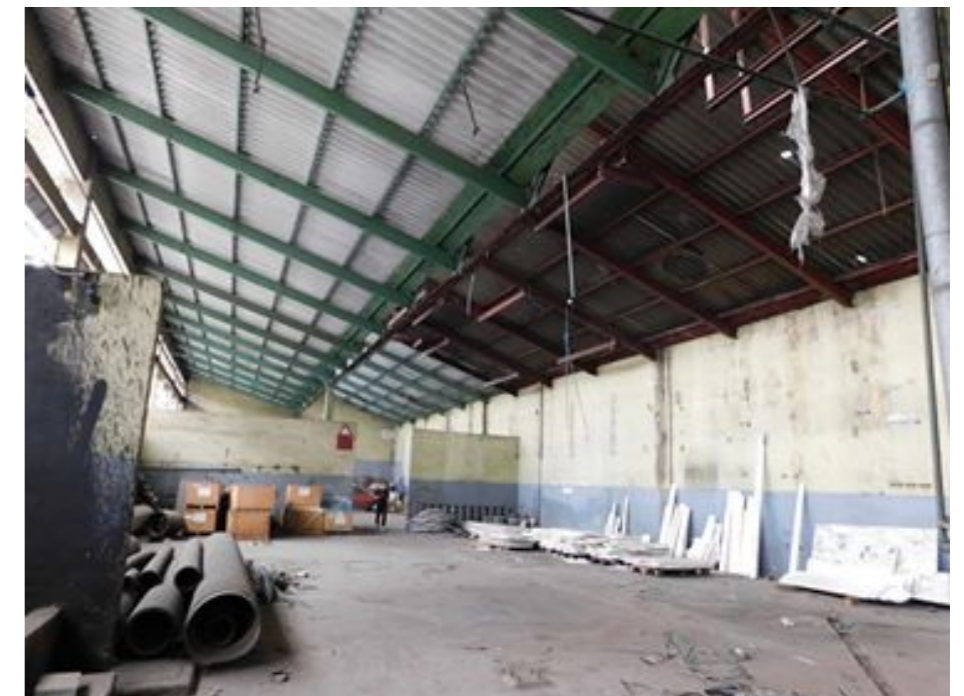
Ilustración 62: Vista interior del galpón. Fotografía del autor.
