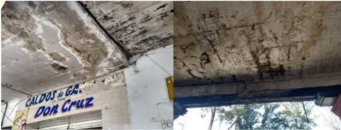
Ilustración 56 Lecho bajo de techumbre de concreto del portal. Fuente propia
