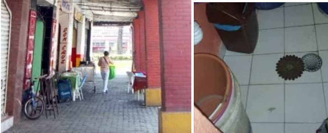
Ilustración 33, izquierda piso de adoquín en corredor poniente, derecha piso de loseta cerámica en sanitario de cocina
