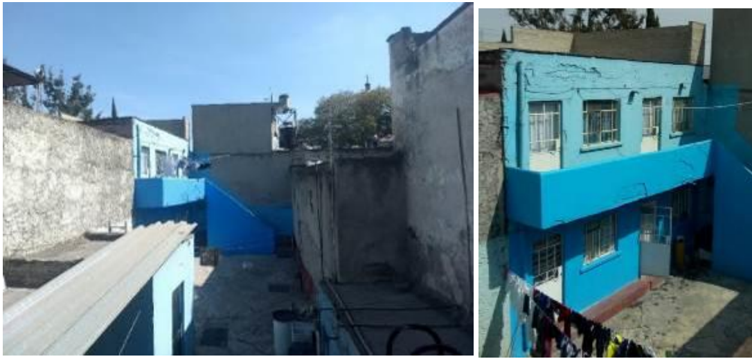
Ilustración 30 En la imagen izquierda, al fondo, del lado izquierdo se observa la construcción de 2 niveles, que son utilizados como departamentos (antes salones), al frente, del lado izquierdo está una bodega. El patio tiene un desnivel de 0.97m, los muros del lado derecho son de una mezcla de piedra, ladrillo y adobe, que fueron cubiertos por un aplanado de mortero y pintura vinílica. Imagen derecha: fachada de viviendas, (antes salones) se aprecia la herrería fabricada de ángulo metálico. Fuente propia
