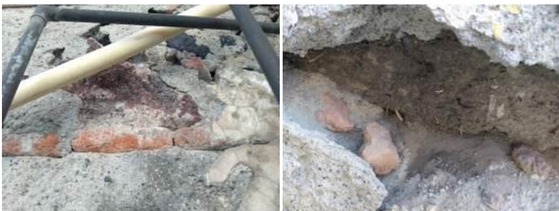
Ilustración 31 Muros de mezcla de tezontle y ladrillo con aplanado cemento-arena. Uso de adobe y arcillas en muro de módulo. Fuente propia.
