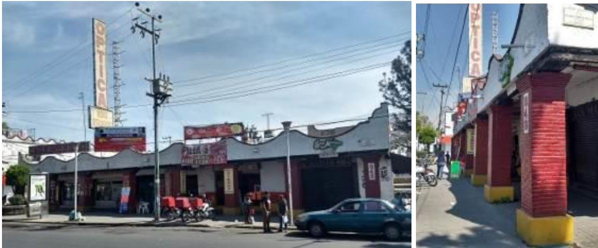
Ilustración 22 Fachada poniente sobre Av. Canal de la Vega. Fuente propia. En la imagen de la derecha Ilustración 23 se aprecia de cerca el sistema de soporte de la cubierta del portal, columna, zapata, viga y pretil. Fuente propia
