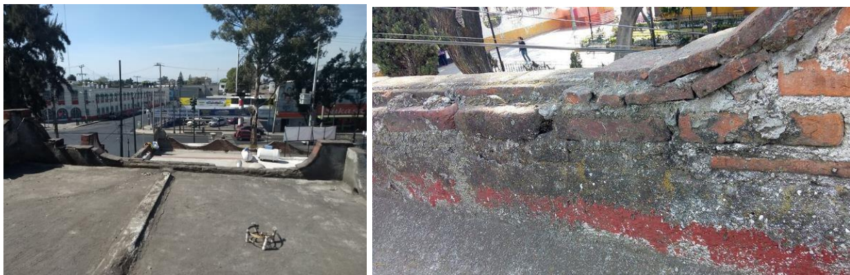
Ilustración 53 Azotea y cara interior de pretil. Fuente propia.
