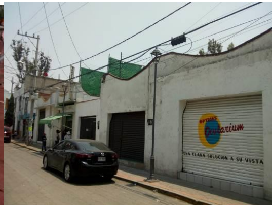
Ilustración 50 Fachada norte. Fuente propia.
