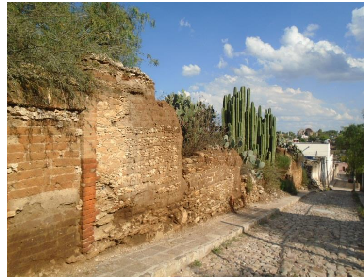
Calle Recreo con muros de adobe, Mineral de Pozos
