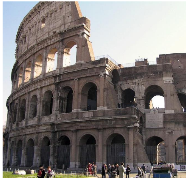
Contrafuertes del Coliseo construidos en Siglo XIX. Imágenes Calos Lozada (Twitter)
