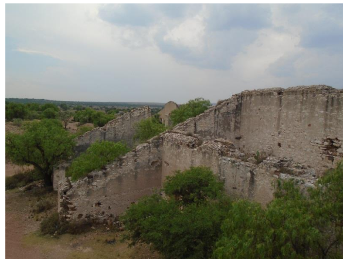
Edificio 1 y edificio 2 Santa Brígida Vista Suroriental
