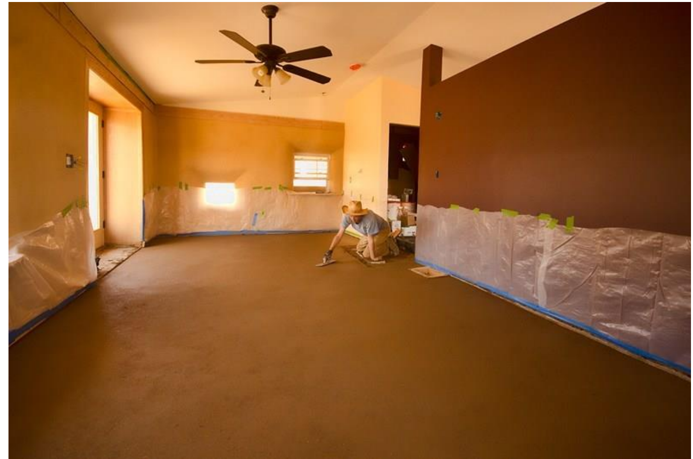
Imagen de acabado en piso de adobe. Fuente: https://elhorticultor.org/como-construir-un-piso-de-adobe/
