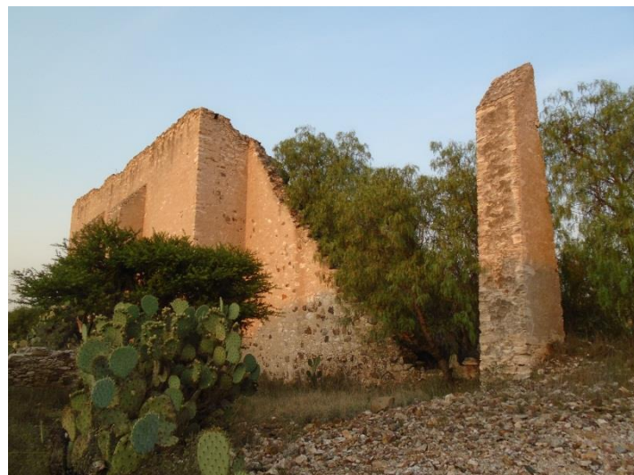
Edificio 1 y edificio 2 Santa Brígida Vista Norponiente
