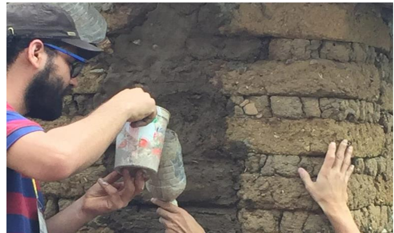
Inyección de lechadas de tierra, estabilizada con cal. Fuente fotográfica: Luis Guerrero
