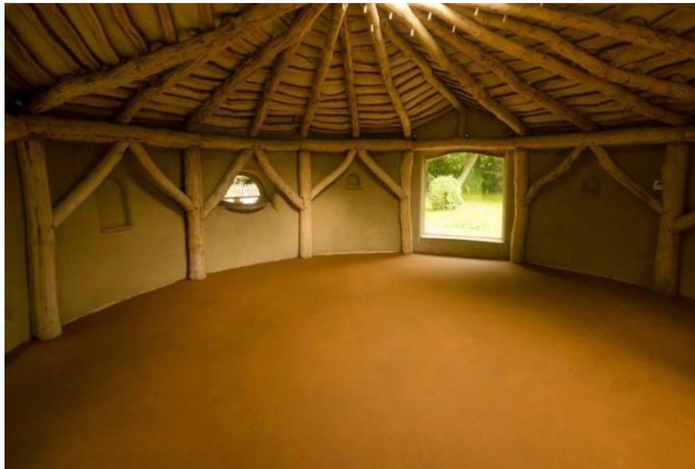
Imagen de acabado de adobe. Fuente: https://elhorticultor.org/como-construir-un-piso-de-adobe/
