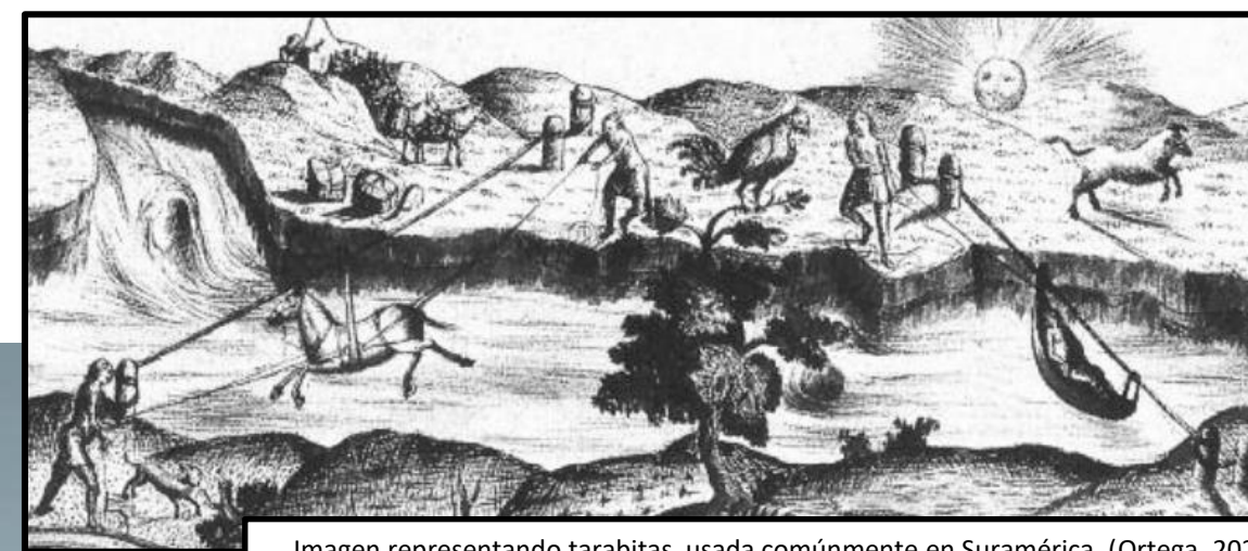
Imagen representando tarabitas, usada comúnmente en Suramérica. (Ortega, 2020)
