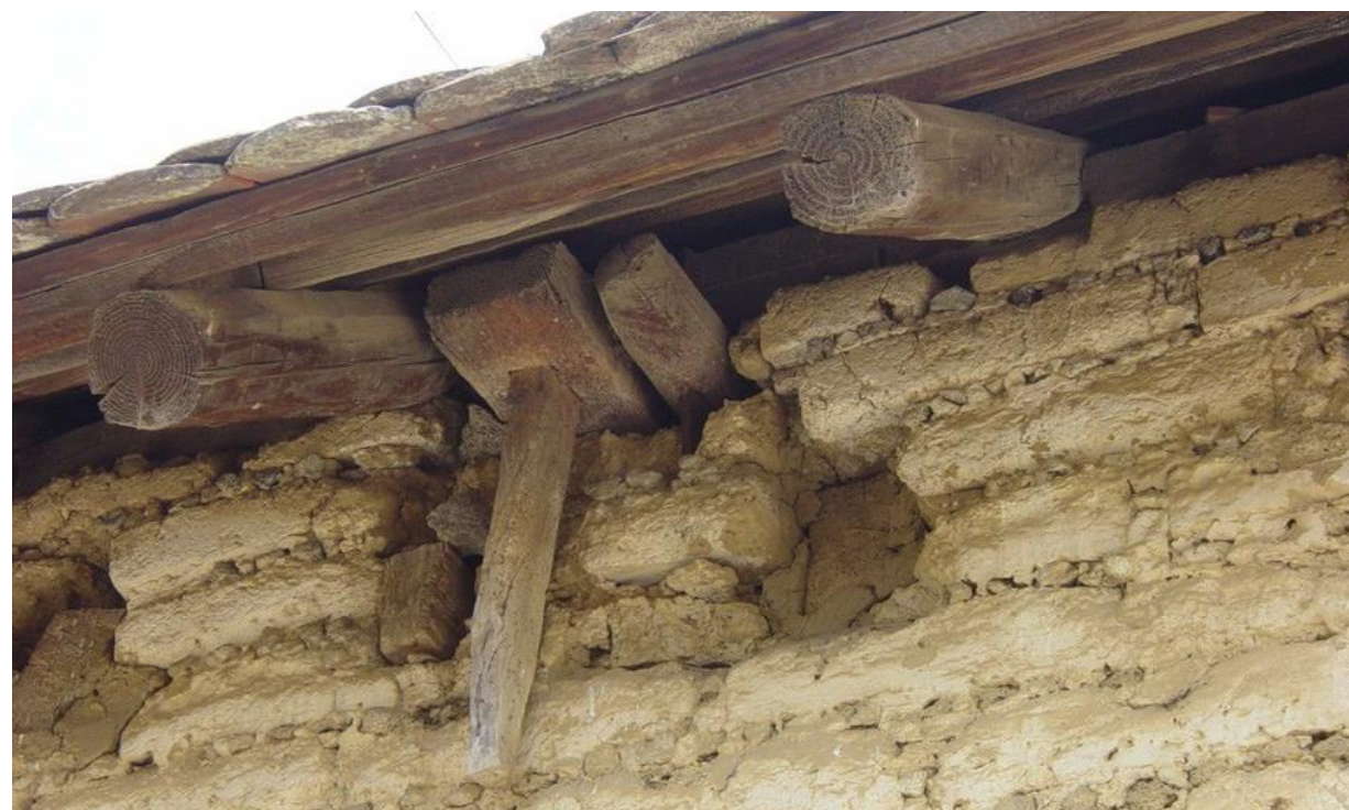
Anclaje de los tensores de madera. Ayapango, Estado de México Fuente Guerrero, 2007. p. 102.
