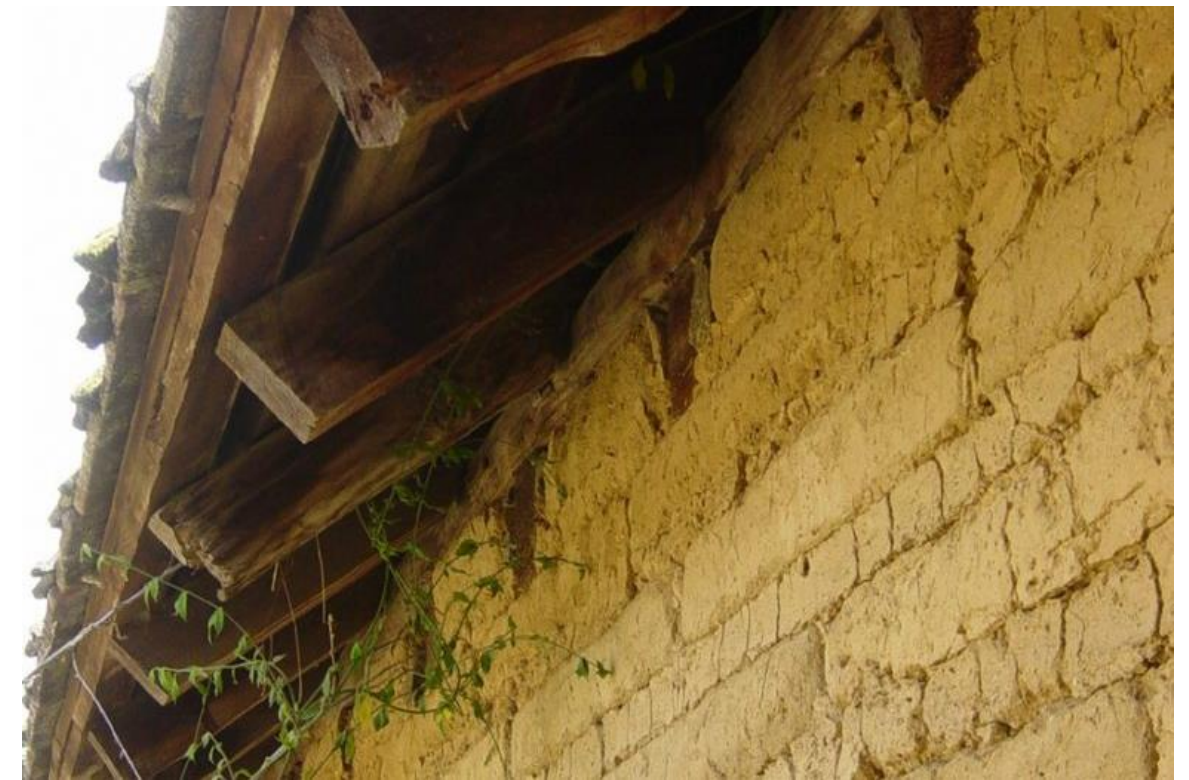
Vigas y tirantes que ligan los muros, Ayapango, Estado de México. Fuente: Guerrero, 2007. p. 105
