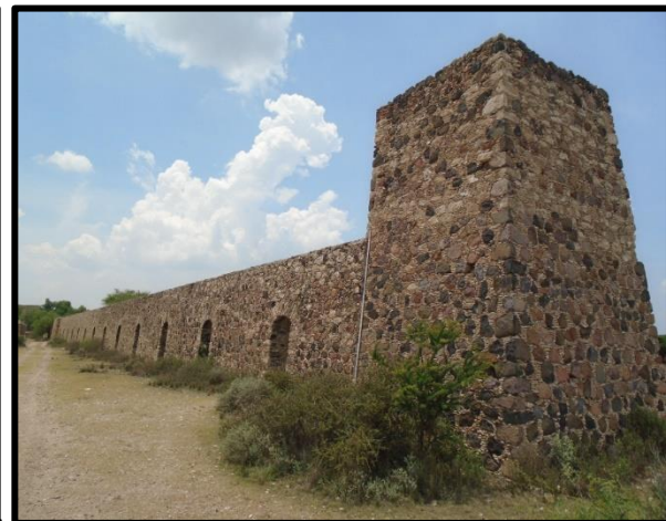
Túnel de Viento Santa Brígida
