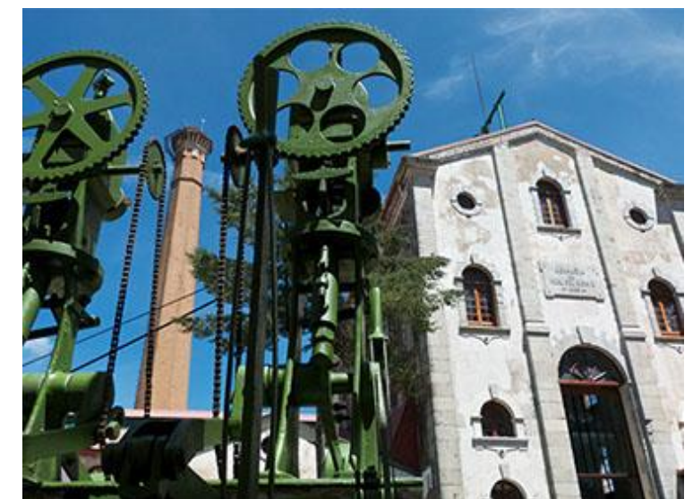
Casa de Máquinas La Dificultad, Espacio Intervenido, 2011 Fuente fotográfica: URL 2021, Real del Monte.
