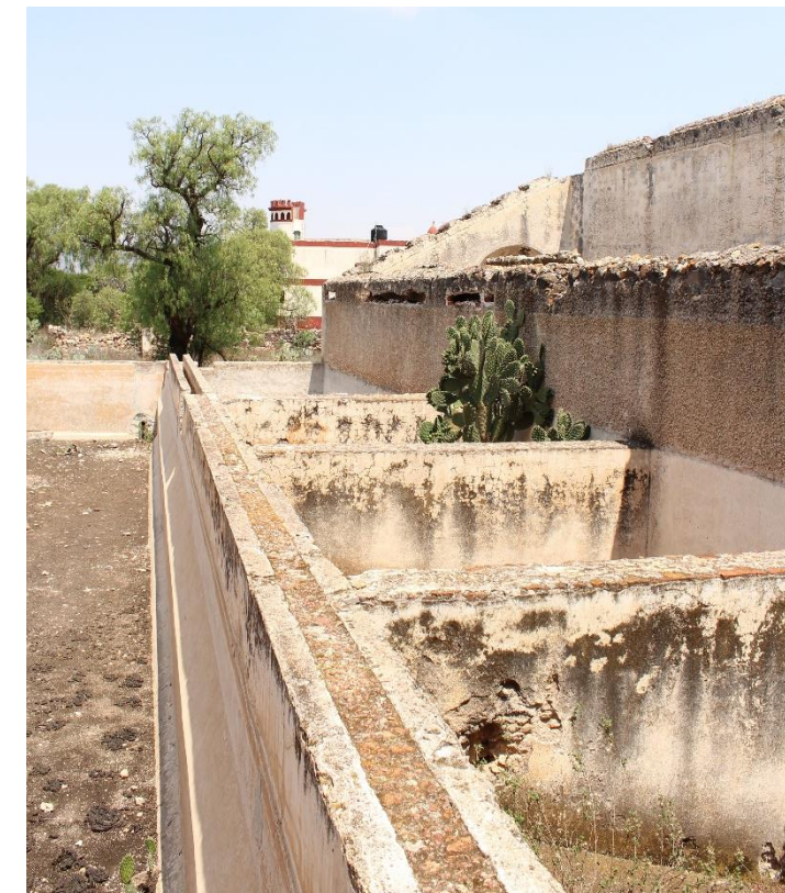
Tinas de lavado y/o cajones de buitrón en la hacienda de Santa Brígida. Fuente: Rodrigo Labastida
