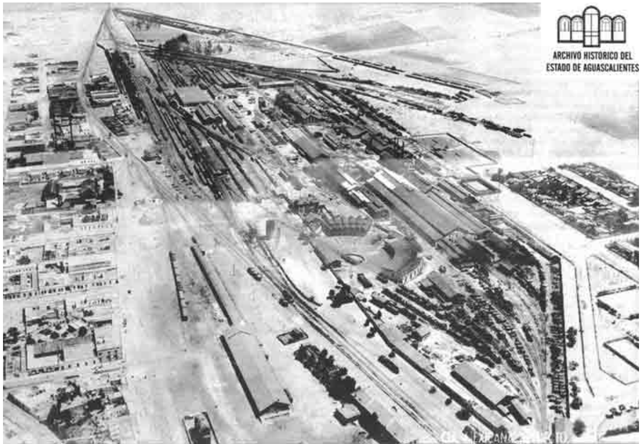
Figura No.140 Vista del conjunto de los talleres de Aguascalientes. Se pueden ver con claridad la magnitud de este conjunto ferrocarrilero. Del lado derecho los talleres de locomotoras y las viviendas de los trabajadores. Al centro la casa redonda, a la izquierda y al frente la estación y la bodega de carga Fuente: foto original del Archivo Histórico del Estado de Aguascalientes, la imagen publicada obtenida del Sitio web http://www.skyscrapercity.com
