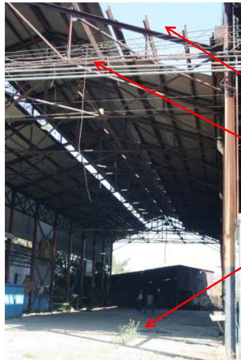
Figura 122. Vista del edificio de talleres desde la cara sur. Fuente archivo del autor
