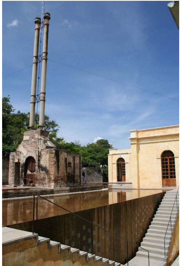
Figura 73. Detalle de vestigios de la antigua caldera sobre un espejo de agua habilitado en el módulo de sanitarios. Centro de Artes CASA, San Agustín Etlá, Oaxaca, Fuente archivo del autor.
