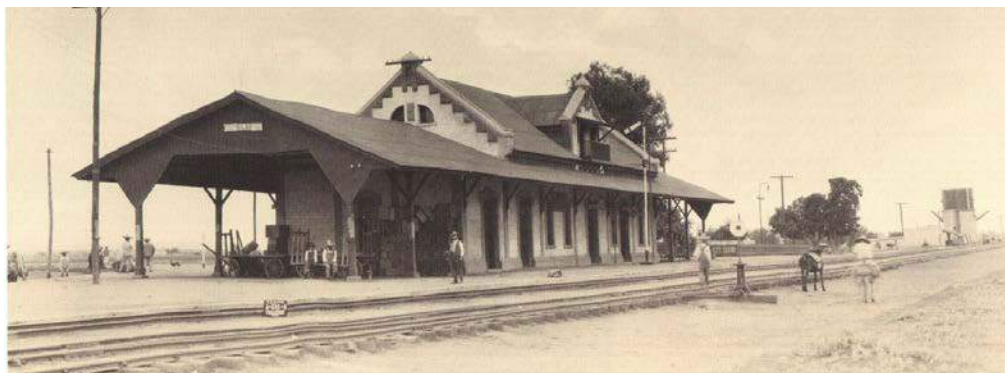
Figura 42. Estación de Silao, Guanajuato. Fuente SCT, de las Estaciones, México, 1996, p.86
