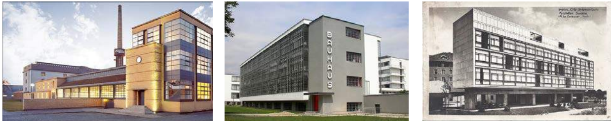
Figura No.35 De izquierda a derecha la fábrica Fagus Werk, el edificio de la Bauhaus de 1911 y 1926 ambos edificios diseñados por Walter Gropius. Por último el pabellón suizo de la Universidad de París de Le Corbusier, edificio de 1933. Fuente sitios web: http://www.unesco-welterbe.de , http://cae2k.com y http://www.archdaily.mx
