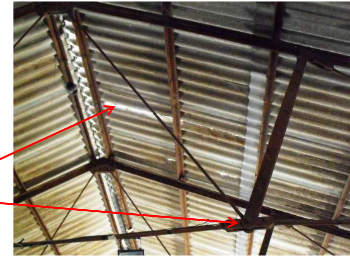
Figura 117. Armadura al interior del edificio de la antigua bodega de carga. Fuente archivo del autor
