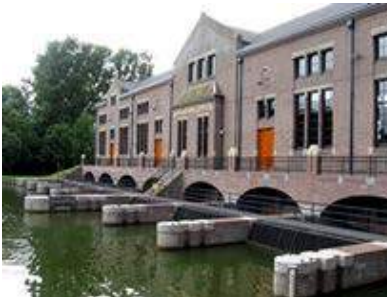
Estación de bombeo de Wouda
