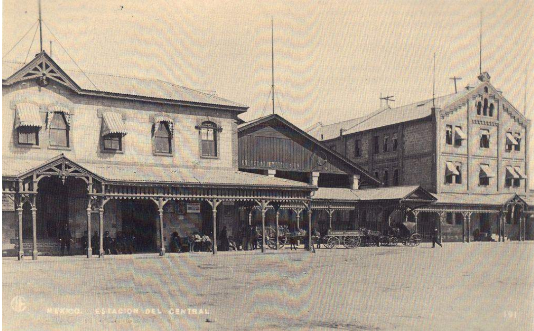
Figura 43. Terminal del Ferrocarril Central en la Ciudad de México. Fuente: SCT, de las Estaciones, México, 1996 , p.26. Se trata de una estación terminal cuyo programa es de los más vastos y complejos. Pueden observarse tres tipos de edificios de acuerdo con su función, el administrativo, el gran cobertizo al centro y la estación a la derecha. Son elementos comunes los alerones que se constituían como pasos a cubierto y andenes.
