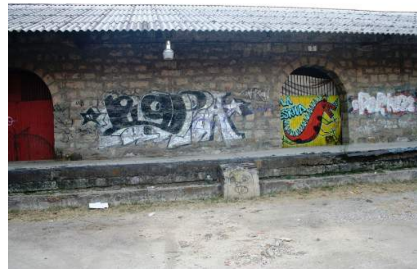
Figura 118. Este es otro ejemplo de pintura mural grafiti, sin embargo el resultado no es tan afortunado y no se tuvo la previsión de disponer de una base de aplanado y se ha pintado directamente sobre la piedra. Muy probablemente se trate de vandalismo. Fuente archivo del autor
