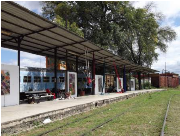
Figura 83. Vista del andén desde el patio de vías al interior del conjunto ferroviario. Fuente archivo del autor
