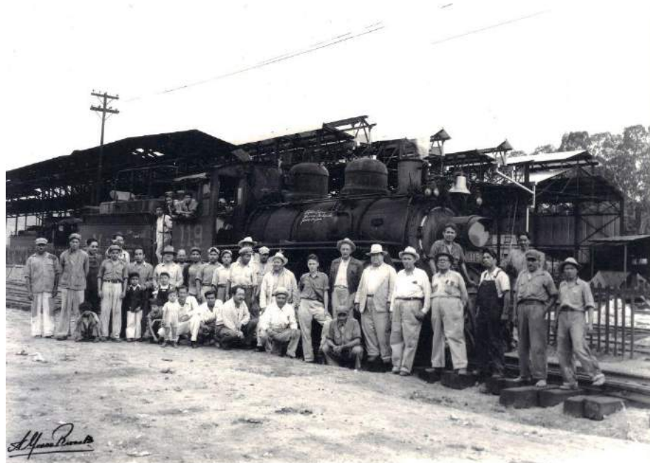
Figura 60. Los trabajadores de la estación posando junta a la locomotora 119. Al fondo los cobertizos con sus dos cuerpos característicos y un tercero a la izquierda, seguramente más antiguo el cual ya no existe. Es muy probable que fuera tomada después del cambio del ensanchamiento de las vías en el año del 52. Algunas láminas del cuerpo oeste (derecha de la foto) se ven nuevas y en proceso de techado los lucernarios. Fuente: colección Foto Rivas.
