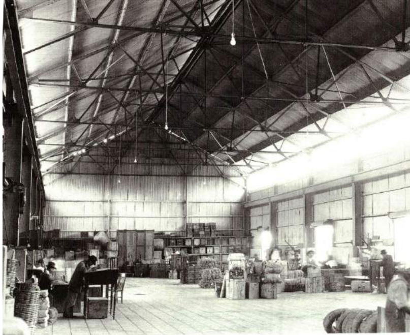
Figura 51. Bodega del servicio expreso de la estación Colonia en la Ciudad de México. Fuente: SCT, Caminos de Hierro, México, 1996, pp.116 Las bodegas junto con el edificio de la estación, los talleres y el patio de vías se constituyen en los elementos conformadores del espacio ferrocarrilero.
