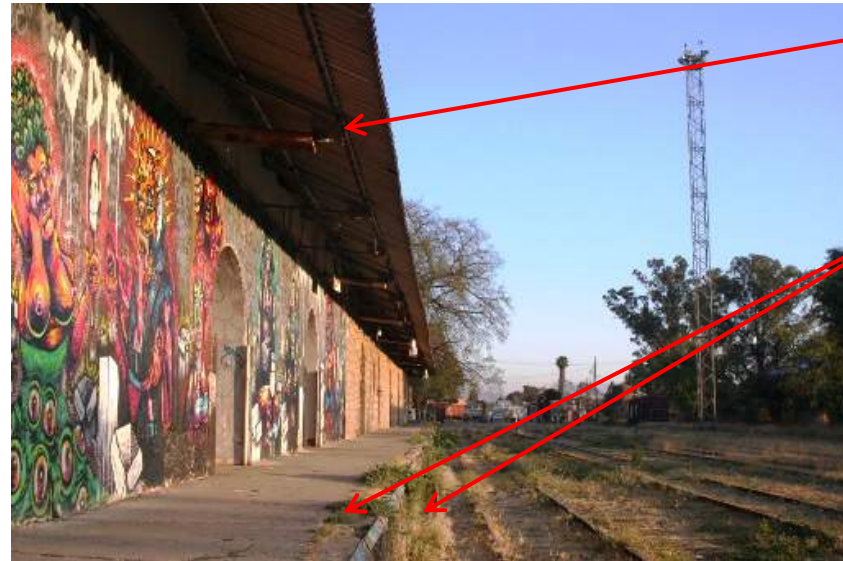
Figura 116. Fachada suroeste, vista desde el norte. Fuente archivo del autor
