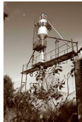
Figura 165. Este silo de arena, así como algunos vagones, tanques e inclusive una maquina diésel son parte del patrimonio industrial del conjunto. Fuente archivo del autor
