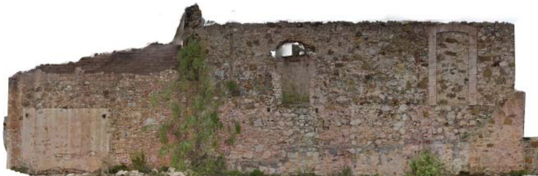
Fachada obtenida mediante el método de fotogrametría del edificio habitacional. Elaboración propia.
