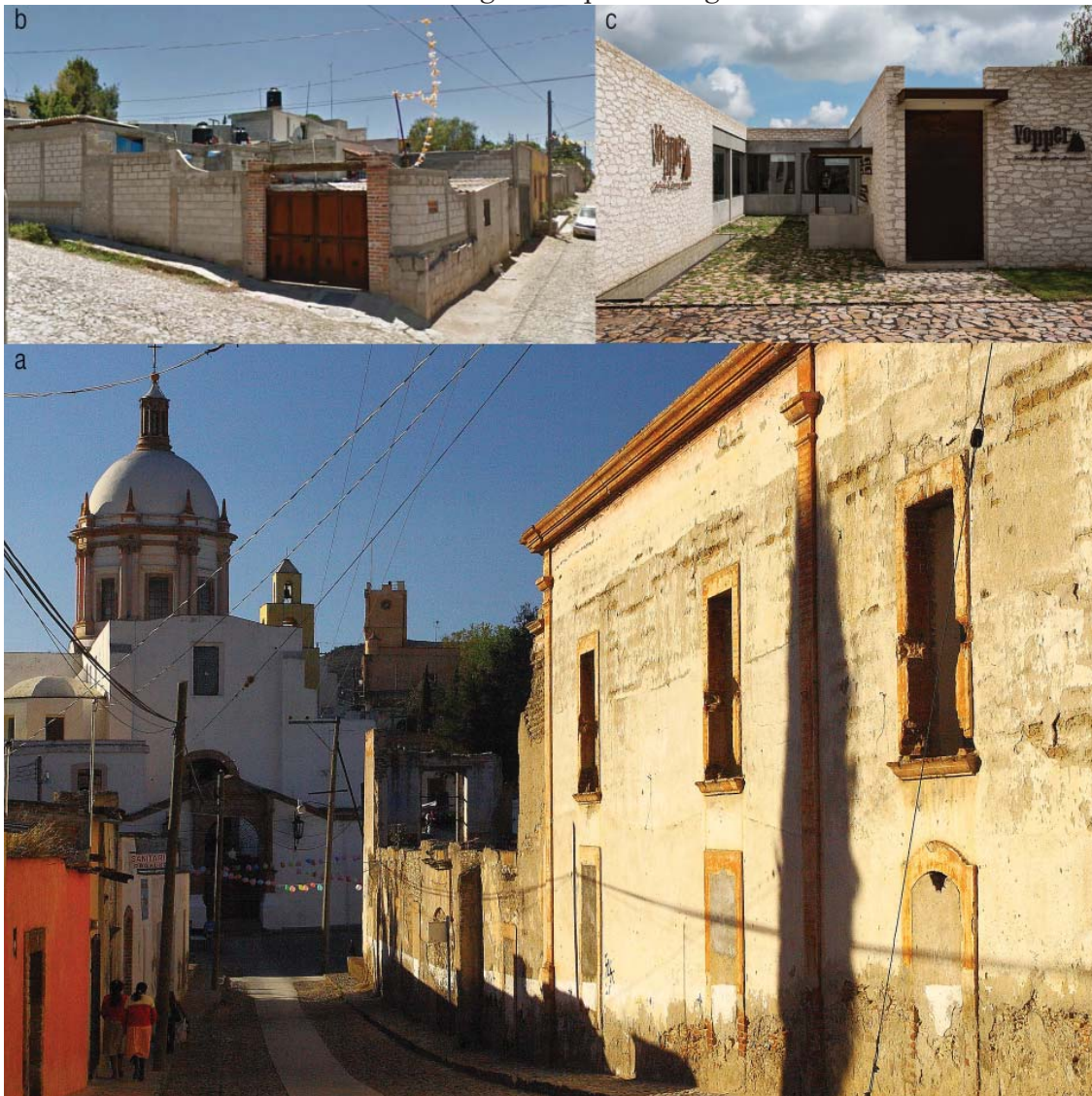
Ejemplos de catalogación de sistemas constructivos existentes en Pozos. Fotografías por: a. Roman Korzh, b. elaboración propia, c. Jean Paul Bergerault
