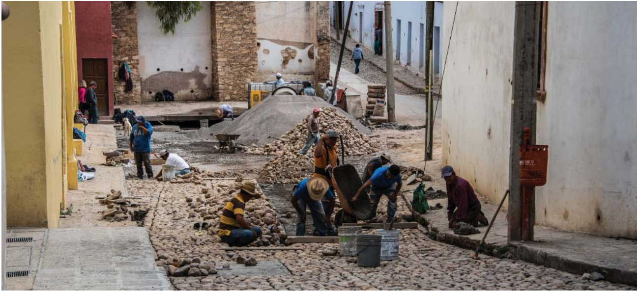
Reparación de calle en Pozos con el uso tradicional del cuarzo como divisor de carriles. Ted McGrath 2016.
