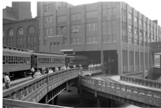
Las vías en funcionamiento circa 1950. Estadografía de la colonización de la Biblioteca Pública
