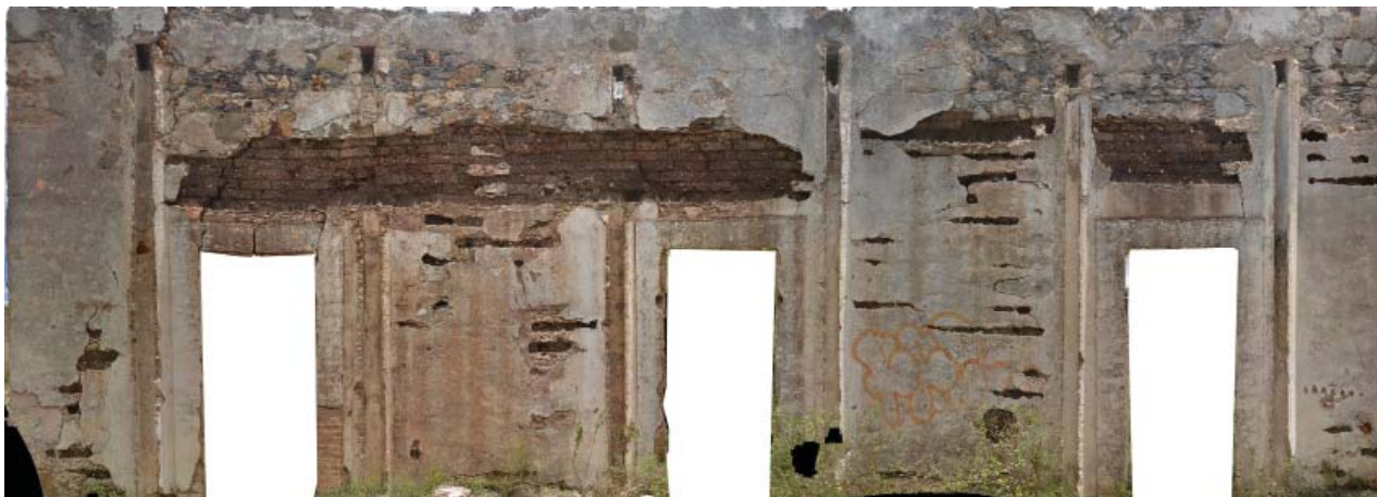
Fachada obtenida mediante el método de fotogrametría del edificio habitacional. Elaboración propia.
