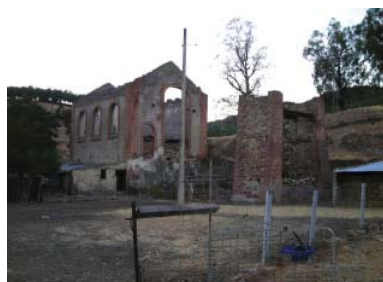
Análogo Casa de Máquinas en Horcajo, Argentina. Fuente: https://www.verpueblos.com/castilla+la+mancha/ciudad+real/minas+de+horcajo
