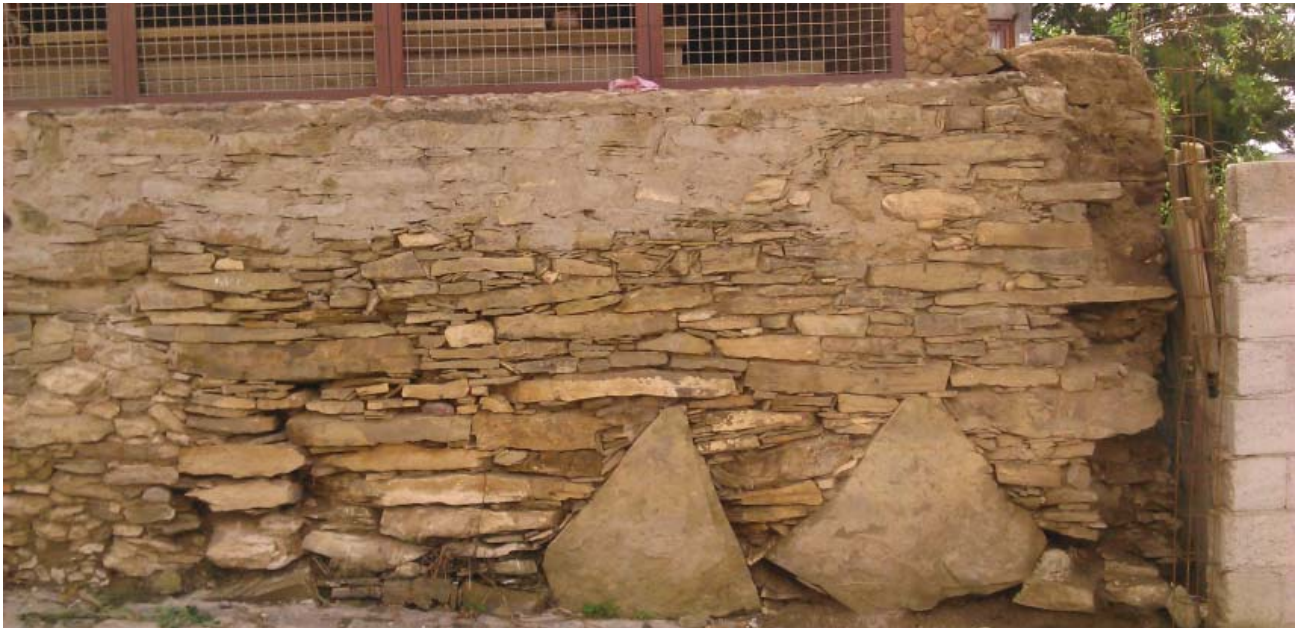
Ilustración 2 Mampostería de piedra caliche en lajas superpuestas sin junta aparente. Fotografía propia
