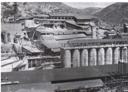
izquierda: tanques del Sistema de Cianuración Hacienda de Beneficio Loreto, Pachuca, Hidalgo. Fuente: http://pachucaconociendomiciudad.blogspot.mx/
