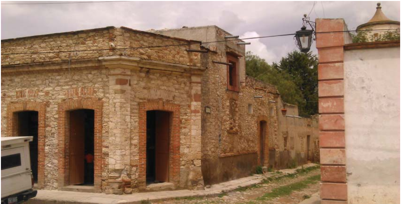
Ilustración 3 mampostería de piedra caliche enripiada con rajuela y junta de mortero e cal arena. Fotografía propia
