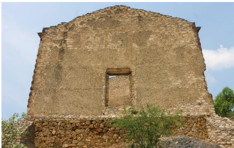
Ilustración 52. Fachada posterior donde se aprecia la cimentación de mampostería expuesta y contrafuertes de piedra caliche. Fuente: Autor, marzo 2016.
