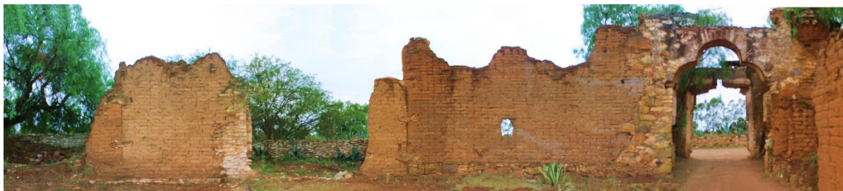
Ilustración 44. Fachada norte. Larguillo fotográfico tomado desde el interior del conjunto. Fuente: Autor, junio 2016.
