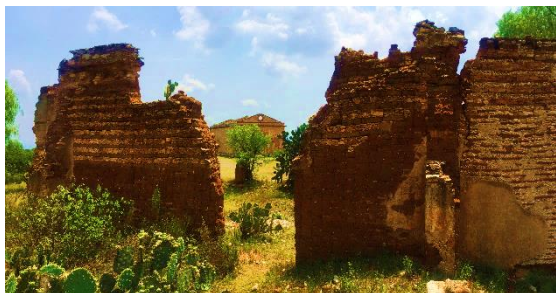
Ilustración 46. Vista interior de muros. Fuente: Autor, junio 2016.
