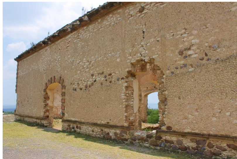
Ilustración 51. Vista de fachada lateral poniente. Fuente: Autor, marzo 2016.
