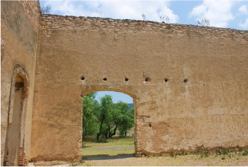
Ilustración 39. Vista de mechinales para posible tapanco localizados en interior. Fuente: Autor, marzo 2016.
