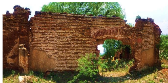
Ilustración 47. Detalle de muro en vista interior. Fuente: Autor, junio 2016.
