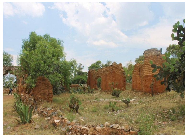
Ilustración 56. Estado actual del conjunto administrativo, no se encontraron vestigios de pisos originales.
