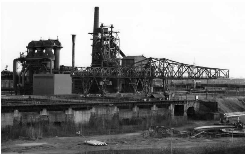
Ilustración 2. La antigua planta industrial aún en funcionamiento. Fuente: http://en.landschaftspark.de/the-park
