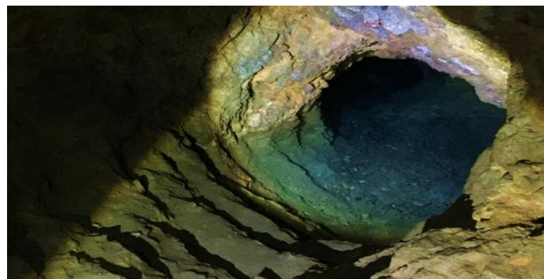
Ilustración 49. Vista interior del túnel de mina inundado. Fuente: Autor, marzo 2016.
