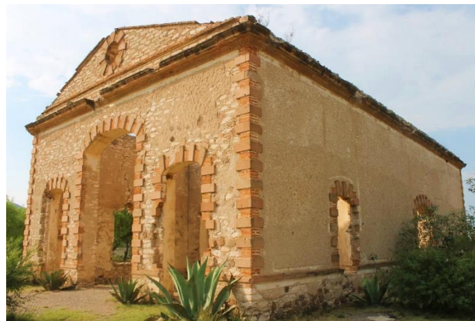
Ilustración 36. Fachada principal del antiguo Edificio de Máquinas. Fuente: Autor, marzo 2016.
