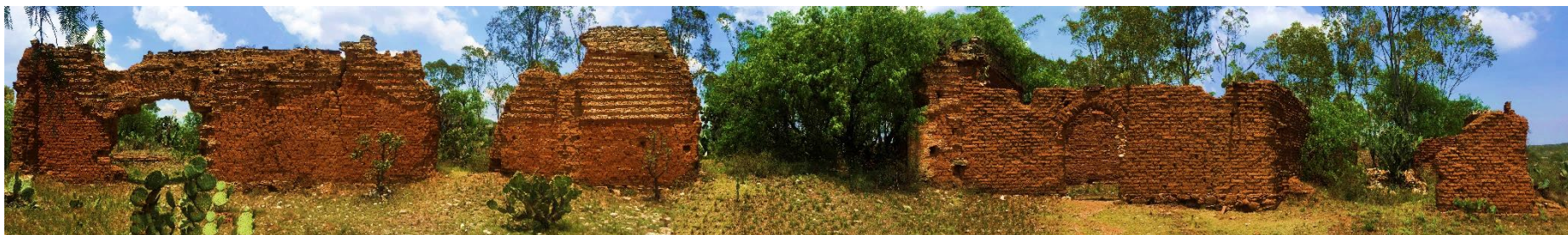
Ilustración 45. Fachada lateral. Detalle de muros de adobe con reparaciones hechas a base de piedra con técnica de rajueleado. Fuente: Autor, junio 2016.
