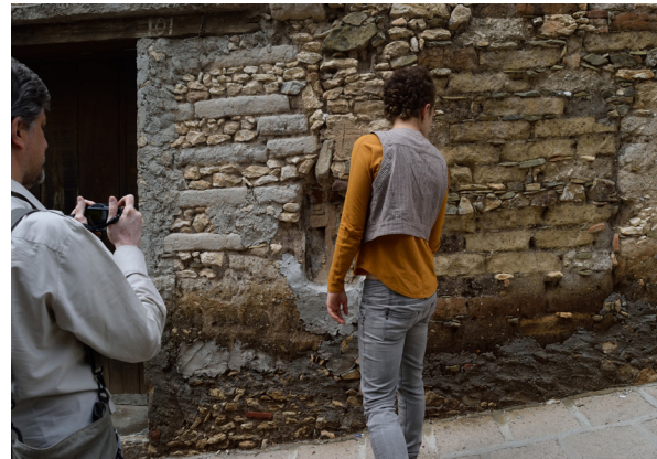
(fotografía 54: Daniel Vargas) (Mineral de Pozos 2016) (Colección personal) Vista de intervenciones en fachadas en Mineral de Pozos.
