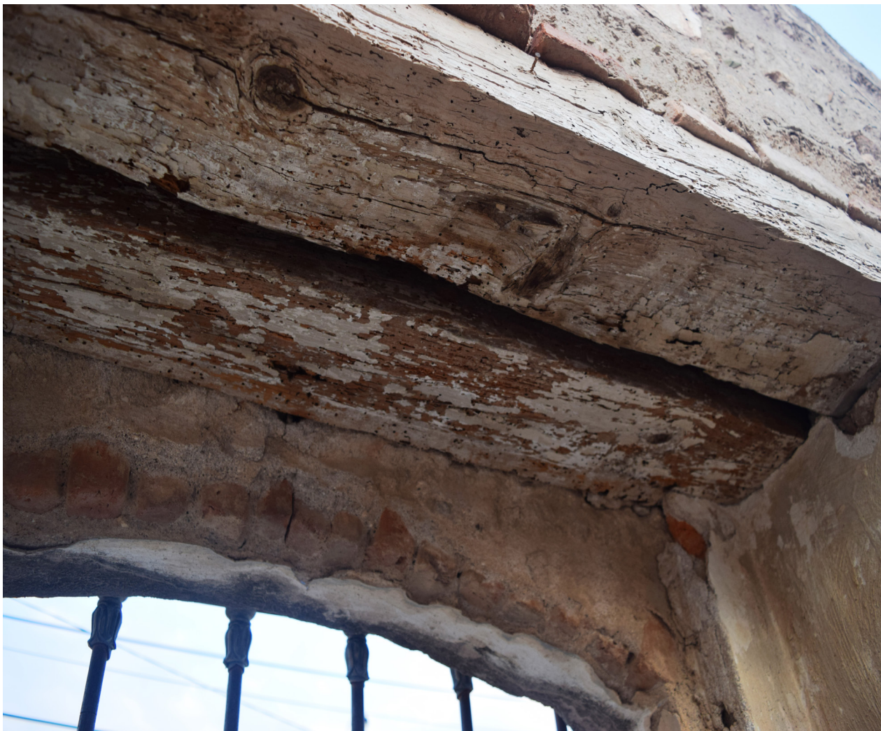
(fotografía 102: Daniel Vargas ) (Mineral de Pozos 2016)detalle de soportes de madera existente.
