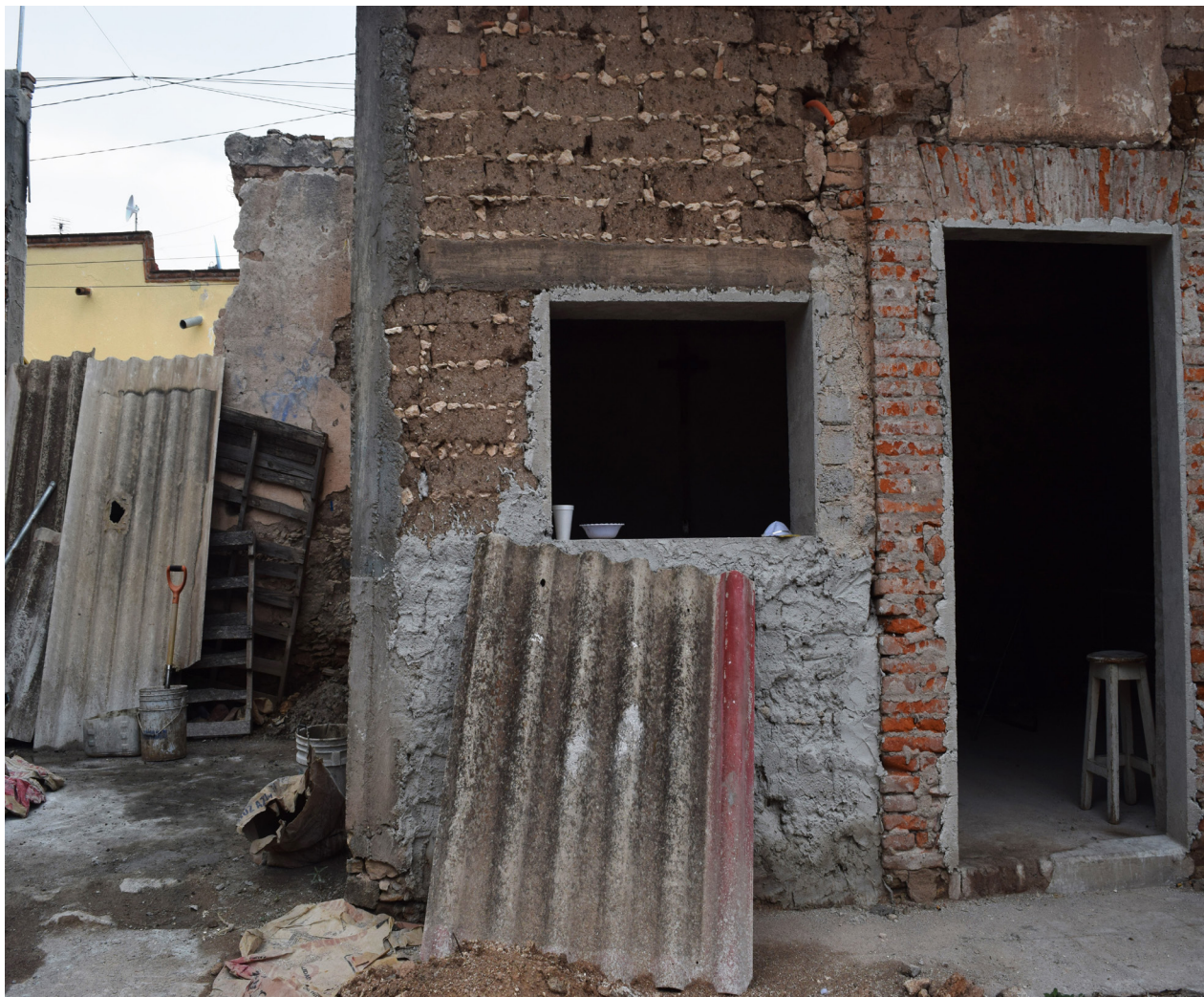
(fotografía 78: Daniel Vargas) (Mineral de Pozos 2016) (Colección personal) Interior del predio de estudio Juárez No 6. en Mineral de Pozos. se observa integraciones ajenas al sistema constructivo tradicional.
