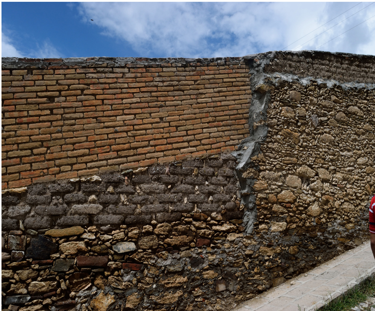
(fotografía 52: Daniel Vargas) (Mineral de Pozos 2016) (Colección personal) Vista de intervenciones en fachadas en Mineral de Pozos.
