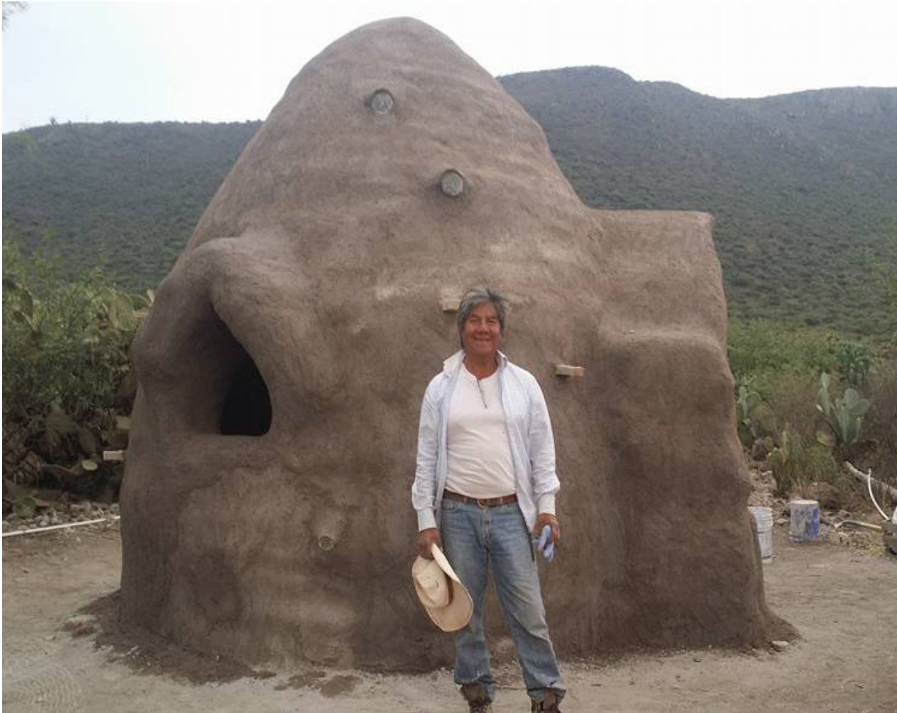
(fotografía 59: Daniel Valerio) (Mineral de Pozos 2016) (Colección personal) Cuarto de super adobe en Mineral de Pozos.
