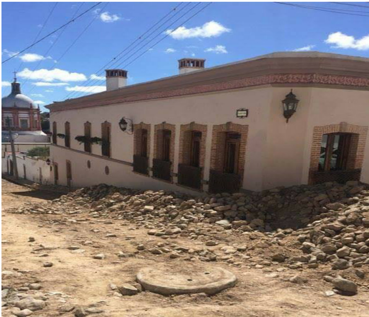
(fotografía 119: ) (Mineral de Pozos 2016) trabajos de pavimentos con materiales de la zona.
