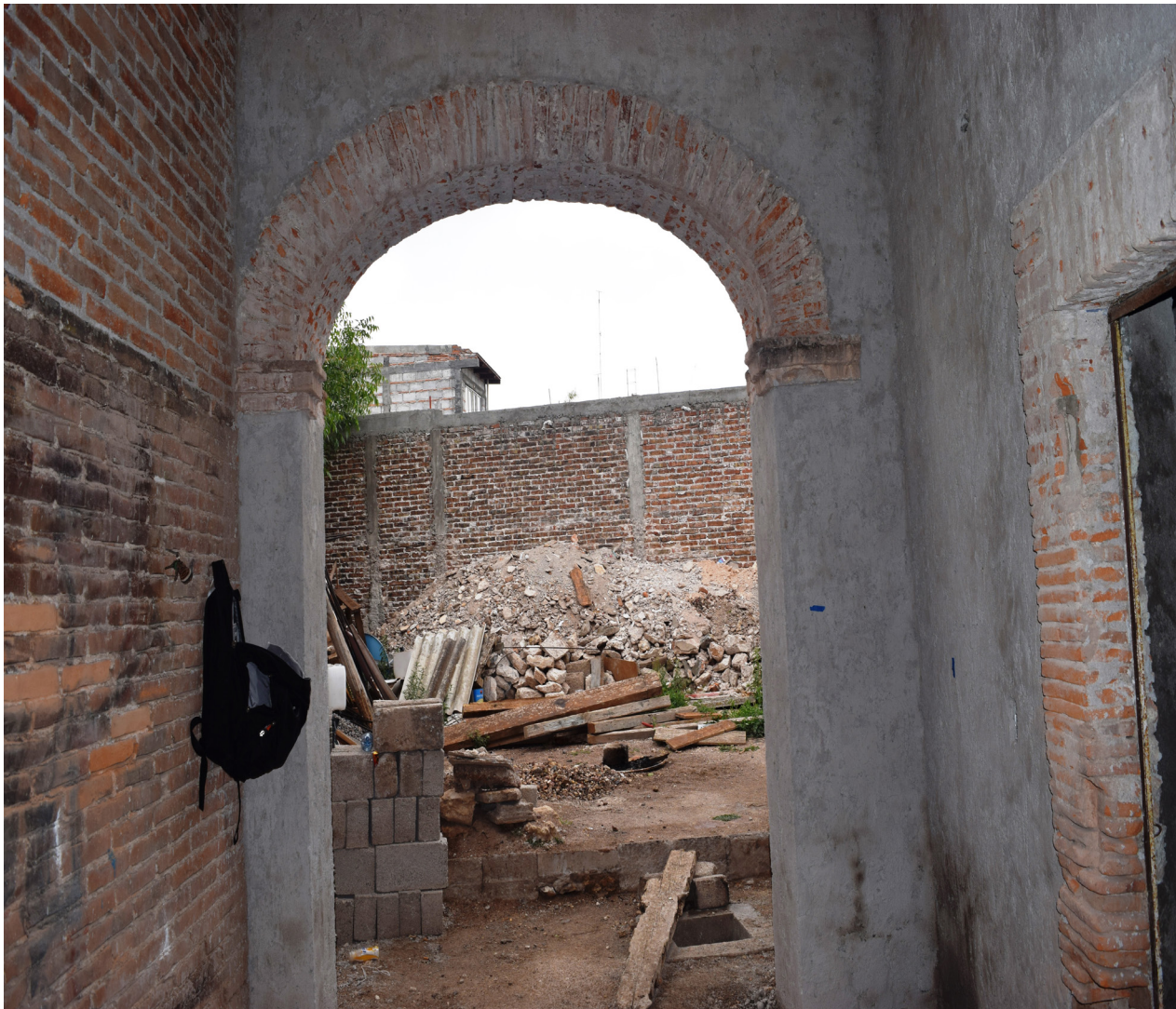
(fotografía 99: Daniel Vargas ) (Mineral de Pozos 2016) vestibulo de acceso principal.
