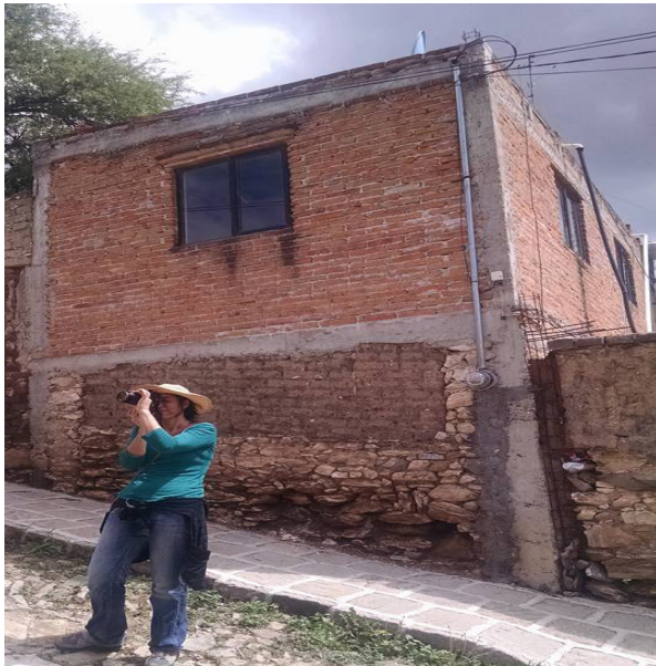
(fotografía 49: Daniel Vargas) (Mineral de Pozos 2016) (Colección personal) Vista de intervenciones en fachadas en Mineral de Pozos.
