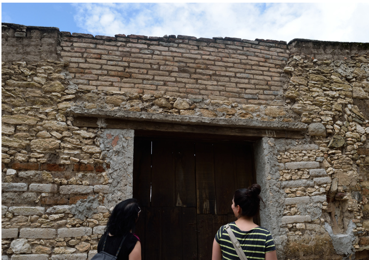
(fotografía 48: Daniel Vargas) (Mineral de Pozos 2016) (Colección personal) Vista de intervenciones en fachadas en Mineral de Pozos.
