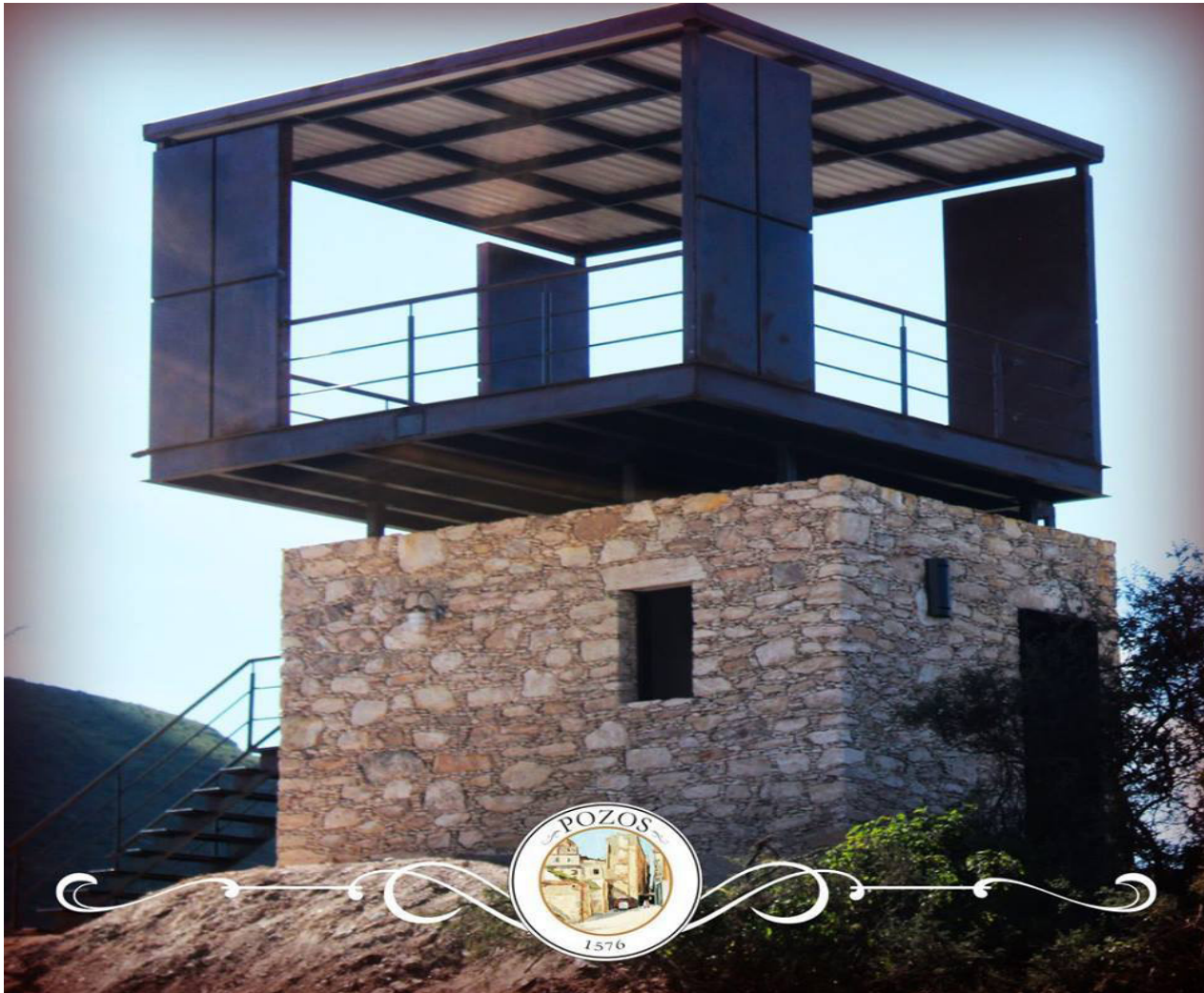
(fotografía 55: Página San Miguel de Allende Facebook) (Mineral de Pozos 2016) (Colección personal) Vista de nuevas integraciones Arquitectonicas en Mineral de Pozos.
