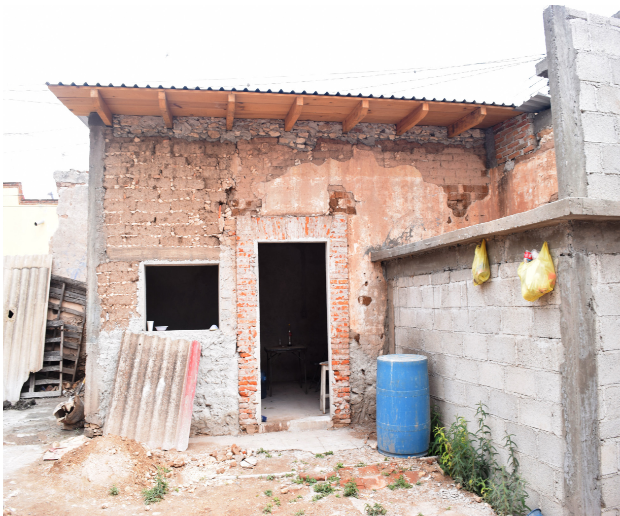
(fotografía 77: Daniel Vargas) (Mineral de Pozos 2016) (Colección personal) Interior del predio de estudio Juárez No 6. en Mineral de Pozos. se observa integraciones ajenas al sistema constructivo tradicional.
