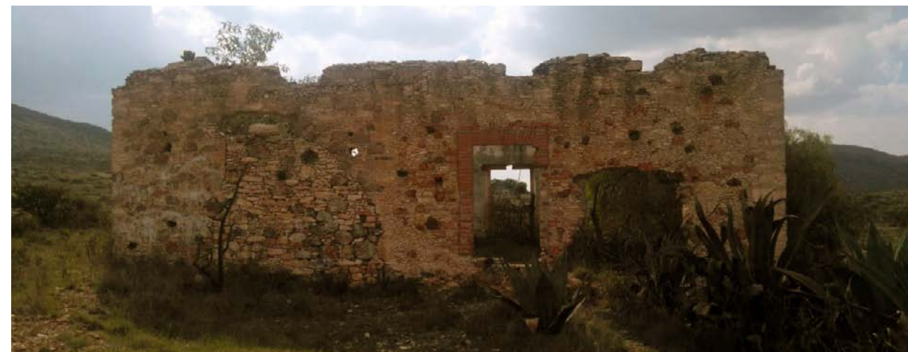
Fig.22 Fachada lateral surorientada
