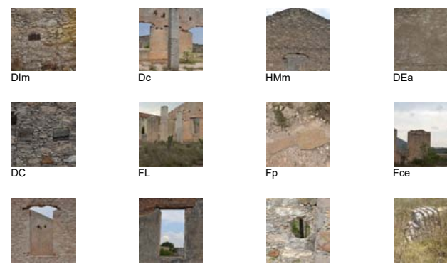
Fig.52 Simbología y paleta de imagenes de los daños y deterioros del edificio 6
