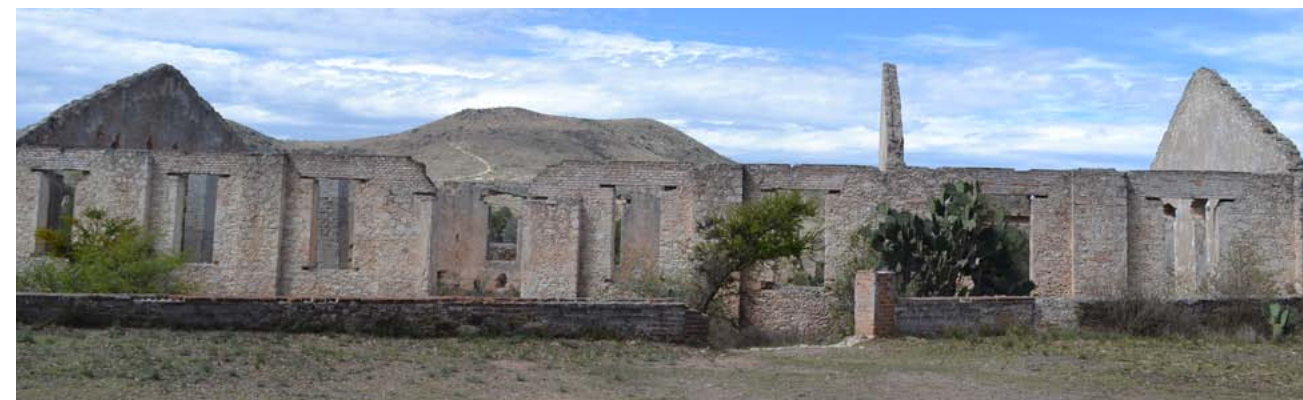
Fig.26 Fachada Sur del edificio 6.
