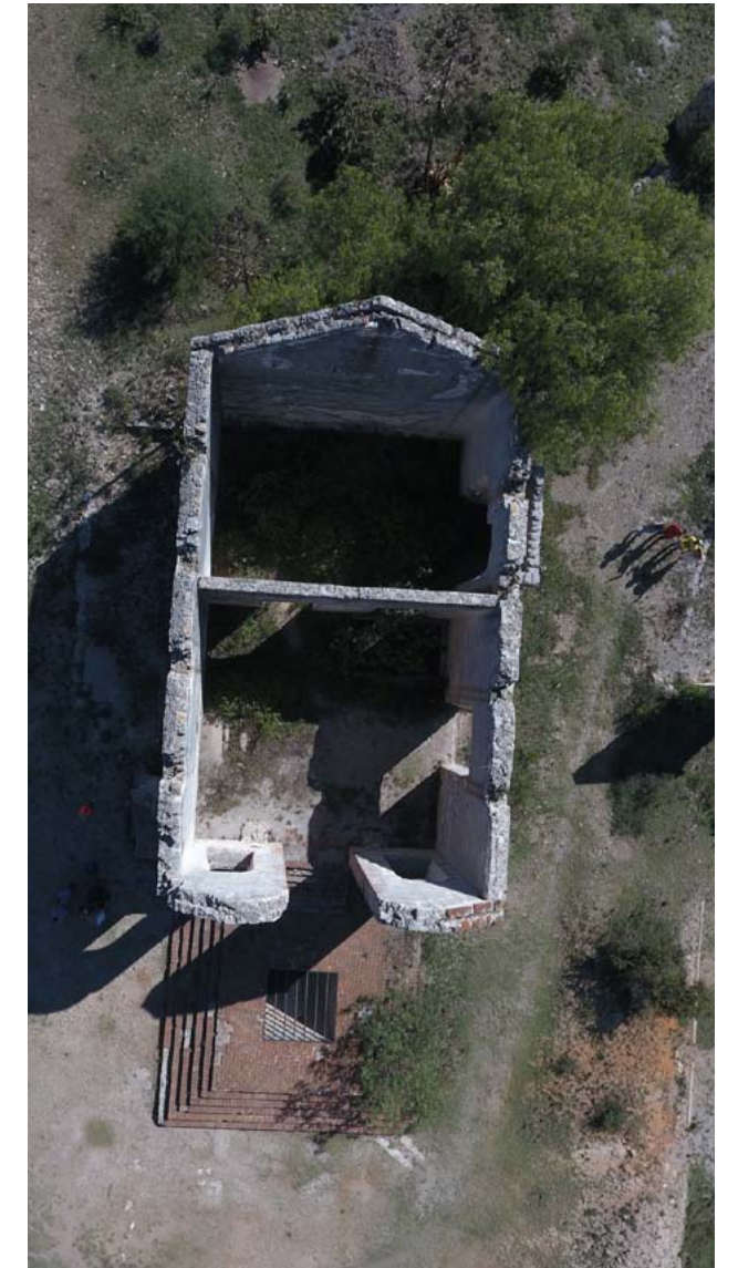
Fig.5 Vista aérea del estado actual de la antigua casa de extracción.
