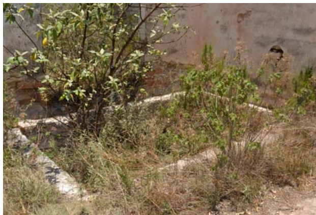
Fig.8 Detalles en el edificio 4
