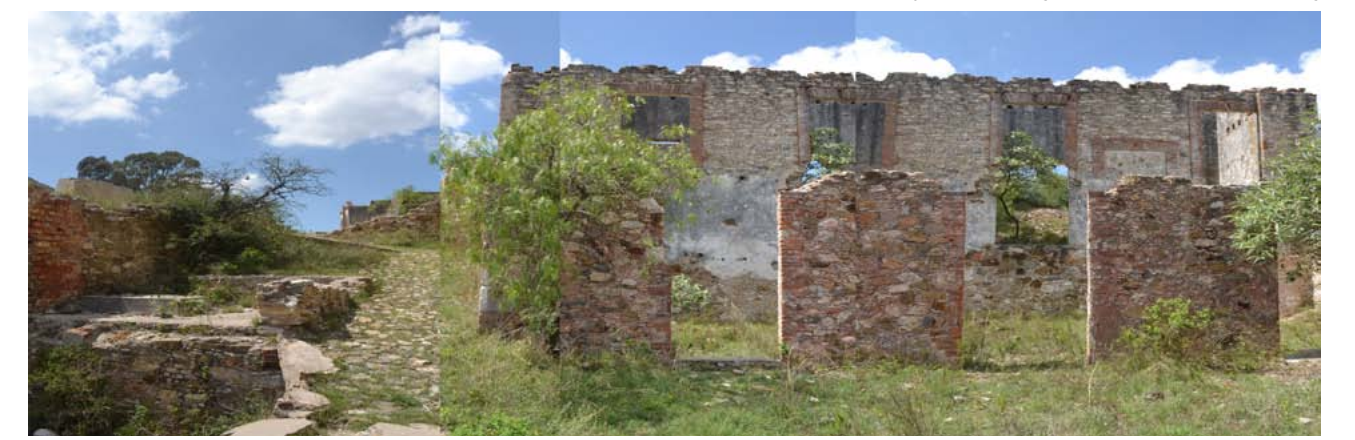
Fig.28 Fachada Norte del edificio 8
