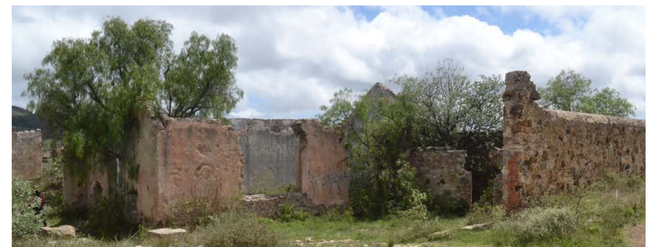
Fig.32 Edificio 13, crujía A y B.
