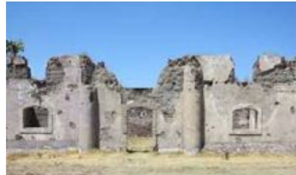
A. Vista actual de fachada principal
