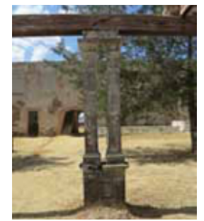
6. COLUMNA DE PIEDRA Columna pareada, sobre basamento de piedra. Soporte principal de las vigas
