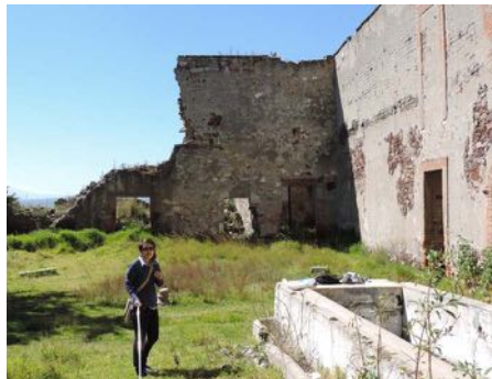
Figura 14. Fachada interior norte. Foto: A.R.E, 2013.
