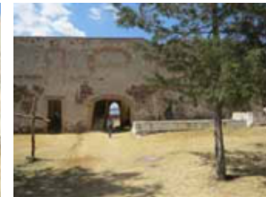
24. FACHADA INTERIOR Vista frontal de la fachada posterior. Detalles de ladrillo en marcos de puertas y ventanas
