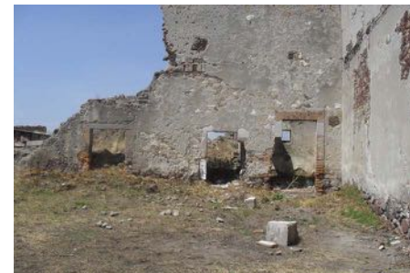
Figura 9. Fachada interior oeste. Foto: A.R.H, 2013.
