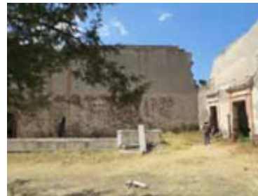
23. FACHADA INTERIOR Vista frontal de la fachada posterior. Detalles de ladrillo en marcos de puertas y ventanas
