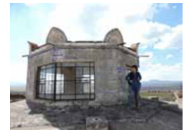
8. VISTA DEL REMATE DE LA CUBIERTA Corona del tinacal en buen estado
