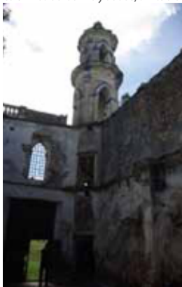
15. INTERIOR DE LA CAPILLA. Vista del interior hacia el exterior, se puede observar la torre donde estuvo la campana.
