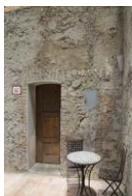
Restitución de algunos elementos para recrear los muros originales (temático).
