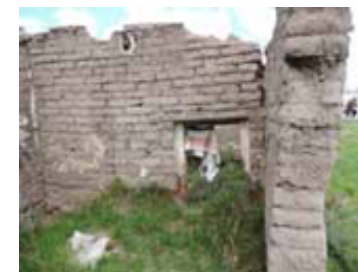
5. VISTA DE CUARTERÍA Muros incompletos y conexión entre habitaciones
