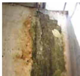
8. ESQUINA DE MURO INTERIOR DE FACHADA (B)
