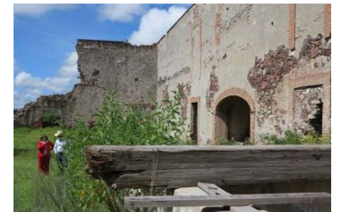
Figura 10. Vista interior noroeste. Foto: A.R.E, 2013.
