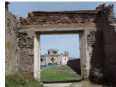
21. VISTA DEL EDIFICIO HACIA EL TINACAL Muros de adobe y piedra
