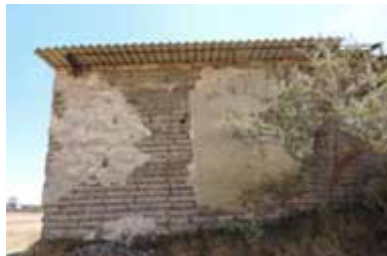
6. VISTA FRONTAL DE MURO POSTERIOR (C) Detalle de rejoneado
