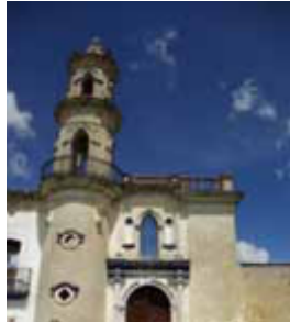
9. FACHADA DE CAPILLA La portada se conserva en buen estado.
