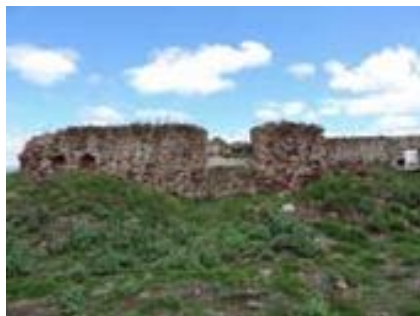
19. VISTA DEL MURO SUR Muros de piedra
