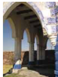
5. VISTA PÓRTICO Pórtico de acceso a tinacal
