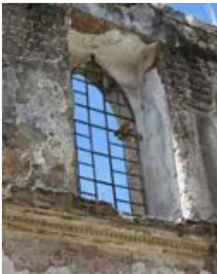
Figura 66. Vano ojival de la capilla ubicado en capilla de la Casa Grande. Fotografía: A.R.E, 2014.
