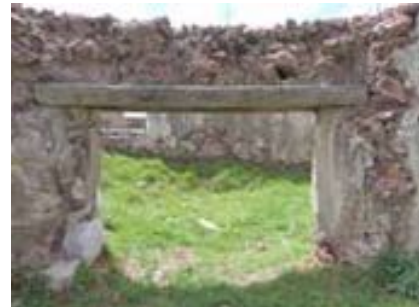
16. DETALLE DE VANOS Muros de piedra con dintel de viga de madera
