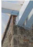
Colocación de cubierta apoyada en estructura a existente. Se dañan los muros y se reparan con tabique-cemento.
