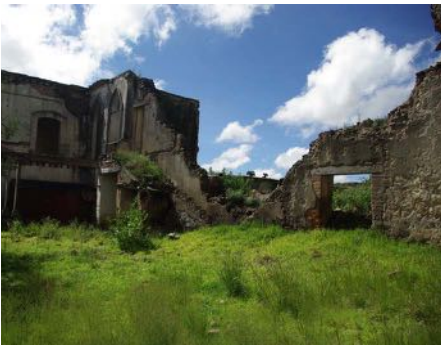
Figura 13. Fachada interior oeste. Foto: A.R.E, 2013.
