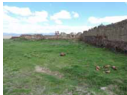
20. VISTA DE LA INTERSECCIÓN DE LOS MUROS SUR Muros de adobe con sobrecimientos de piedra
