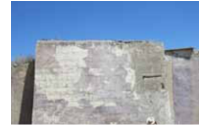
11. REFUERZO EXTERIOR EN FACHADA LATERAL (B-9)
