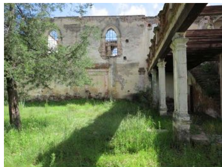
Figura 6 y 7 . Fachada interior norte. Fotos: A.R.E y A.R.H, 2013.
