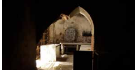
11. ALTAR DE LA CAPILLA Se habilitó como cocina para las reuniones de AA.
