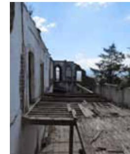
5. VISTA DESDE LA CAPILLA Restos del deambulatorio perimetral en primer nivel, construido en madera
