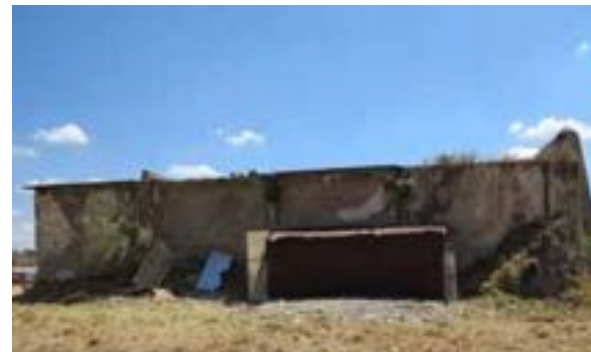
C. Vista actual de fachada posterior
