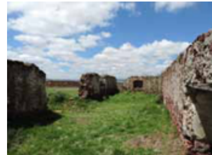
15. VISTA INTERNA DE CUARTERÍA Muros completos de piedra, vanos con dintel de viga de madera
