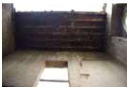
20. CUBIERTA Muros de tabique, repellado en arena-cal y cubierta de enladrillado
