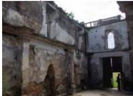
15. INTERIOR DE LA CAPILLA. Vista interior de la capilla.
