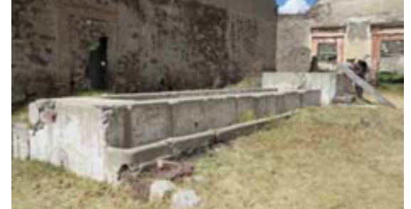
13. PATIO INTERIOR Aljibe de mampostería en uno de los extremos del patio
