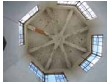
1. VISTA DEL INTERIOR DE LA CUBIERTA Cubierta octogonal de ladrillo
