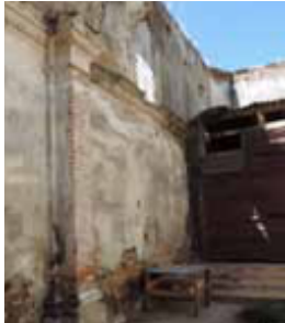
10. INTERIOR DE CAPILLA Columnas de ladrillo y adobe, sin cubierta
