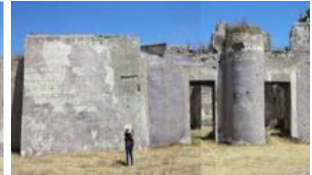
B. Vista actual de fachada lateral
