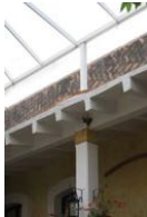
Colocación de cubierta apoyada en estructura existente.
