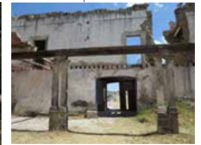
18. FACHADA INTERIOR Vista frontal de la fachada principal, presenta viguería incompleta y destaca la presencia de los mechinales
