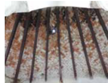
2. VISTA DE CUBIERTA DEL PÓRTICO Cubierta de terrado con vigería de madera
