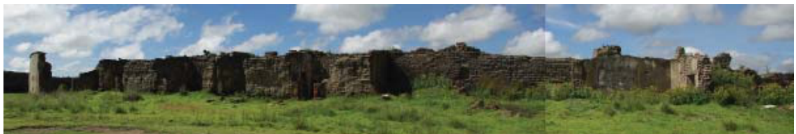
Figura 2. Vista general de la calpanería, Fotografía: A.R.H. 2015.
