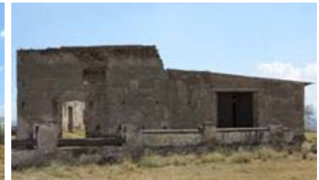
D. Vista actual de fachada lateral
