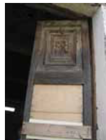
3. VISTA DE PUERTA Reparación temporal de puerta
