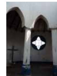
7. VISTA DEL INTERIOR Detalle de columnas y ventanas
