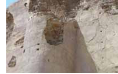
13. DETALLE DE PILASTRA EN FACHADA PRINCIPAL
