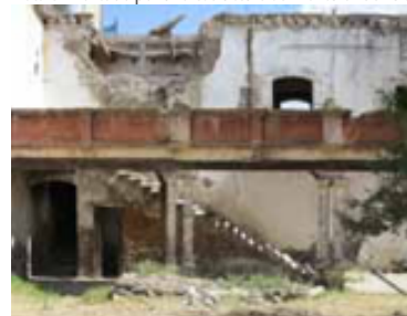
16. FACHADA INTERIOR Vista frontal de la fachada principal, actualmente todos estos locales han perdido la cubierta
