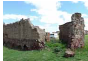
1. VISTA DE LA ESQUINA SUR Esquina incompleta sobre cimientto de piedra y muros de adobe
