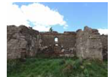
3. VISTA DE CUARTERÍA Muros de adobe con sobrecimiento de piedra
