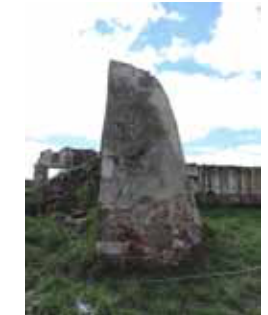
12. VISTA DE CONTRAFUERTE Elemento aislado de piedra
