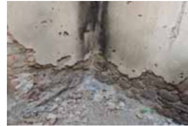
10. VISTA DE ESQUINA INFERIOR DE FACHADA POSTERIOR (B-C)
