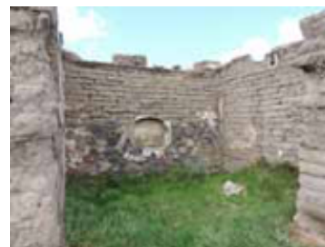
4. VISTA DE CUARTERÍA Muros en buen estado, sin cubierta
