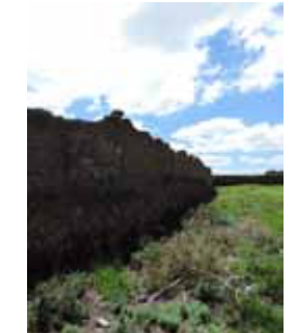
18. VISTA DEL MURO SUR Muros de adobe con sobrecimiento de piedra
