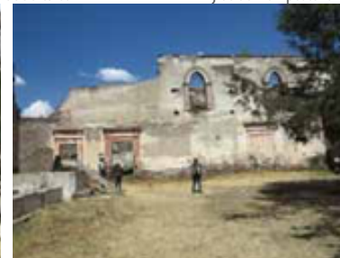
17. FACHADA INTERIOR Vista frontal de la fachada lateral derecha desde el patio interior. Muro de adobe con detalles en rajueleado
