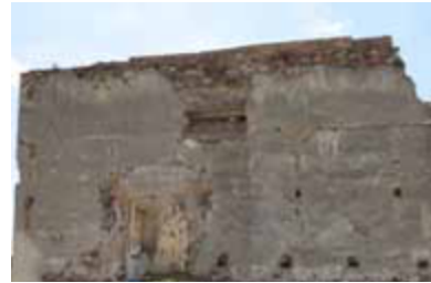
5. VISTA DE MURO DE FACHADA (D)
