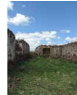
17. INTERIOR DE CUARTERÍA Muros de piedra y sin cubierta
