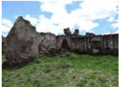
13. VISTA DE LA ESQUINA NORTE Contrafuerte y muros de piedra.
