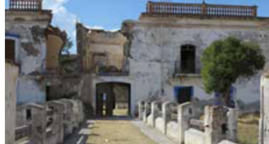
12. ACCESO PRINCIPAL A LA CASA GRANDE Está enmarcado por una estructura semicircular de 45cm. de altura.
