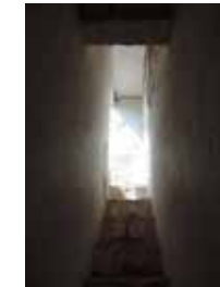
3. VISTA DE ESCALERA Acceso a azotea del tinacal
