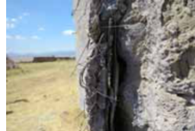
12. DETALLE DE MURO EXTERIOR EN FACHADA PRINCIPAL
