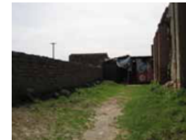
22. VISTA DEL EDIFICIO CON LA COLINDANCIA Construcción temporal de láminas de cartón
