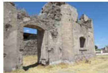
1. VISTA DE FACHADA Muros exteriores
