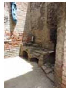
20. VISTA DEL INTERIOR DE CUARTO Muros de adobe y aldrillo, horno de piedra
