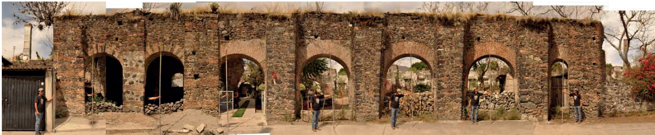
Fachada de arquería que da a la calle.
