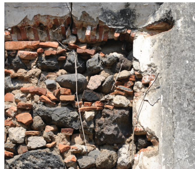
Figura 1.17 Detalle del vano tapiado en el muro norte del interior de la casa. Archivo fotográfico de Mariana Sainz 2014.
