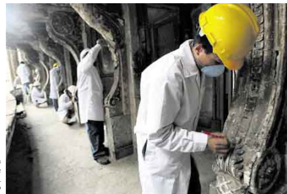
Toma de muestras estratigráficas para la restauración en el teatro municipal de Lima; ejemplo de restauración científica. Imagen de: temucl.blogspot.com
