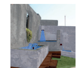
11. Reuso de cárcamos y acueducto
