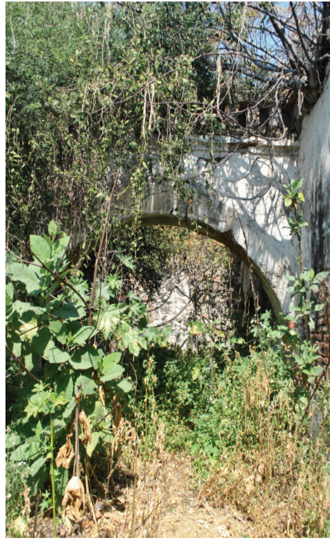
Figura 2.6 Detalle del crecimiento de plantas en el interior de los purgares. Archivo fotográfico de Mariana Sainz 2014.
