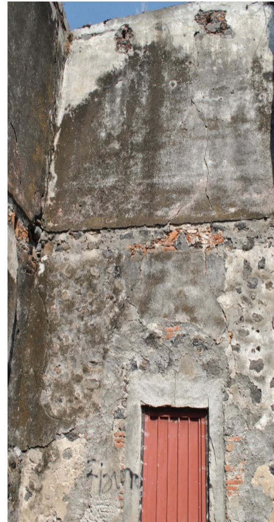
Figura 2.4 Detalle de manchas negras de microorganismos en muro del interior de los purgares. Archivo fotográfico de Mariana Sainz 2014.
