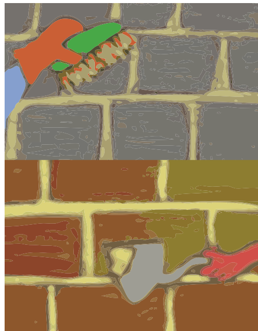
Imágenes en orden: limpieza de muro con cepillo y agua, con agua a presión, resane de juntas y eliminación de juntas deterioradas.
