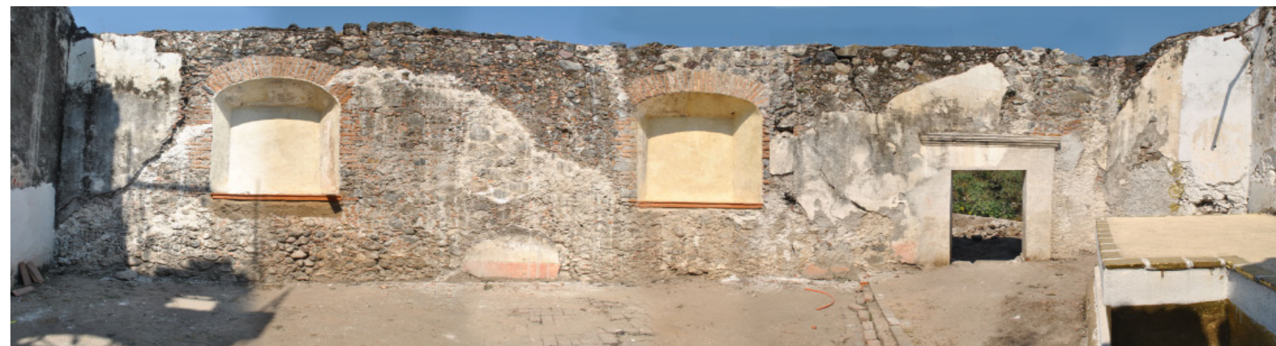
Interior muro norte 2014
