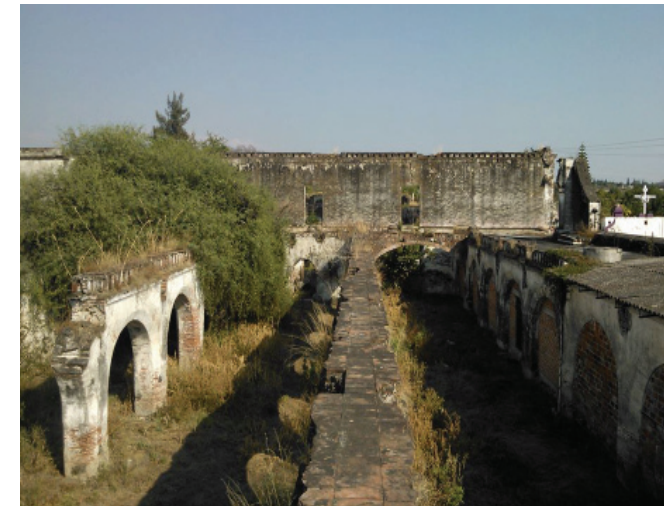
Figura 1.13 Fotografía del interior de los purgares desde la parte superior del muro poniente; se observa el muro sur del lado derecho de la imagen y el muro orientado al fondo, con sus dos niveles.
