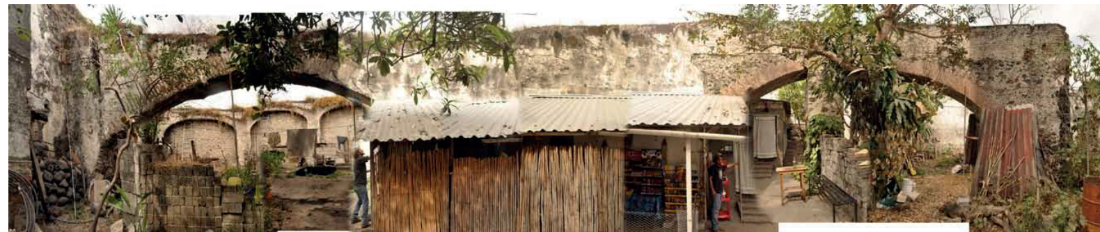
Interior del predio, la tienda de los propietarios en el centro de dos arcos escos.
