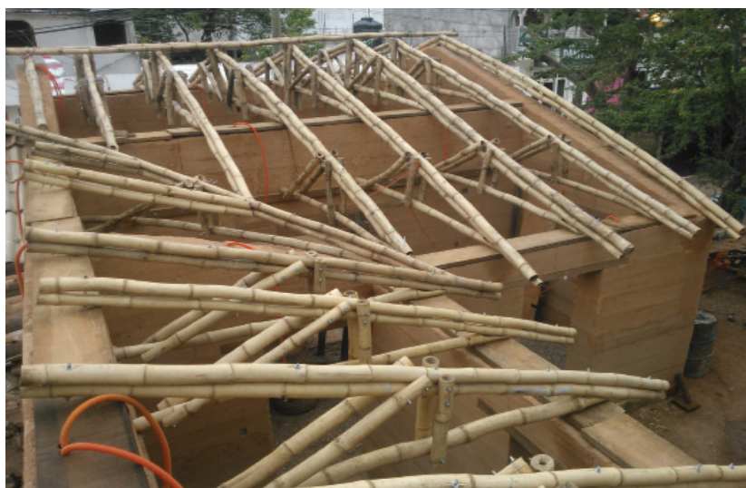
Figura 4.8 Construcción con muros de tierra apisonada y serchas de bambú. Archivo fotográfico de Ellery Gatica 2014.
