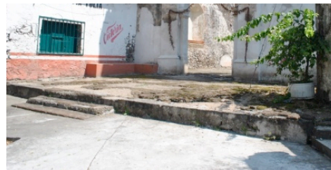
Figura 3.22 Pavimentación afuera de la capilla. Fotografía tomada por el equipo de este trabajo.
