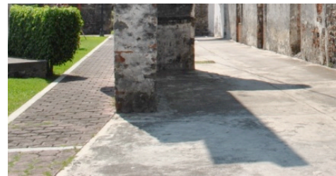
Figura 3.25 Pavimento de concreto estampado exterior de los purgares. Archivo personal.
