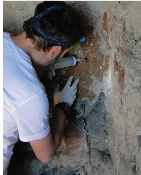
Figura 4.2 Proceso de inyección de muro con mortero de cal y arena y con una aguja de veterinario.
