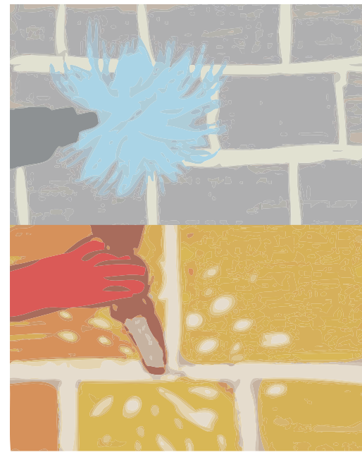
Imágenes en orden: limpieza de muro con cepillo y agua, con agua a presión, resane de juntas y eliminación de juntas deterioradas.
