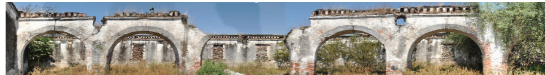
Figura 1.12 Tercera fila de arquerías viendo al norte.
