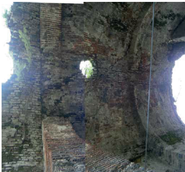
Bóveda de cañón corrido.
