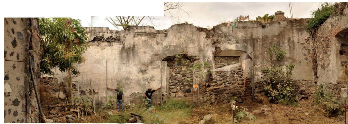
Muro norte al interior de la vivienda, con los dos vanos de puertas abocinadas.
