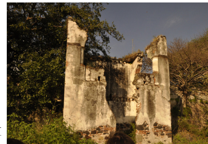
Acueducto, fachada sur. Archivo personal.
