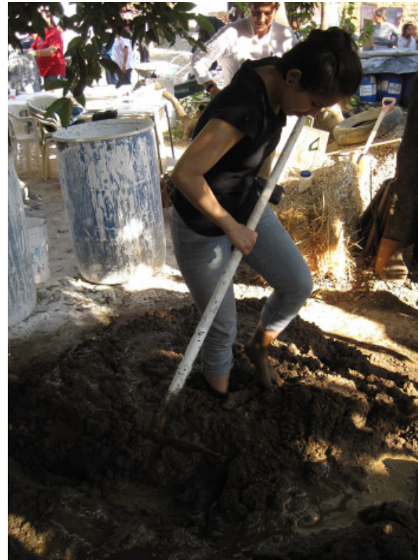
Mezcla de la tierra para la construcción. Archivo personal.
