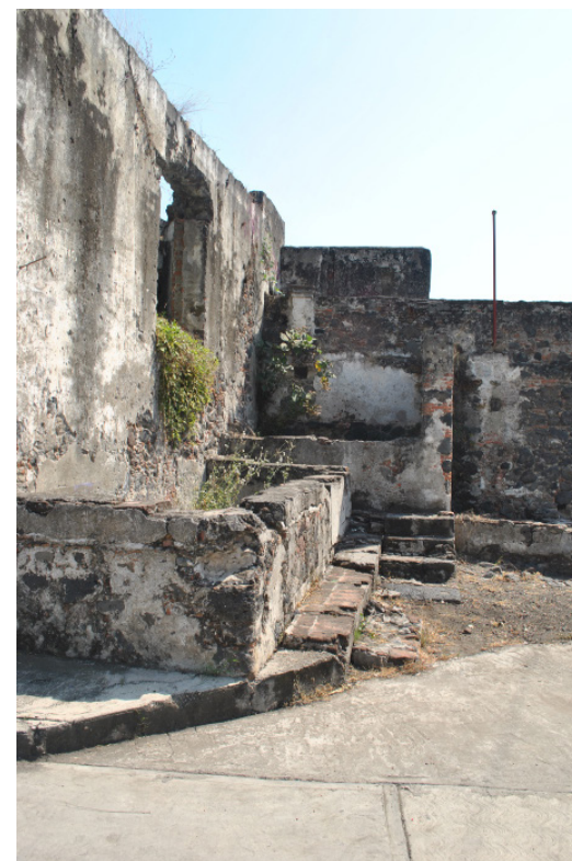
Figura 3.7 El cárcamo en el patio central se nutría del acueducto. Morán, op.cit., p.104 Archivo personal.
