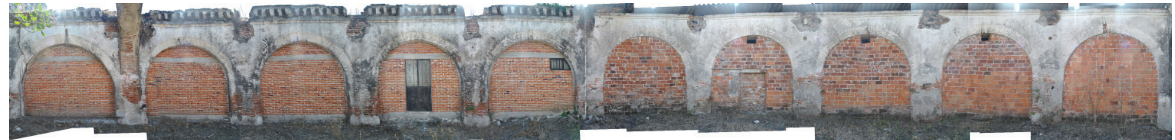
Figura 1.10 Fila de arquerías del sur
