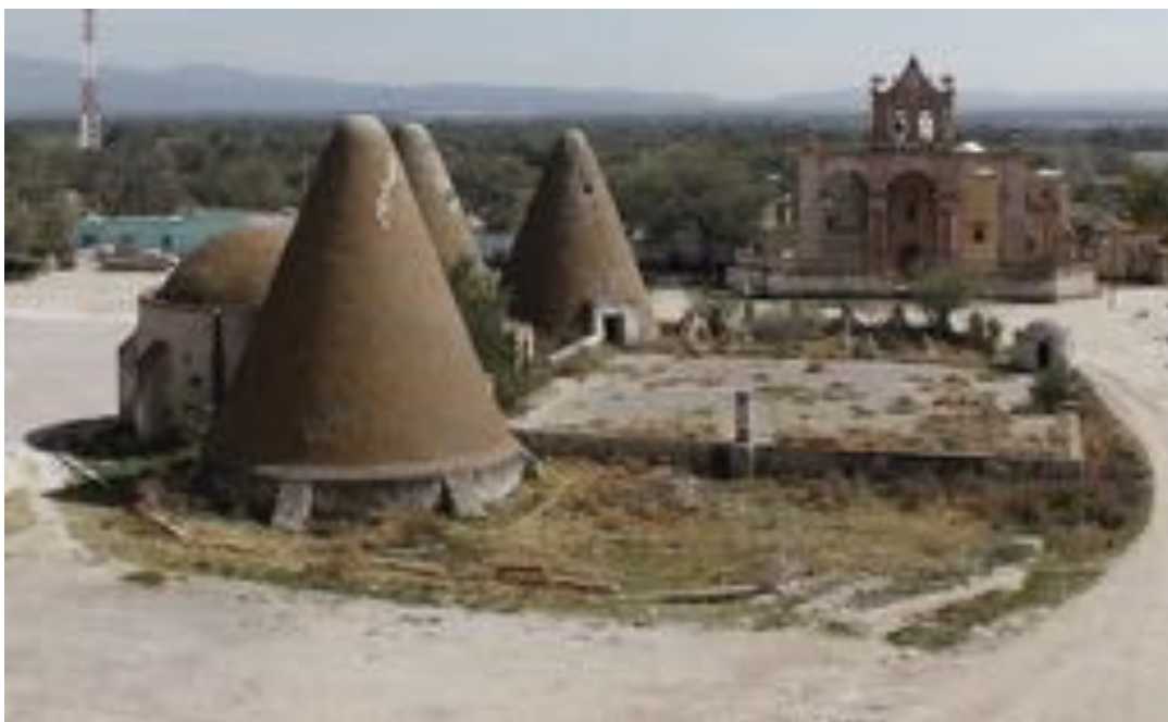
Ilustración 111. Vista del conjunto de silos al sur de la plaza cívica.
