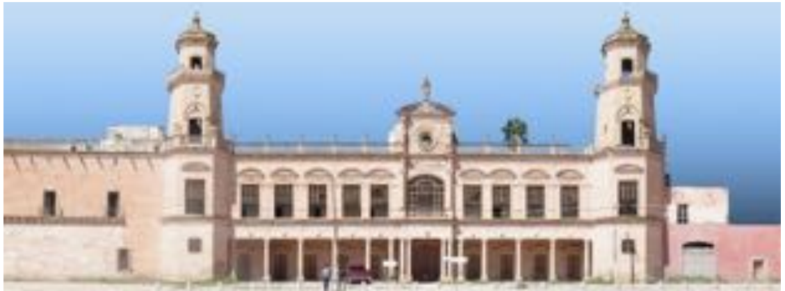
Ilustración 28. Fachada principal de la casa principal de la ex hacienda.
