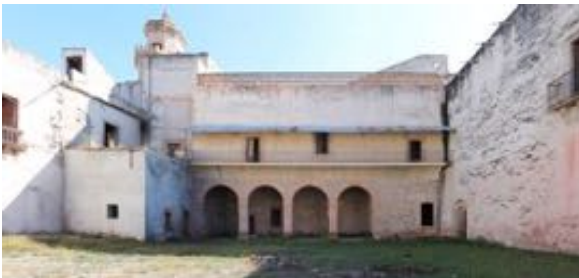
Ilustración 59. Estado actual de la fachada
