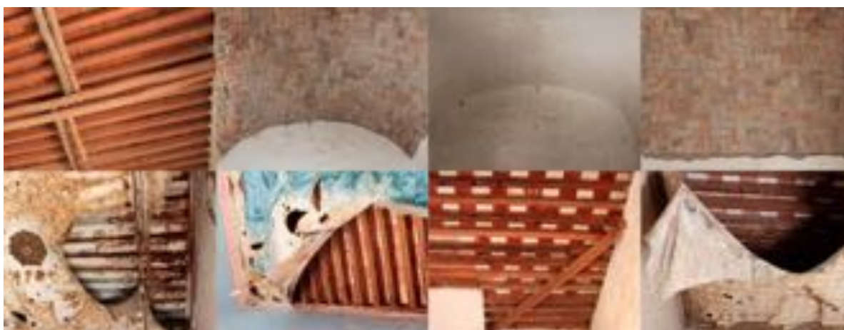
Ilustración 44. Tipos de cubiertas localizadas a interior del conjunto habitacional.
