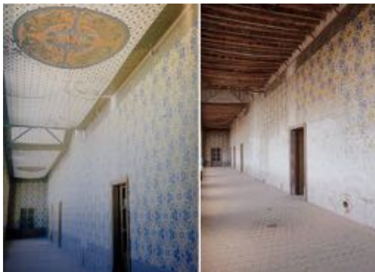
Ilustración 48. Pérdida de cielos rasos y daño severo en la pintura mural. Fuentes: Rionda, Haciendas de Guanajuato 2001, 92.
