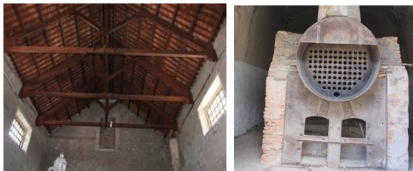
Ilustración 35. Cubierta de par y nudillo en la nave principal de la mezcalera. Ilustración 36. Caldera de vapor de finales del siglo XVIII.
