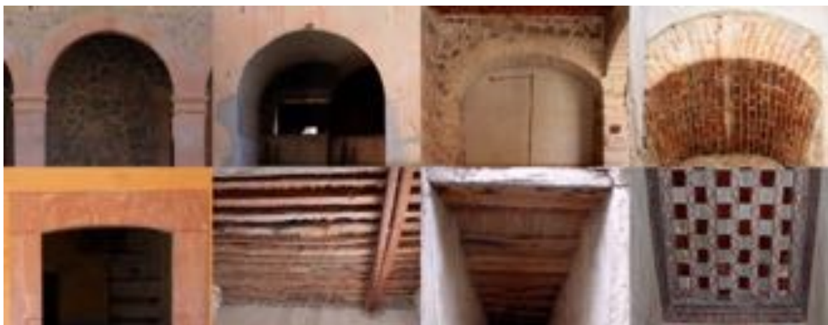
Ilustración 43. Tipos de elementos estructurales horizontales y entrepisos localizados al interior del conjunto habitacional.
