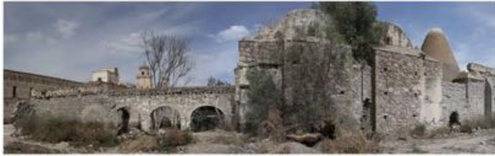
Ilustración 118. Vista trasera de la troje del siglo xix y el conjunto de locales adosados a la misma.
