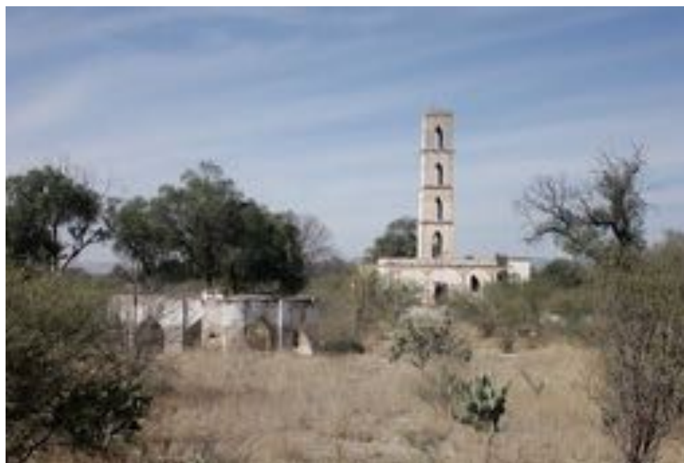
Ilustración 79. Estado actual del patrimonio edificado, vista desde el interior del contenedor de agua.
