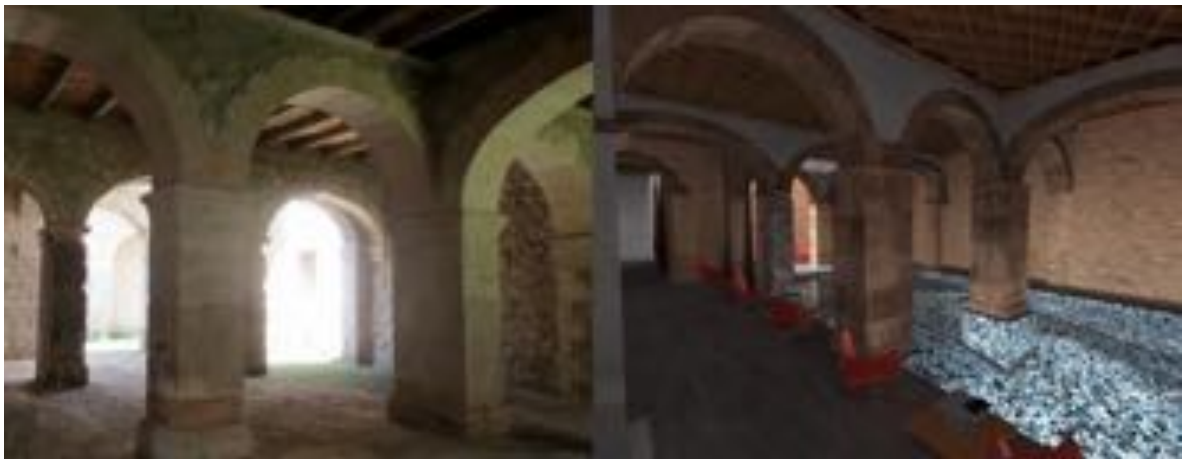
Ilustración 57 y 58. Comparativo de la zona de bodegas antes y después de la propuesta de intervención.
