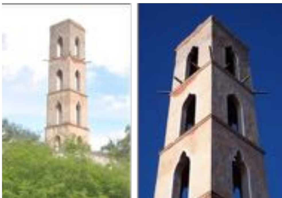
Ilustración 96. Vestigio de la pintura de los muros de la torre, la pintura representa la forma y textura del ladrillo
