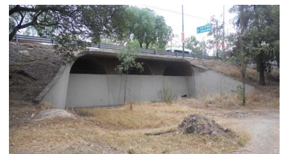
Vista de pasos peatonales ahora convertidos en bodegas y subestación eléctrica.
