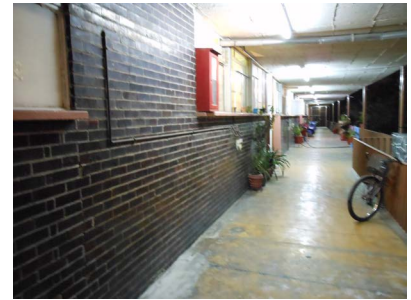
Vista de fachada interior poniente. Se puede apreciar al uso de block vidriado, losas aparentes, piso de concreto pulido con acabado de pintura, y barandal de solera de acero.
