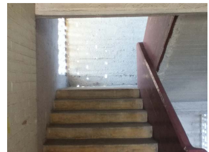
Vista de cubo de escaleras principales. se puede apreciar la rampa y murete de concreto, así como los muros de tabique rojo con acabado de pintura y una sección de celosía que permite el paso de luz hacia el descanso.
