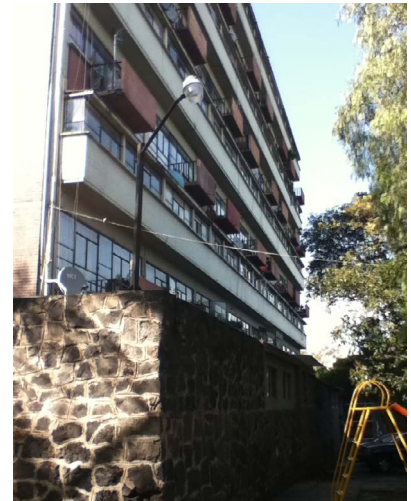
Vista de la esquina de la fachada sur y la fachada oriente, se puede apreciar, el uso de piedra volcánica en muros, así como la combinación de muros de tabique con acabado de pintura, muros de block vidriado con acabado aparente y murete de concreto en el balcón.
