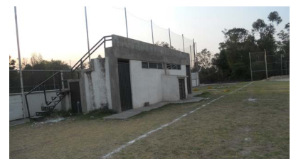
Vista de gradas y bodegas de zona de canchas.
