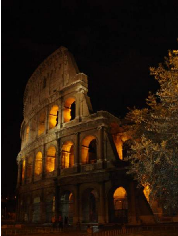
Imagen 2 Consolidación del Coliseo Romano, contrafuerte construido Por Raffae-le Stern, en 1807, Fuente: fotografía Laura Venancio, 2008.
