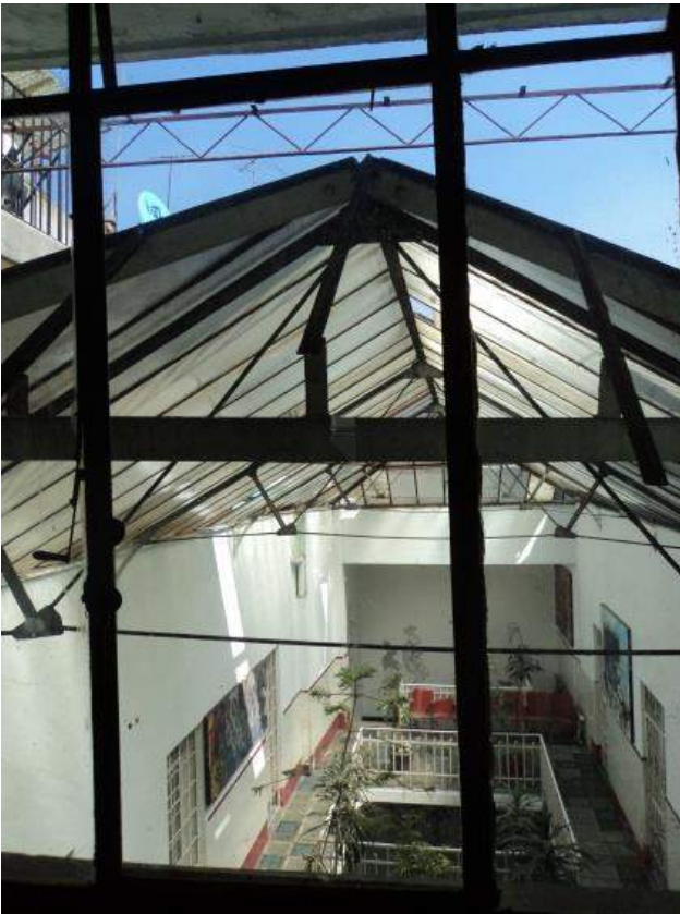
Imagen 54 Vista del 2do nivel desde vivienda en 3er nivel, Fuente: fotografía Laura Venancio
