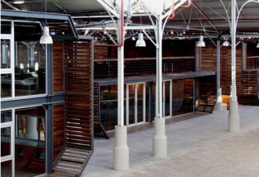
Imagen 19 vista interior del Conjunto del Centro Metropolitano de Diseño, se observan la interrelación de los espacios nuevos y los existentes. (s.f.), Fuente : fotografía ARQA
