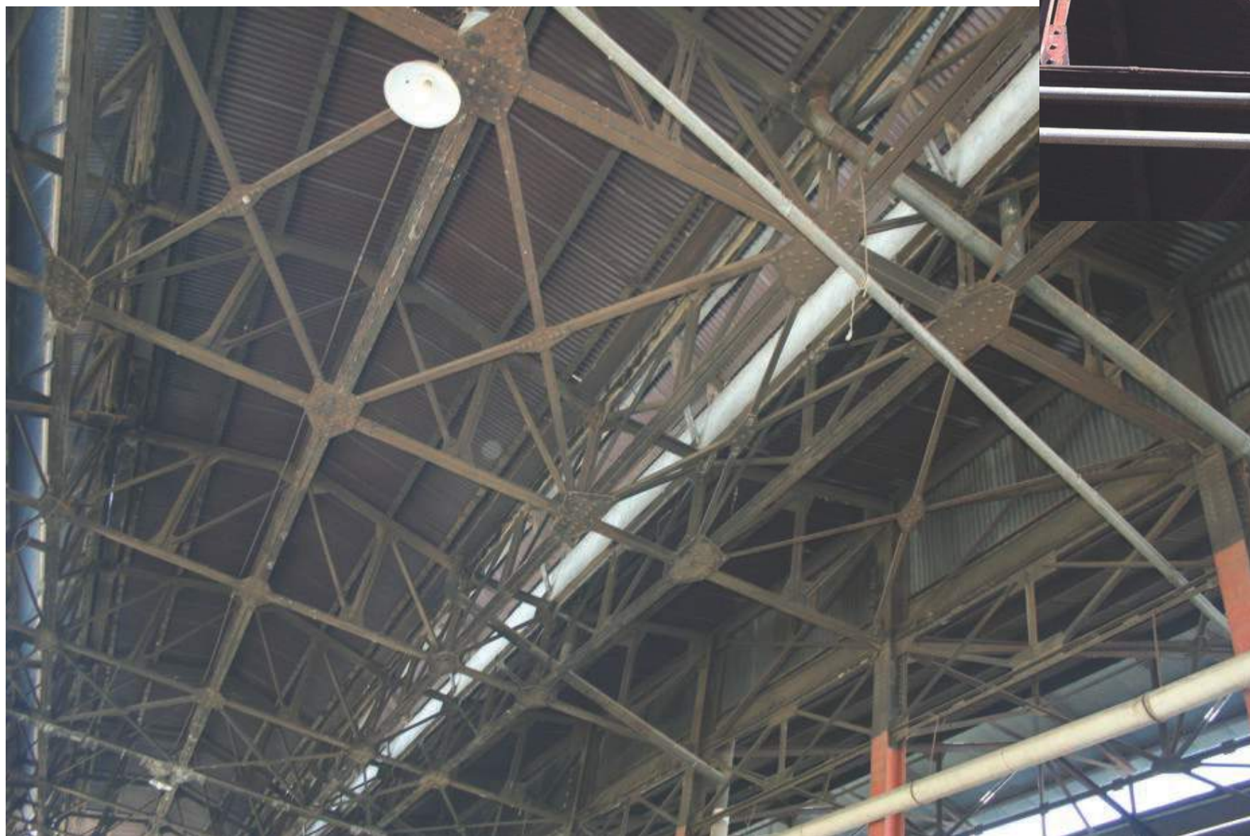
Imagen 27. Vista interior de la estructura.
