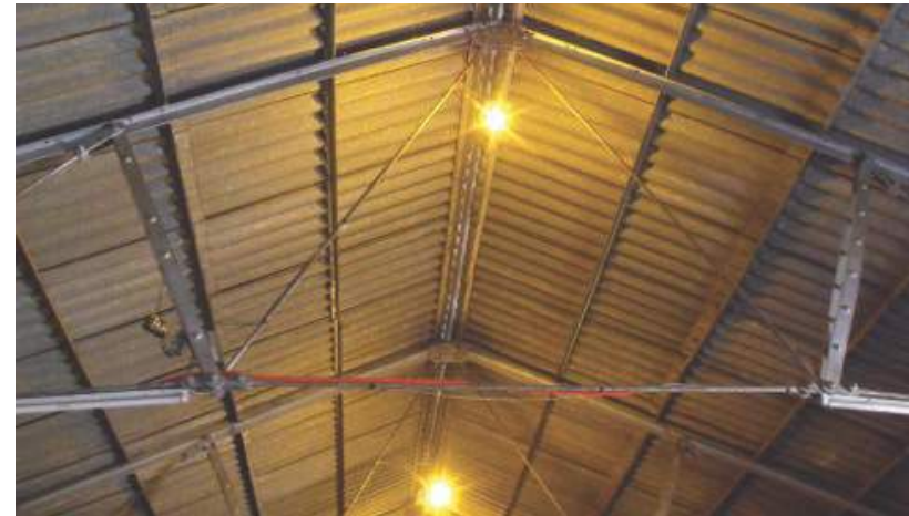
Imagen 2. Estructura de la bodega.
