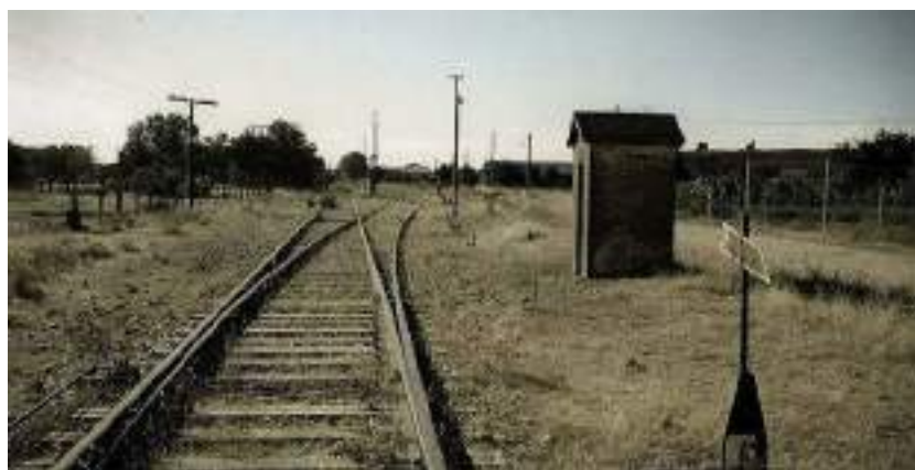
Imagen 1. Estación de tren.
