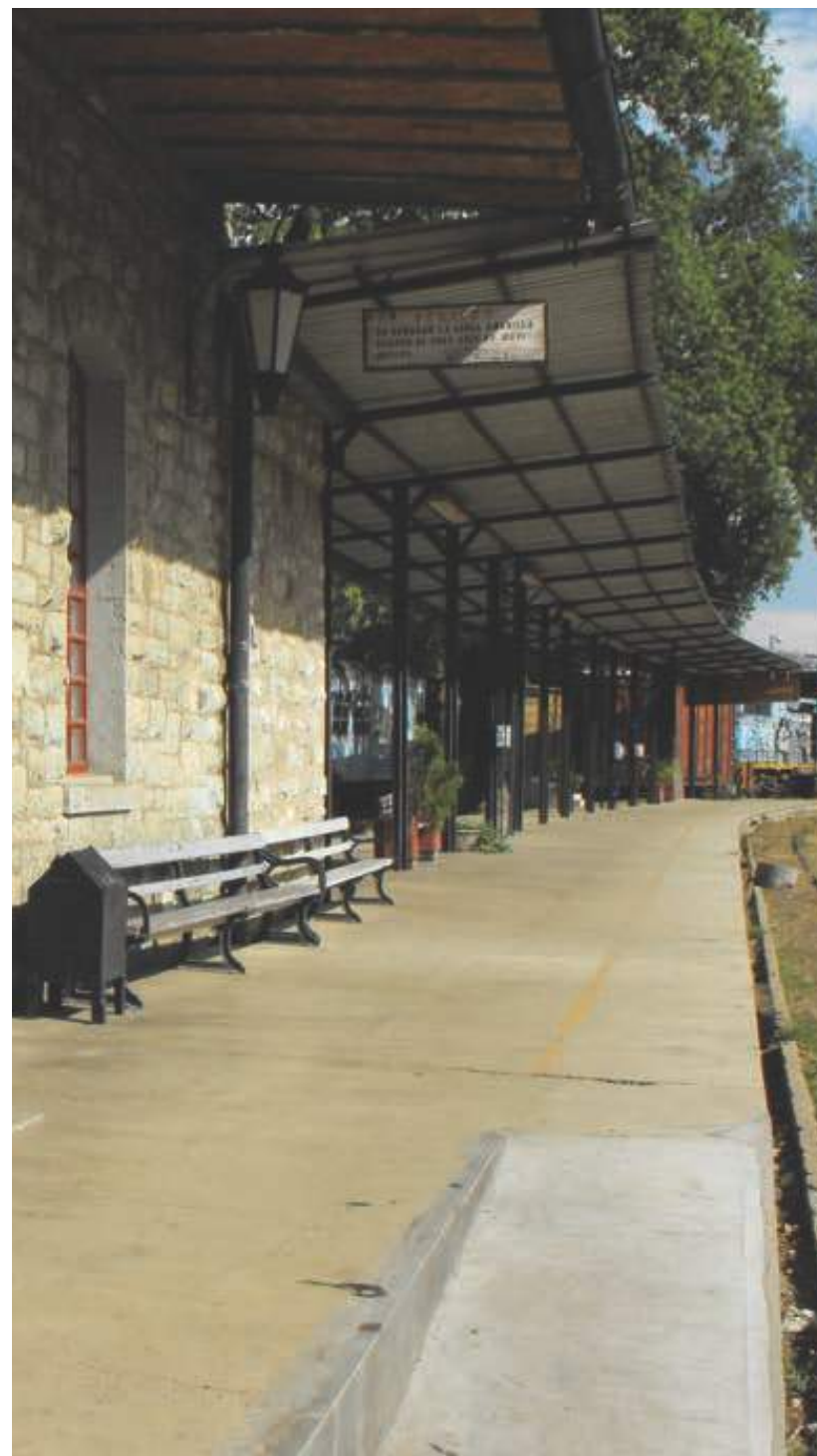
Imagen 13. Andén y fachada poniente de la estación.
