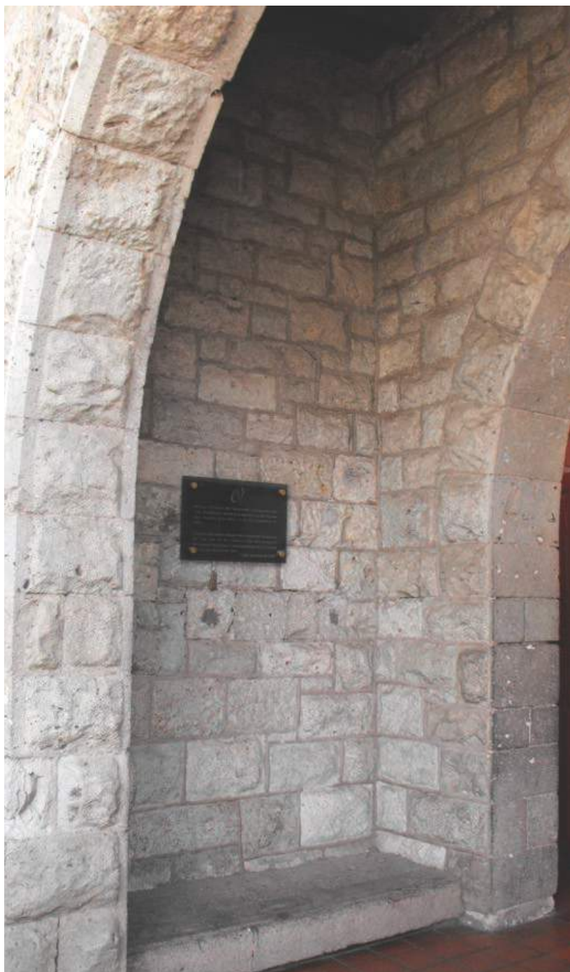
Imagen 16. Acabado aparente en muros.
