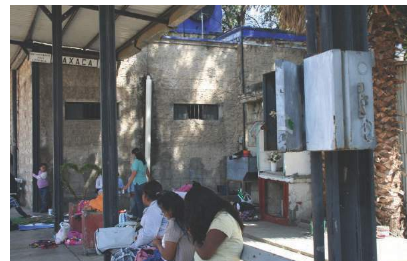
Imagen 19. Añadido de baños.
