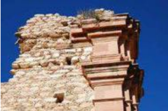
Imagen 3.46 Cornisas de cantera Cortesía del Mtro. José Luis Colmenares.
