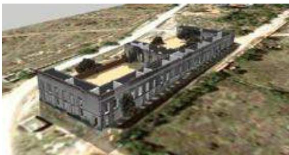
Imagen 4.33 El inmueble se encuentra totalmente destechado
