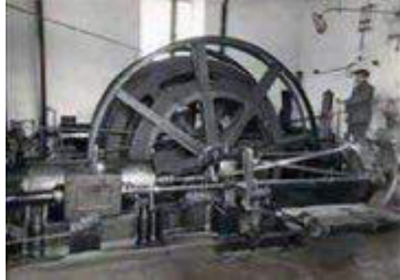
Imagen 2.9 Winch de vapor, fuente: www.revista de patrimonio.es
