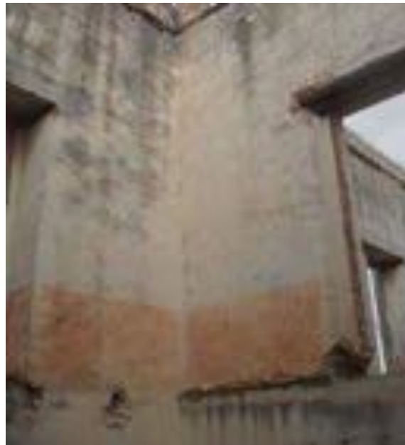
Imagen 4.20 Pintura en muros interiores
