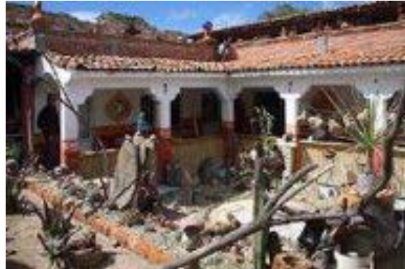
Imagen 3.110 Patio de la Casa del Venado Azul fuente: www.mineraldepozos.com
