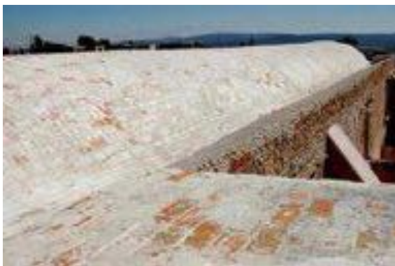
Imagen 3.43 Bóveda de cañón corrido, Casa Santa del Mtro. José Luis Colmenares.
