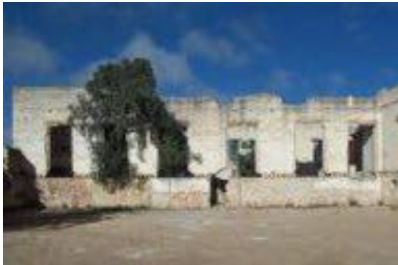
Imagen 4.19 Cama de arena en el "patio 2"
