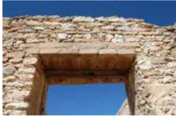
Imagen 3.40 Cerramiento resuelto con ladrillo Cortesía del Mtro. José Luis Colmenares.
