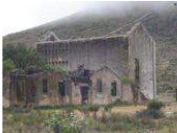
Imagen 2.10 Central eléctrica de Mineral de Pozos
