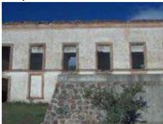
Imagen 4.47 Aljibe obstaculizando la visibilidad de la fachada oriente
