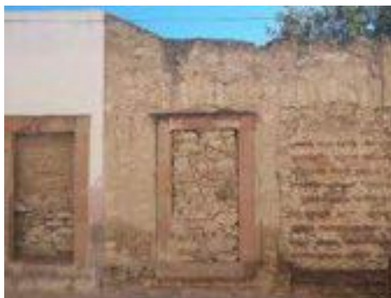
Imagen 3.37 Vivienda con muros de piedra y ladrillo: "mixto".
