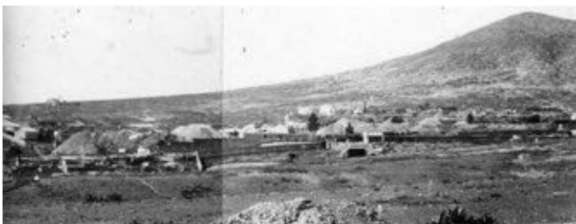
Imagen 3.57 Mina el Triángulo. Fotografía cortesía de "Chon" Mancilla.
