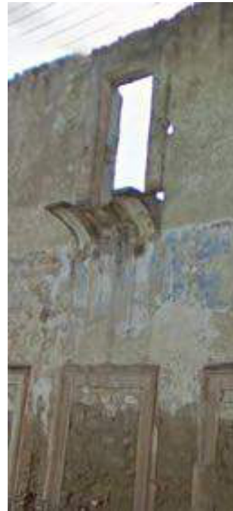
Imagen 3.64 y 3.65 Colores encontrados en fachadas tras la disgregación del color blanco impuesto en los años 70
