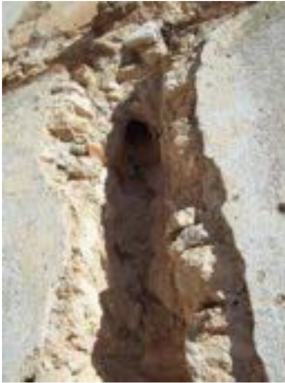
Imagen 4.21 Detalle de bajada pluvial
