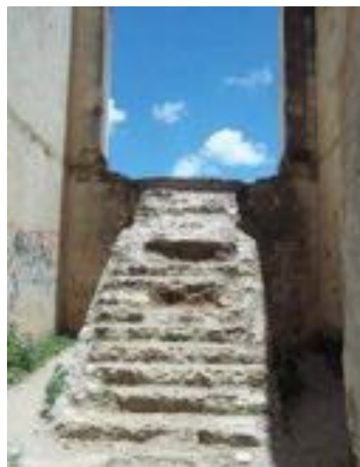
Imagen 4.35 Escalera de acceso
