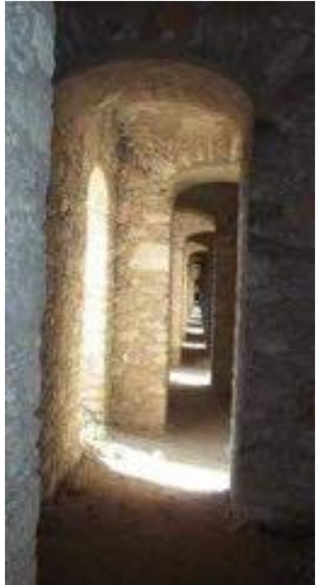
Imagen 1.2 Interior de "La Chimenea", en Santa Brígida
