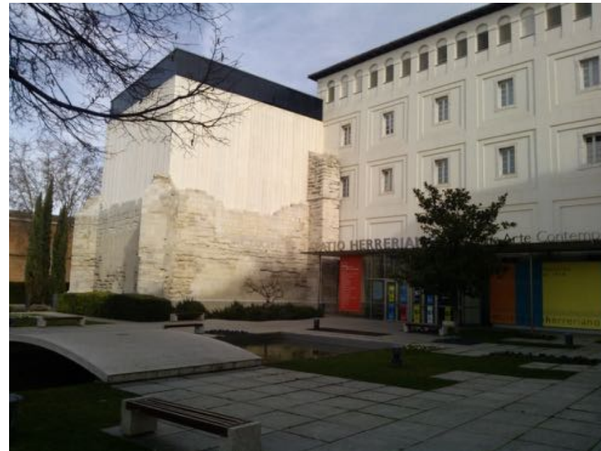
Figura 32. Por medio del revoco se busca la unidad de la ruina, el edificio histórico y los nuevos agregados.
