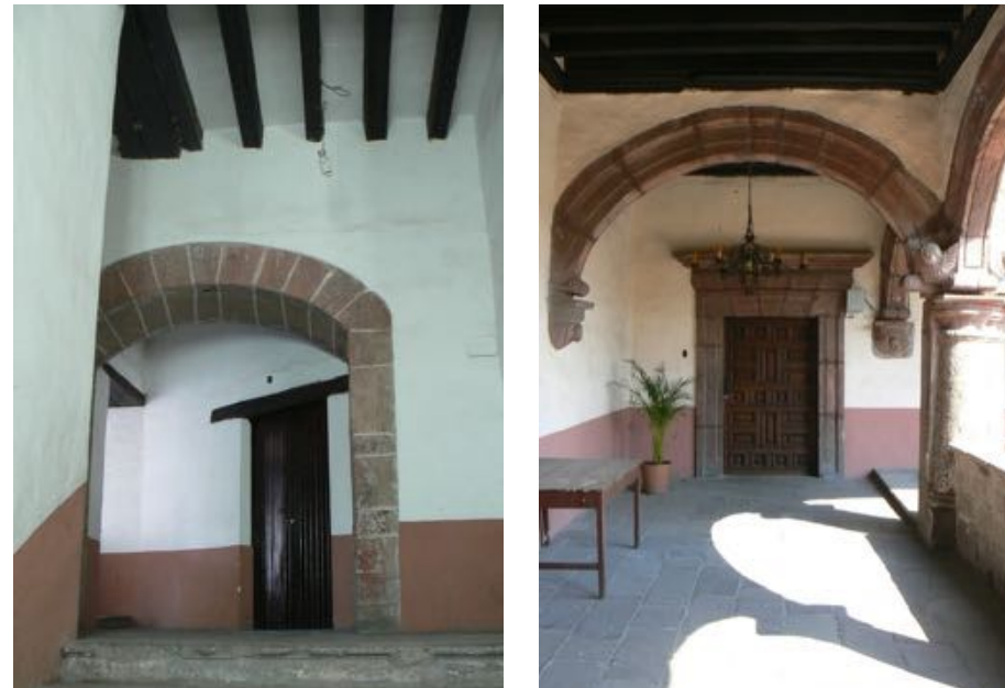
Figura 24. Distintos materiales y formas de cerramientos. Fuente: autores.
