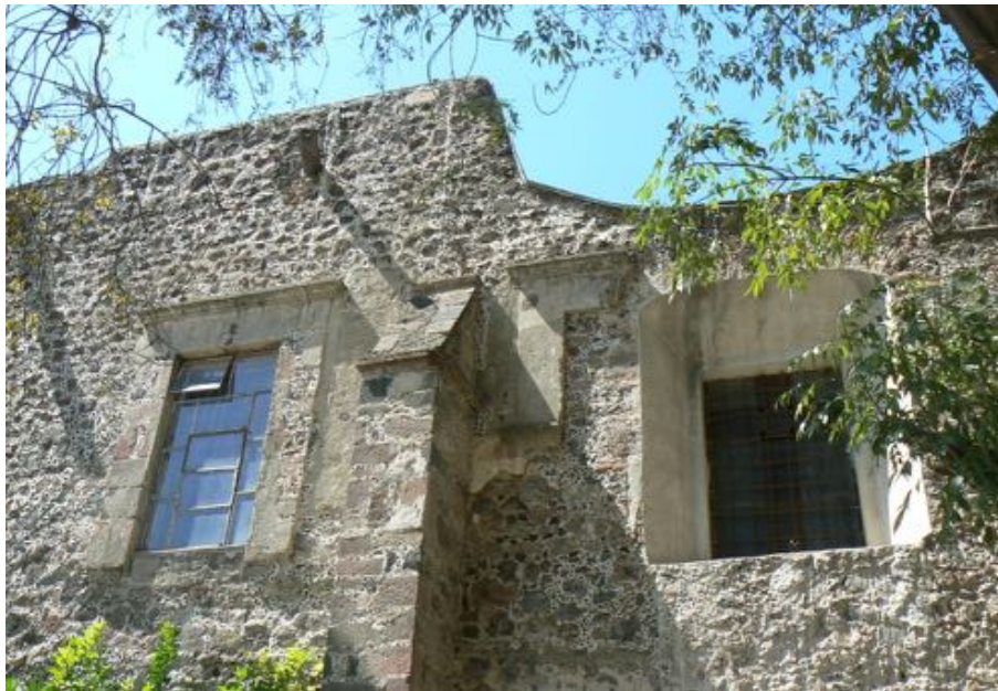
Figura 23. Muro Sureste (oratorio) realizado con varios tipos de mampostería. Fuente: autores.
