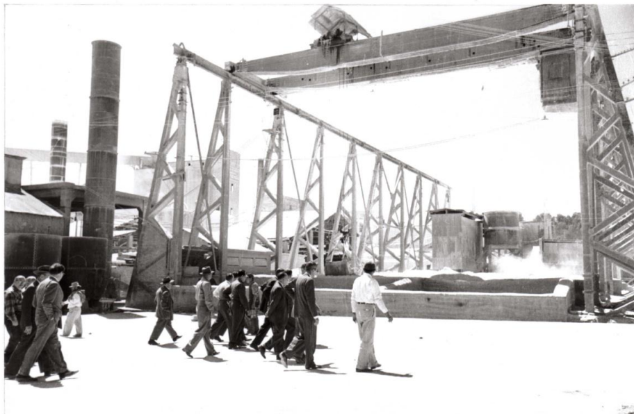
Fig.73. Apariencia original, con el paso del tiempo para aminorar la fuga de material ocasionada por el viento, fue cubierto con láminas onduladas de acero. Fotografía: Colección de los hermanos Mayo, AGN, 1952.
