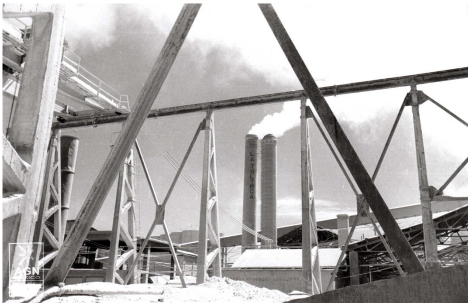
Fig.74. Podemos observar las secciones estructurales que sostenían el riel de las grúas viajeras, con el paso del tiempo por la necesidad de contener el material, se cubrió este cajón con láminas. Además, podemos ver los chacuacos y remates visuales que ofrece el conjunto.
