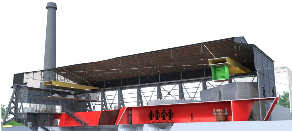
Fig.78. CD-A. Espacio que tiene como objetivo principal, mejorar el desarrollo social y transmitir a la sociedad en general la importancia de la preservación del patrimonio, así como también difundir la carga histórica del municipio de Tula. En este edificio se desarrollaran actividades múltiples culturales y educativas para los distintos niveles educativos, desde niños aprenderán que es una fábrica, hasta jóvenes universitarios que podrá desarrollar múltiples actividades, incluso nocturnas.
