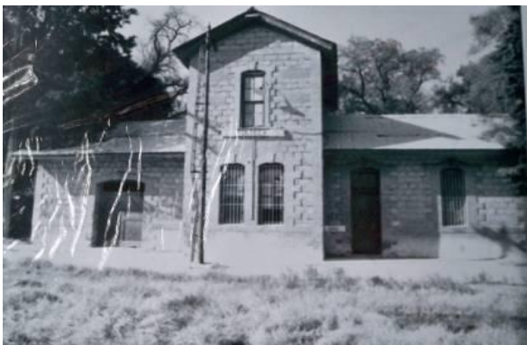
Fig.44. Estación de ferrocarril La Tolteca. Se ubica frente a la fachada principal de la planta. Fotografías: AGN (archivo, hermanos Mayo)
