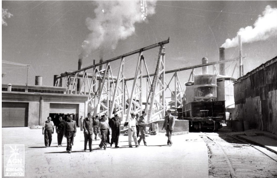
Fig.75. Fotografía donde se puede apreciar la primera etapa constructiva del edificio. Incluso podemos ver, como los contenedores del ferrocarril llegan hasta esta estructura para recoger el material y transportarlo a otro punto de la fábrica. Este aspecto se respetó, en la segunda etapa constructiva, ya que se mantiene este espacio con un gran vano que permite la entrada de estos contenedores. Esta información sobre el ferrocarril también es crucial en la propuesta de diseño.
