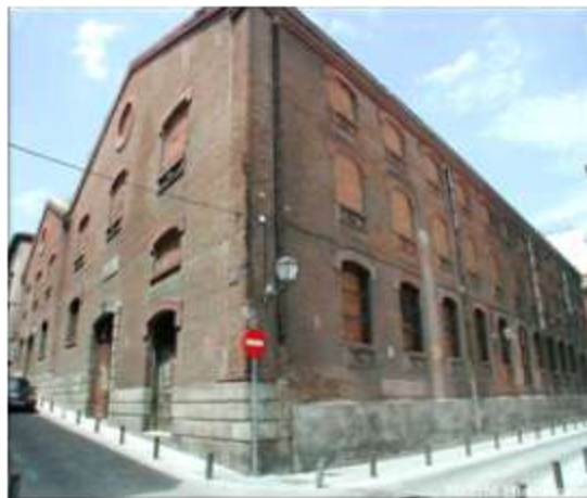
Antigua estación eléctrica, previa a su intervención Fotografía: Autor inédito. (1999)
