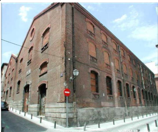
Fig.15. Antigua estación eléctrica, previa a su intervención Fotografía: Autor inédito. (1999)
