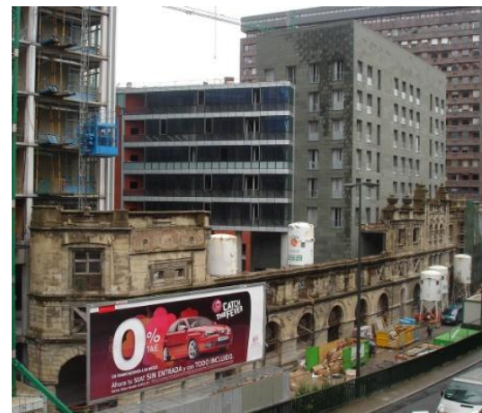
Fig.6. Recuperación de fachadas de antiguos edificios de vivienda, sobre el río Nervión, solo como algunos elementos esculturales. (Tendencia muy cuestionable) Fotografías: Omar Peña Coya
