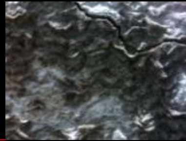
Fisuras y grietas, de bajo impacto estructural en concreto
