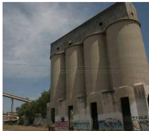
Fig.32. Silos en la fachada principal, en estos se descargaba materia prima a los contenedores del ferrocarril que pasaba, justo bajo estos elementos, que poseen una plástica escultórica de gran valor
