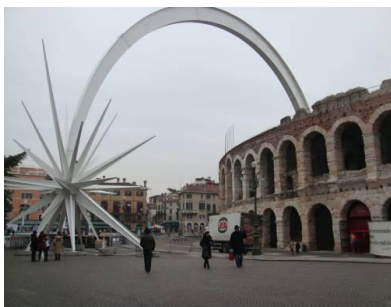
Fig.20. Coliseo de Verona, Italia. Consolidado con un elemento totalmente contemporáneo, pero respetando plenamente la autenticidad de la ruina romana.
