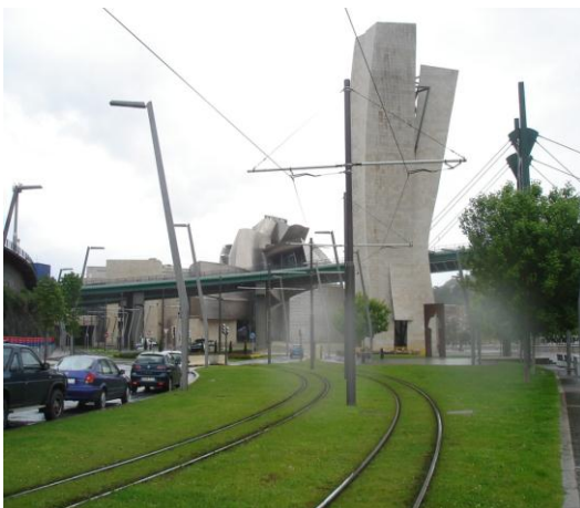
Fig.5. Reutilización de antiguas vías férreas para nuevos medios de transporte, como el moderno tranvía, complementado con el diseño paisajístico para hacer de estos espacios sitios de recreación y reunión.
