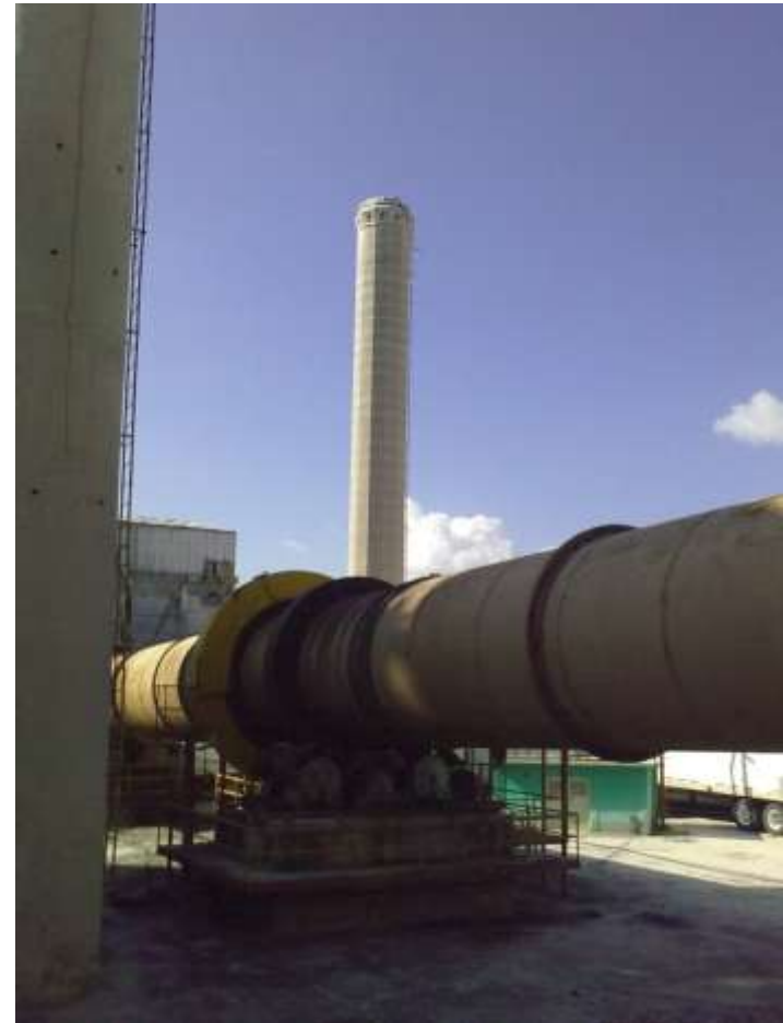
Antiguo horno de cocción de cemento y chacuaco del año de 1914, considerados en esta investigación como posibles elementos con valores característicos de arqueología industrial.
