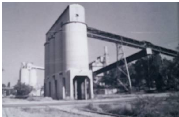
Fig.45. Banda transportadora y silos que se ubican a los márgenes de las vías del ferrocarril, estos descargaban materia prima a los vagones.
