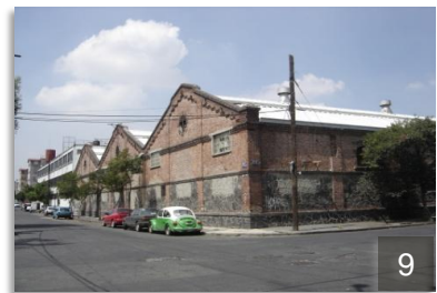
Fig. 57 Almacén, calle Sabino.
