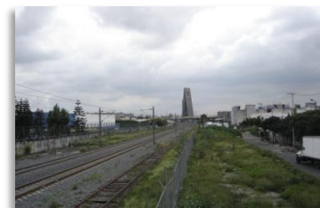
Fig. 16 Vías FF.CC suburbano.
