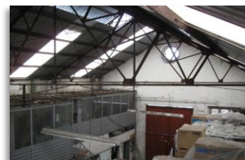
Fig.104 Armaduras y lucernarios.
