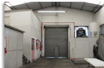
Fig.111. Vista sección sur.
