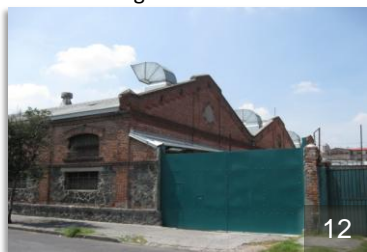
Fig. 24 Almacén, calle Sabino.
