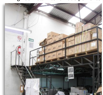
Fig.136 Tapanco de estructura metálica.
