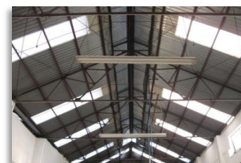
Fig.96 Armadura tipo Polonceau.
