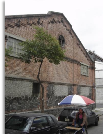
Fig. 14 Conjunto de bodegas calle Sabino.
