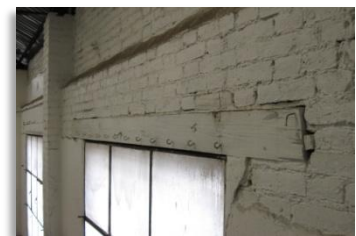
Fig.124 Muros con aparejo de tipo flamenco doble.
