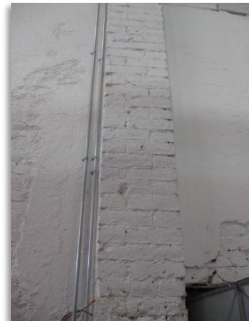
Fig.123 Columna con aparejo de tipo flamenco doble.
