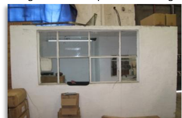
Fig.121 Oficina al interior de la bodega.
