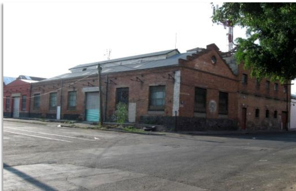
Fig. 174 Imagen del estado actual del inmueble y su entorno inmediato.
