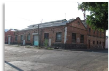
Fig.120 Vista completa de la bodega.
