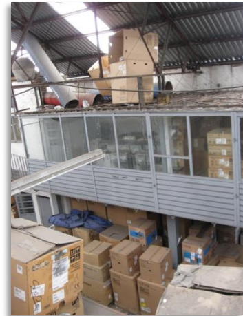
Fig.102 Tapanco metálico, bodega 2
