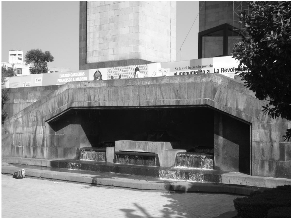
Figura 10. Fuentes laterales ubicadas en los jardines profundos, México, D.F. Fuente: Fotografía del autor.
