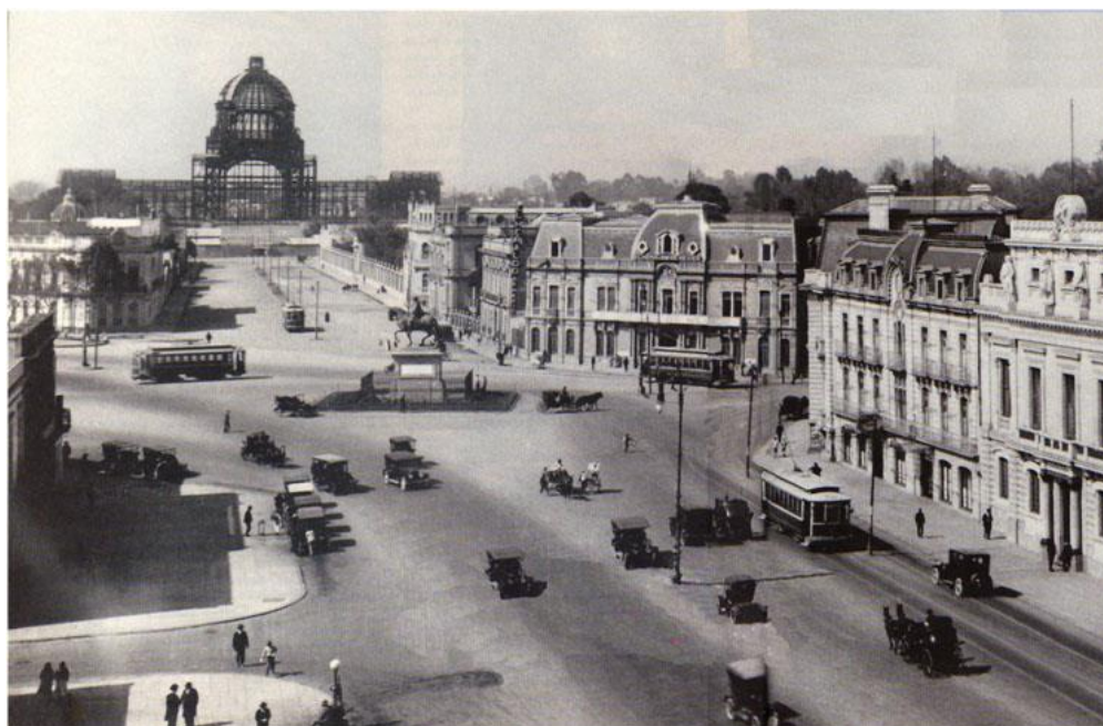
Figura 17. La abandonada estructura metálica de lo que sería el Palacio Legislativo. Fuente: Javier Pérez Siller y Martha Bénard Calva, El sueño inconcluso de Émile Bénard y su Palacio Legislativo, hoy Monumento a la Revolución , p. 113.
