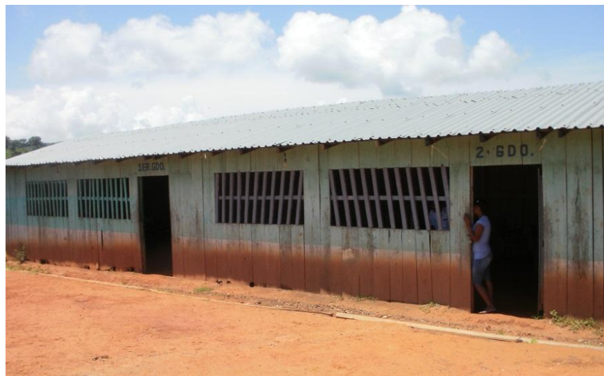
Fig. 9 – Aulas del primer y segundo grado de bachillerato de Mexcaltepec. Fotografías tomadas el 27 de agosto de 2010.
