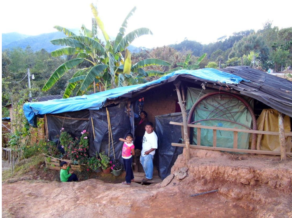
Fig. 12 – Familia que salió a saludarnos en nuestro recorrido por la localidad de El Llano. La imagen nos muestra su casa construida con adobe y techo de cartón cubierto con lona plástica. En la entrada a la misma se observa un piso de madera como soporte debido al desnivel del terreno. Fotografía tomada el 8 de enero de 2013.
