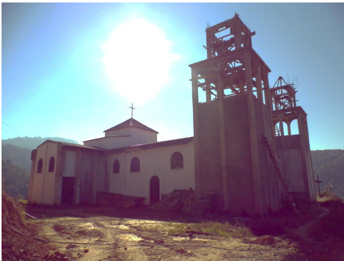
Fig. 2 – Iglesia en construcción en Yerba Santa.
