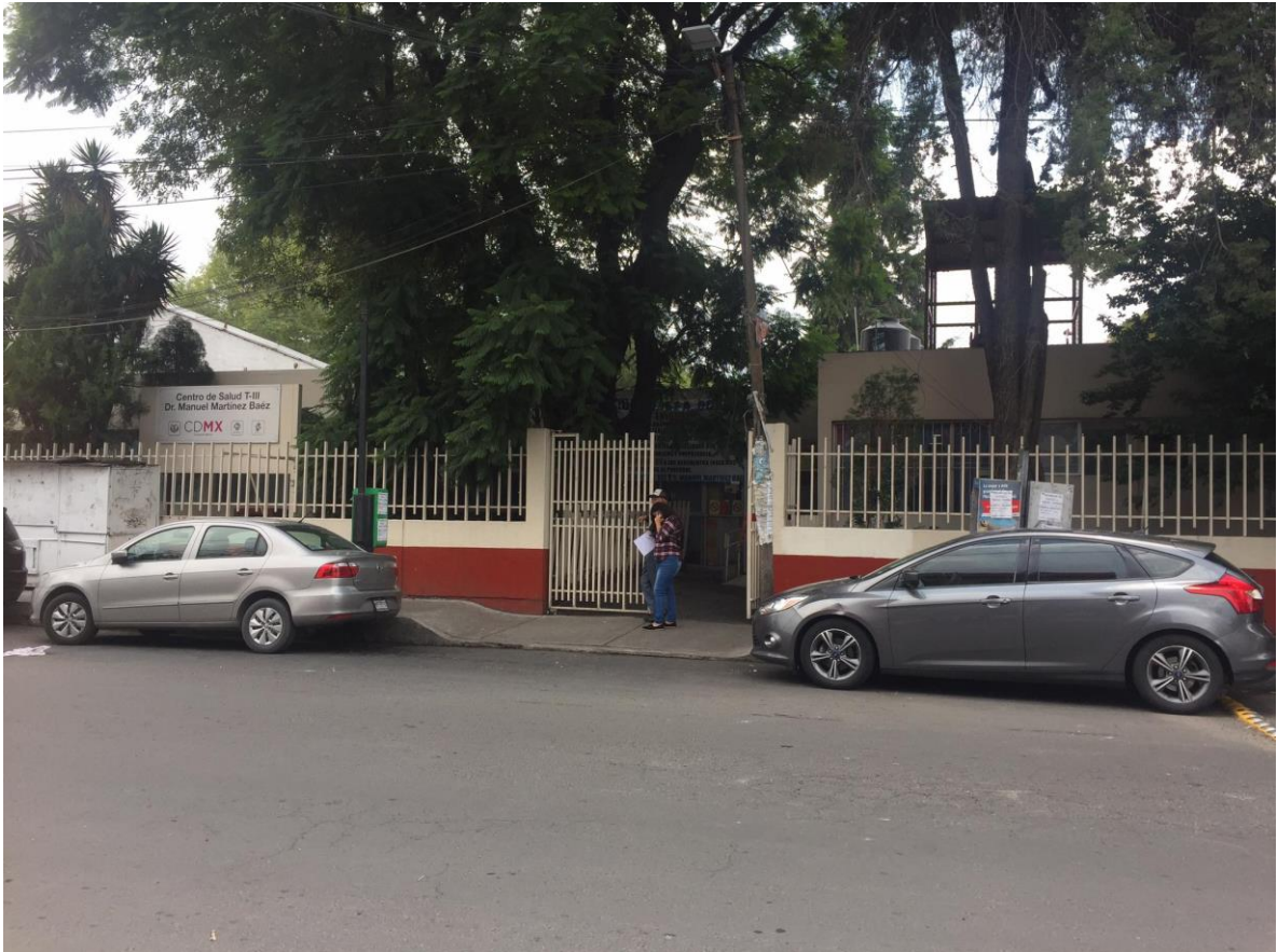
Figura 24. Fachada principal del Centro de Salud T-III Dr. Manuel Martínez Báez Fuente:
