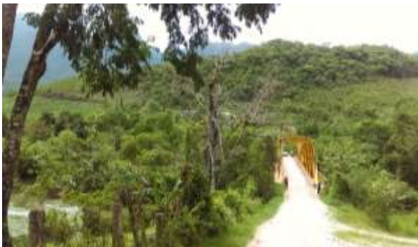
Puente peatonal, Río Jataté
