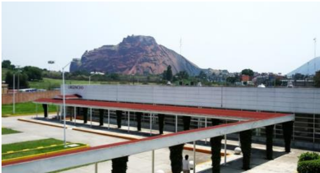
Imagen 2. Foto original tomada desde la segunda planta de la UMF 162, Se observa el área de urgencias. 10/10/2018
