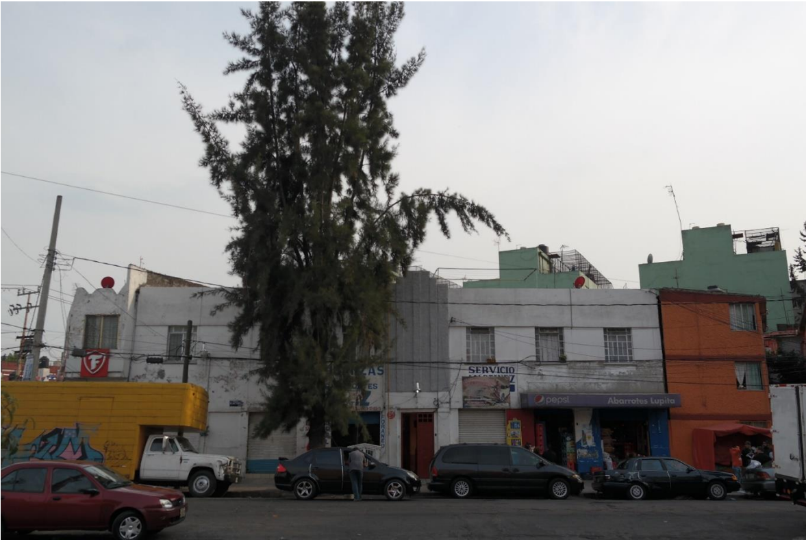
Estado actual., fachada principal.
