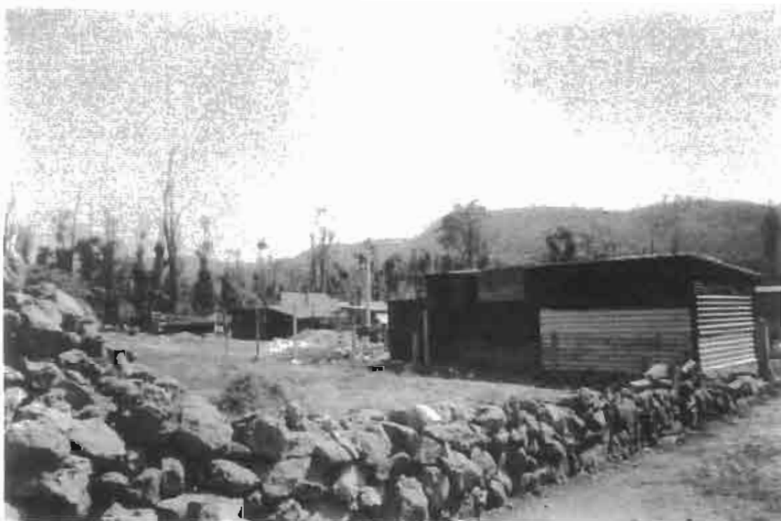
Techos de Lámina Asbesto
