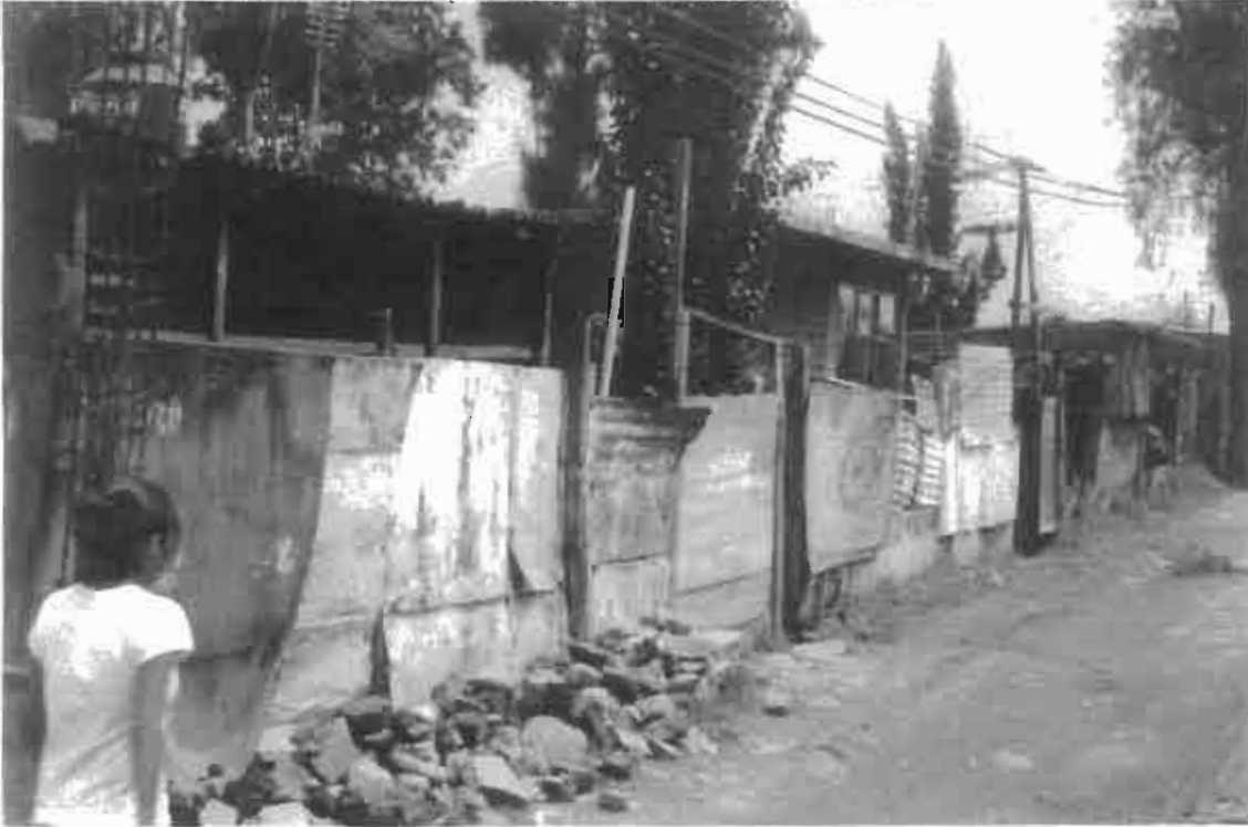
Paredes de Lámina, Madera, Asbesto
