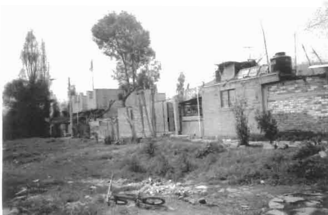
Paredes de Concreto o Tabicón
