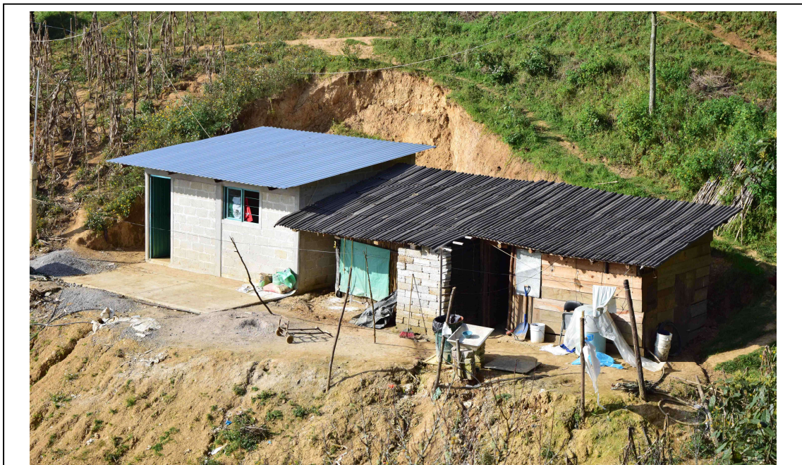
Imagen V.9. Acondicionamiento del terreno para disponer una unidad doméstica Fuente: http://municipiospuebla.mx/nota/2017-05-07/zacapoaxtla/construir%C3%A1n-250-casas-para-gente-de-bajos-recursos-en-zacapoaxtla/
