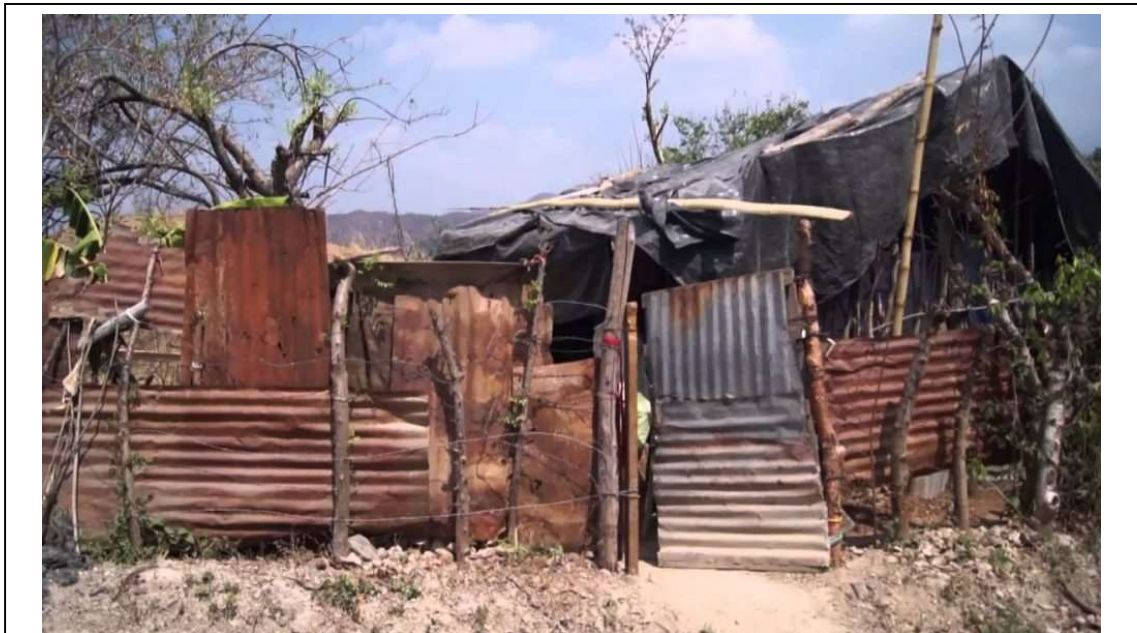
Imagen IV.7. Vivienda rural en Oaxaca, que muestra el abandono de materiales y técnicas tradicionales y su sustitución por materiales industriales como láminas metálicas, de cartón y plásticos.
