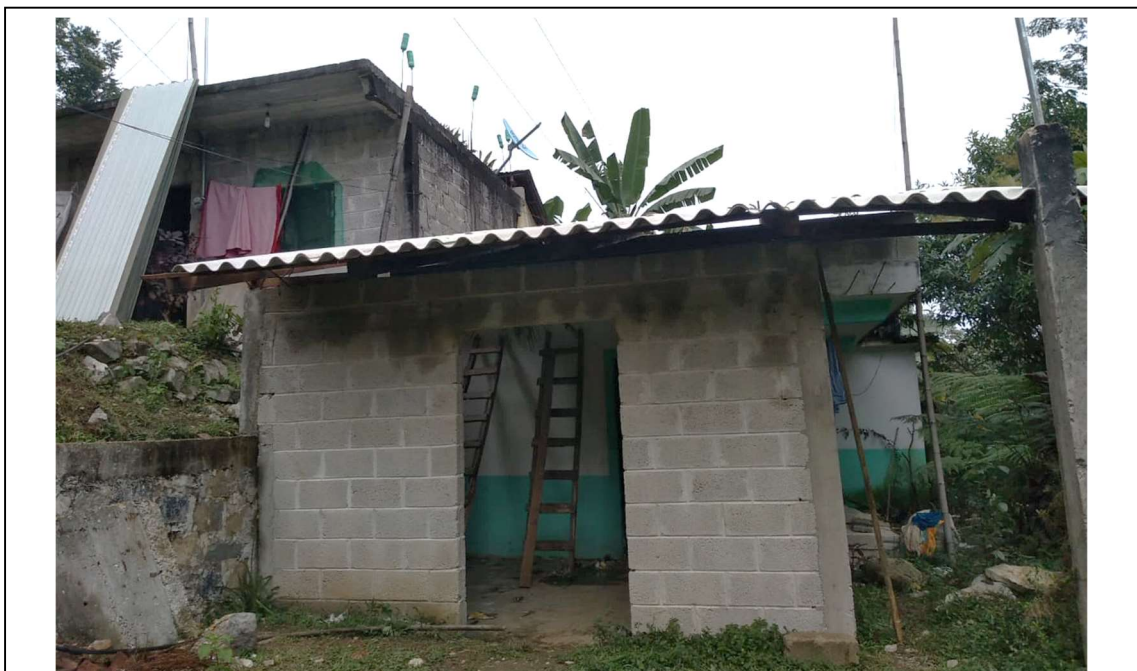
Imagen V.25. Ampliación de vivienda con cubierta temporal de estructura de madera y láminas, al fondo vivienda con losa de concreto armado con preparación para su ampliación en una segunda planta. Muros de tabicón y estructura de concreto armado. Escaleras de acceso a la azotea. Fuente: GMF
