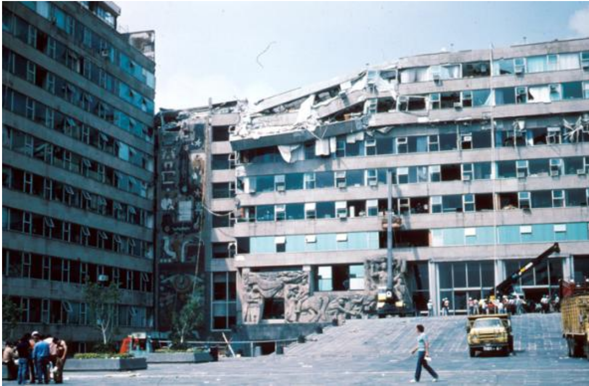
Figura 28. Secretaría de Comunicaciones y Obras Públicas, colapso de niveles superiores. 1985. Fuente: U.S. Geological Survey Library-USGS. http://library.usgs.gov/ ; fotógrafo Celebei M.
