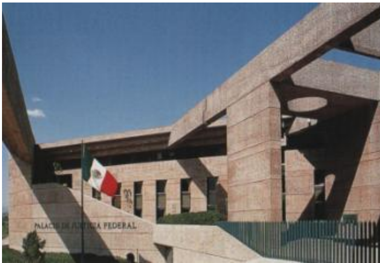
Figura 94. Fachada principal. Fuente: FRMH.
