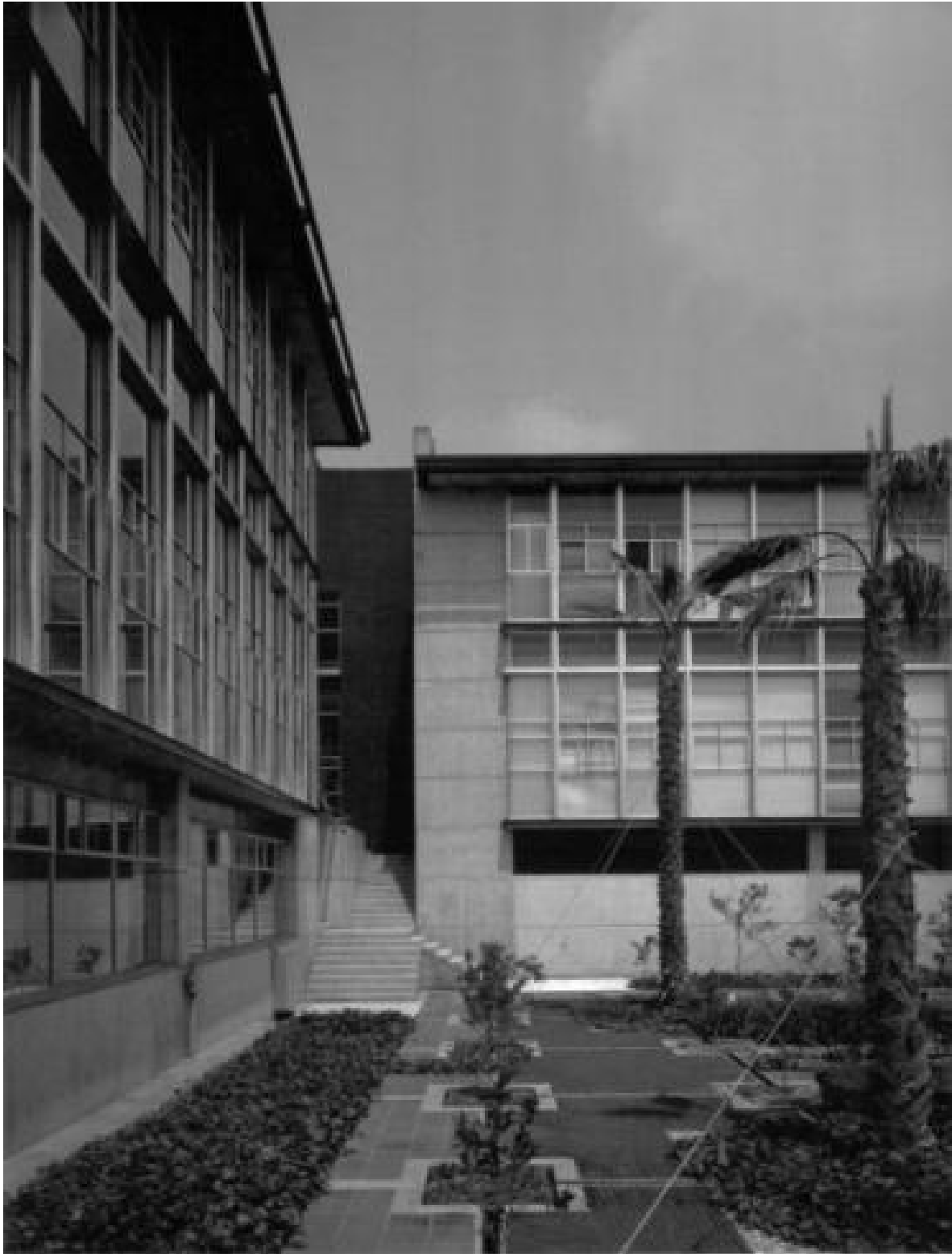
Figura 81. Tribunal Federal Electoral. Facultad de Arquitectura, UNAM. 1994. Fuente: Archivo Facultad de Arquitectura, UNAM.
