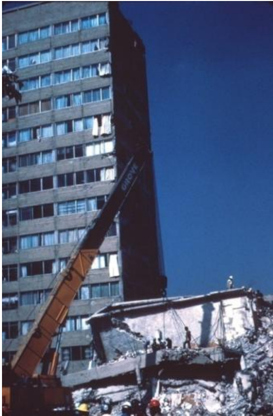
Figura 33. Multifamiliar Nonoalco-Tlatelolco, colapso del edificio Nuevo León. 1985. Fuente: U.S. Geological Survey Library-USGS. http://library.usgs.gov/ ; fotografía Celebei M.
