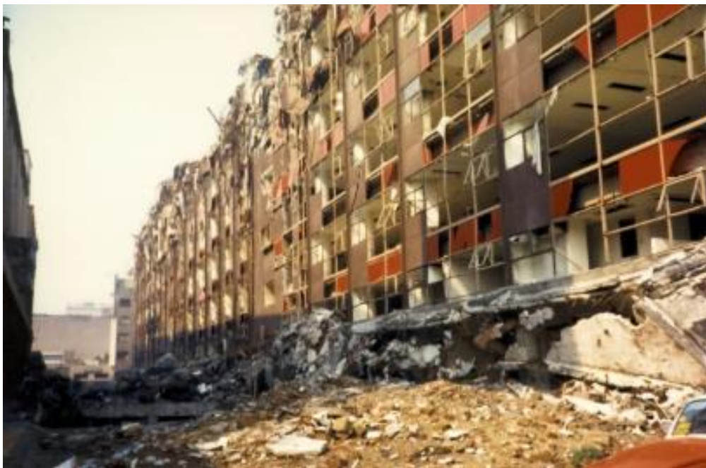
Figura 34. Secretaría de Comercio y Fomento Industrial, colapso de niveles superiores. 1985. Fuente: U.S. Geological Survey Library-USGS. http://library.usgs.gov/ ; fotografía Celebei M.
