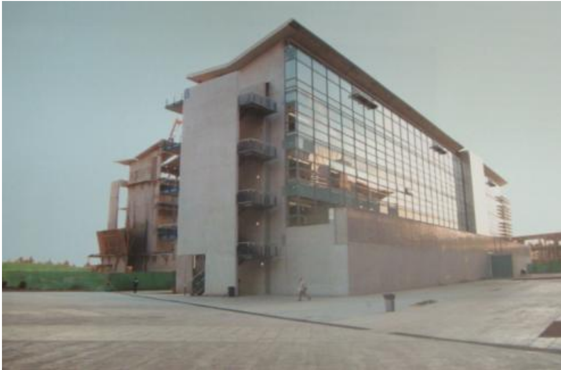
Figura 122. Edificios tipo de aulas. Fuente: CPVFACARQ.
