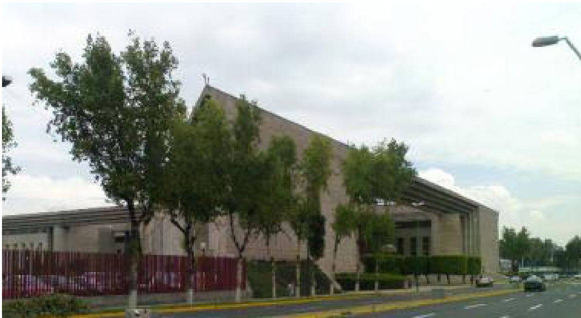
Figura 92. Fachada principal. Fuente: FRMH.
