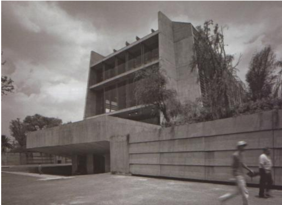
Figura 117. Fachada principal. Fuente: Archivo AK.
