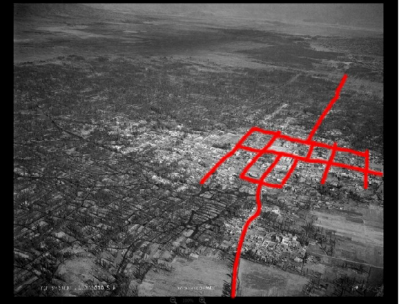
3. Vista panorámica del centro de Xochimilco a principios del siglo XX. Archivo histórico de Fundación ICA, donde se señalan las calzadas de pie o a tierra firme. Señalamiento y análisis por DRLT.
