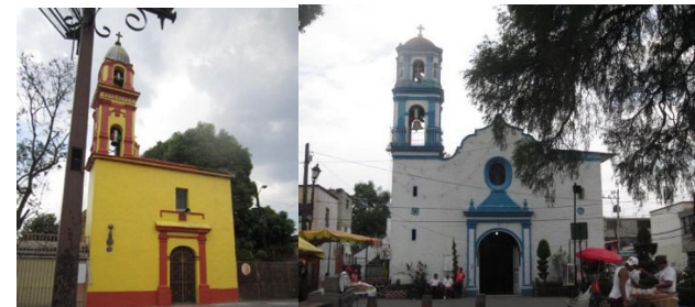
Fotografías núms. 22 y 23. Arquitectura religiosa; de izquierda a derecha, se muestran las capillas del barrio de San Marcos Tlaltepctalpan y de La Asunción Colhuacatzingo. En estos dos inmuebles se observa un estado de conservación bueno; D.R.L.T., 2014.
