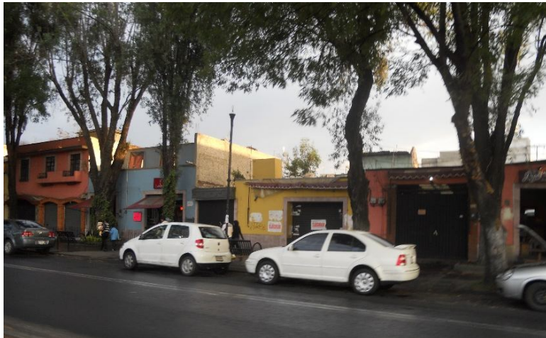
Fotografía núm. 2. Se aprecia la colocación indiscriminada de rodapiés y jambas de cantera en vanos de puertas y ventanas sobre inmuebles contemporáneos; fotografía: D.R.L.T., 2014.
