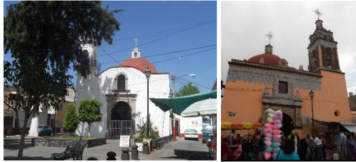
Fotografías núms. 24 y 25. Arquitectura religiosa; de izquierda a derecha, se muestran las capillas de los barrios de La Concepción Tlacoapa y El Rosario Nepantlatlaca. En ambos inmuebles se observa un estado de conservación bueno; D.R.L.T., 2014.
