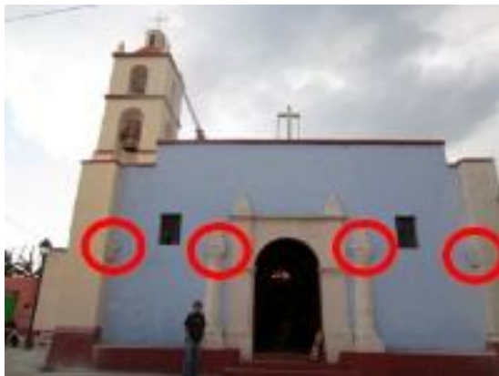
Fotografía número 52. En ella se aprecia la reminiscencia de capiteles de origen del siglo XVI y que dan idea de la existencia de tres arcos que formaban el acceso a esta capilla; se señalan con círculos los vestigios de los capiteles. Fotografía realizada por DRLT, 2014.
