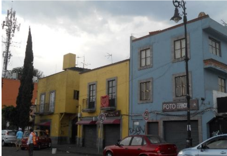
Fotografía núm. 1. Se aprecia la colocación indiscriminada de rodapiés y jambas de cantera en vanos de puertas y ventanas sobre todos los inmuebles; fotografía: D.R.L.T., 2014.
