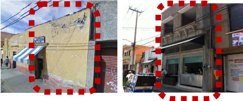
Fotografías núms. 8 y 9. Se muestra un inmueble ubicado en la calle Pedro Ramírez del Castillo que fue subdividido y cercenado por la mitad para incorporar una construcción de reciente manufactura de tres niveles; D.R.L.T., 2014.
