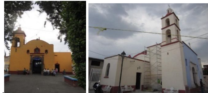
Fotografías núms. 20 y 21. Arquitectura religiosa; de izquierda a derecha, se muestran las capillas de los barrios de San Antonio Molotla y de Belem de Acampa. En ambos inmuebles se observa un estado de conservación bueno; D.R.L.T., 2014.
