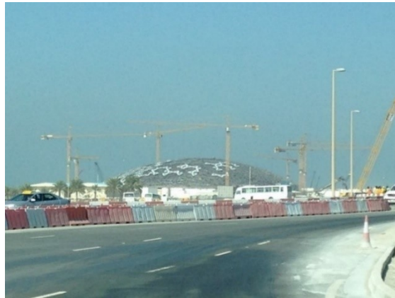
Figura 130. Vista de la Construcción de la cúpula. Ave. Saadiyat. Centro de las Artes Isla Saadiyat. Foto: César Herrera 02/2014
