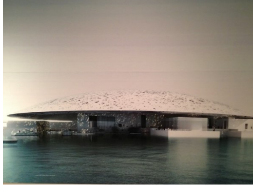
Figura 135. Fachada de acceso via mar. Jean Nouvel. 2007. Sala de presentación Urbana de la Isla de Sadiyath. Abu Dabi. Foto César Herrera 02/2014.
