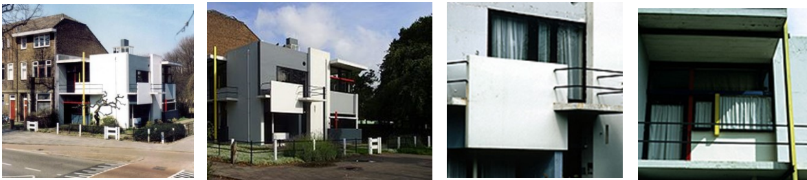
Figura 86. Fachadas de la Casa Suroeste. Figura 87. Fachada sur. Figura 88 y 89 Detalles de balcones Fuente: http://www.greatbuildings.com/buildings/Schroder_House.html . Consultada el 29/04/2019.
