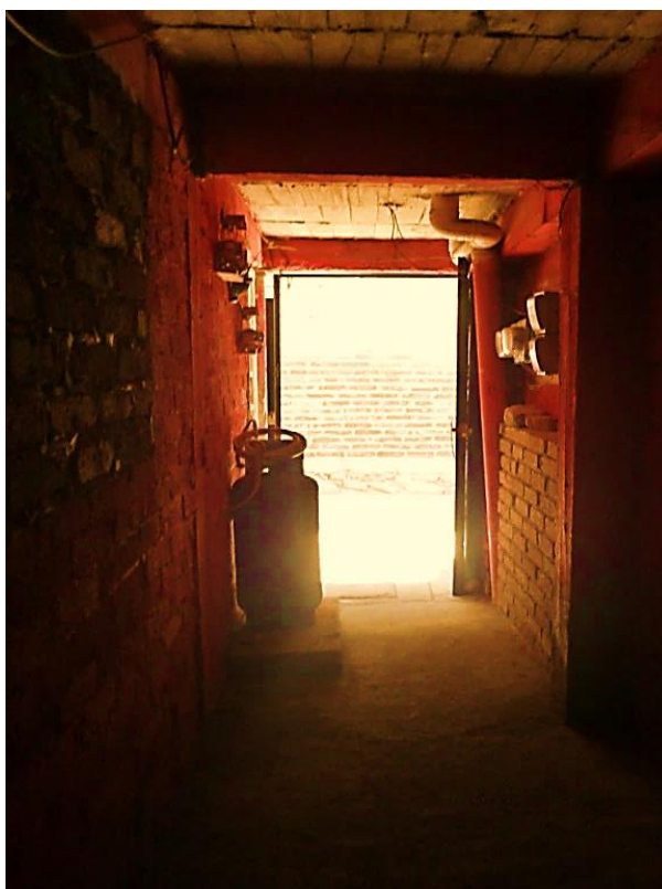
Imagen 2. Pedregal de Santo Domingo Acceso a la vivienda por pasillos oscuros de uso múltiple
