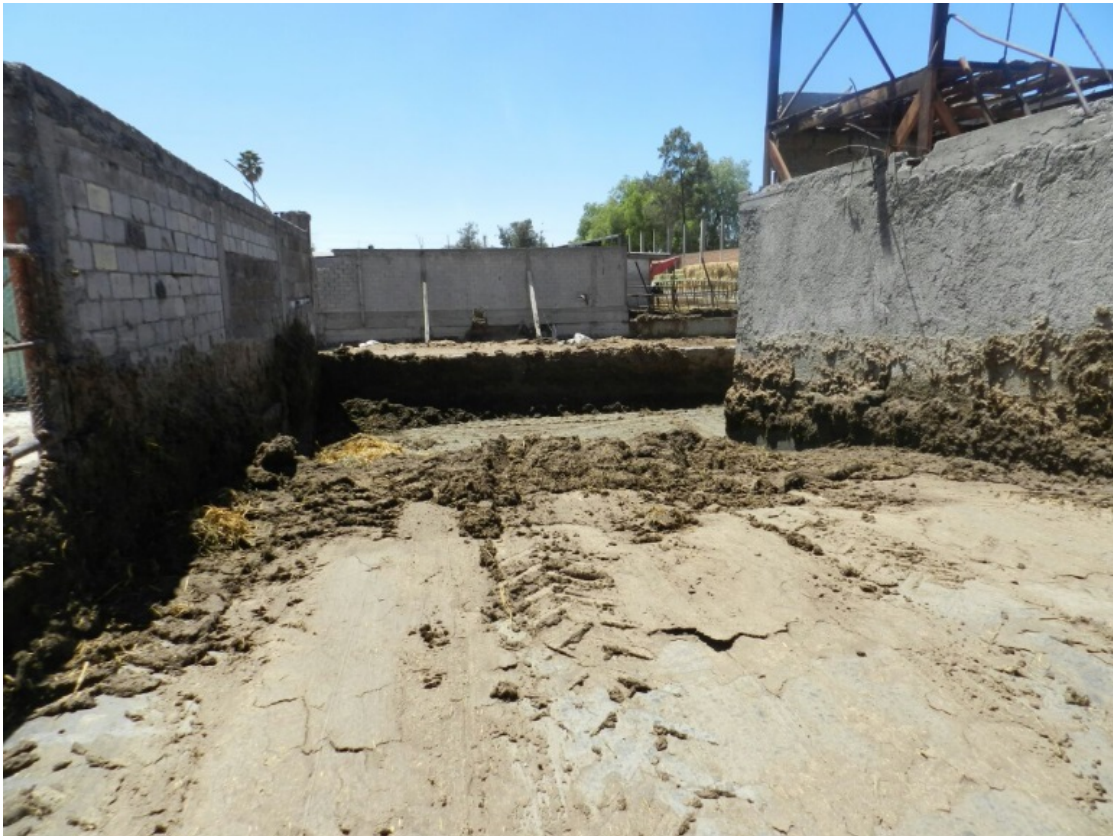
Fotografía 7 Salida de residuos fecales
