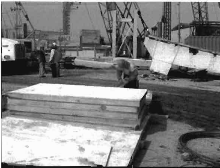
Ilustración 8. Habilitado. Corte de tarimas.
