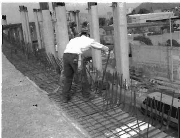
Ilustración 4. Doblez de las varillas en la las ballenas.
