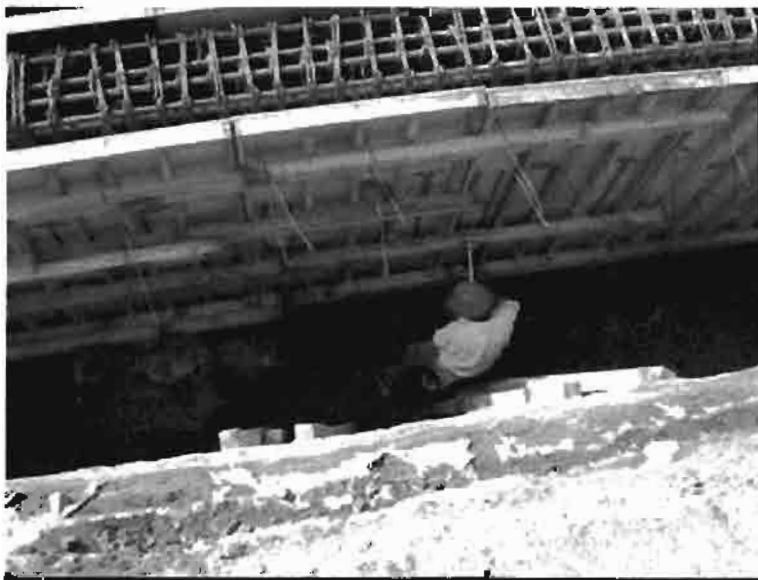
Ilustración 9. Montado de tarimas en la trabe.
