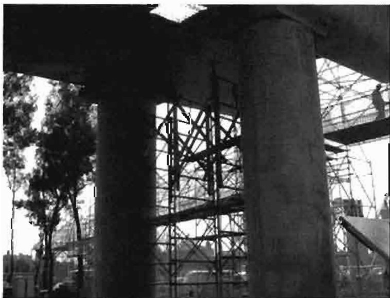
Ilustración 11. Andamio de cimbra en altura.
