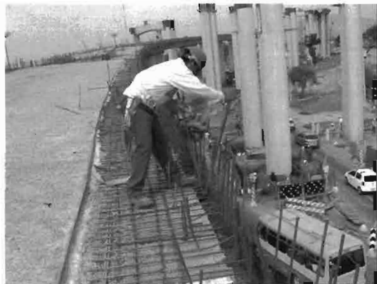
Ilustración 5. Amarre y dobléz de varillas.
