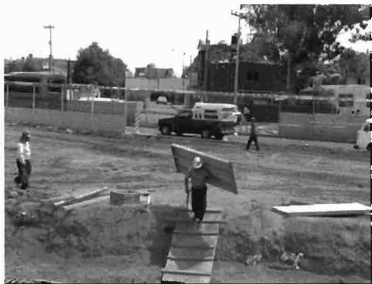
Ilustración 10. Acarreo de la cimbra a la trabe.
