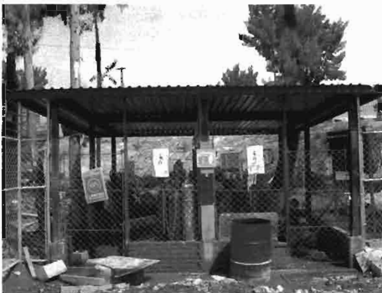
Ilustración 13. Instalaciones de resguardo de material peligroso y flamable.
