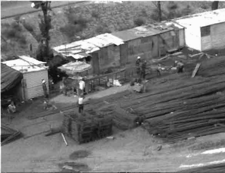
Ilustración 2. Área de habilitado de los fierros.
