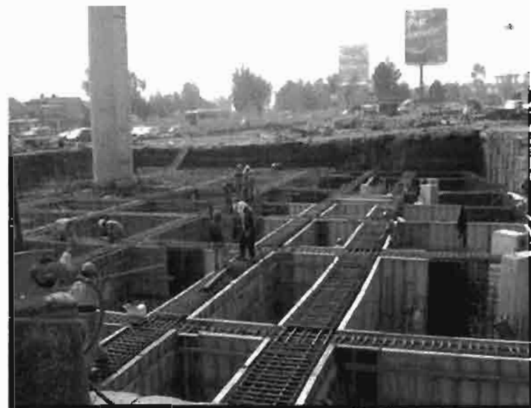
Ilustración 6. Trabajo de los carpinteros en la cimentación superficial (zapatas).
