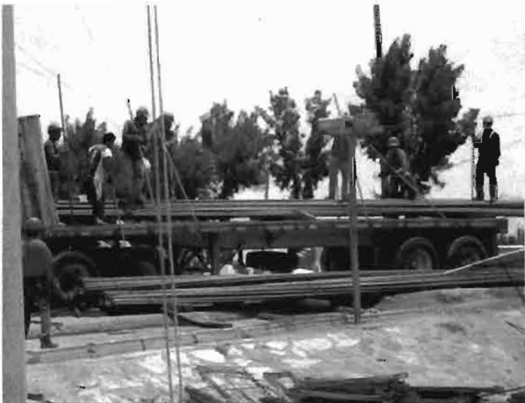
Ilustración 3. Descargado de las varillas en el área de habilitado de los fierros.
