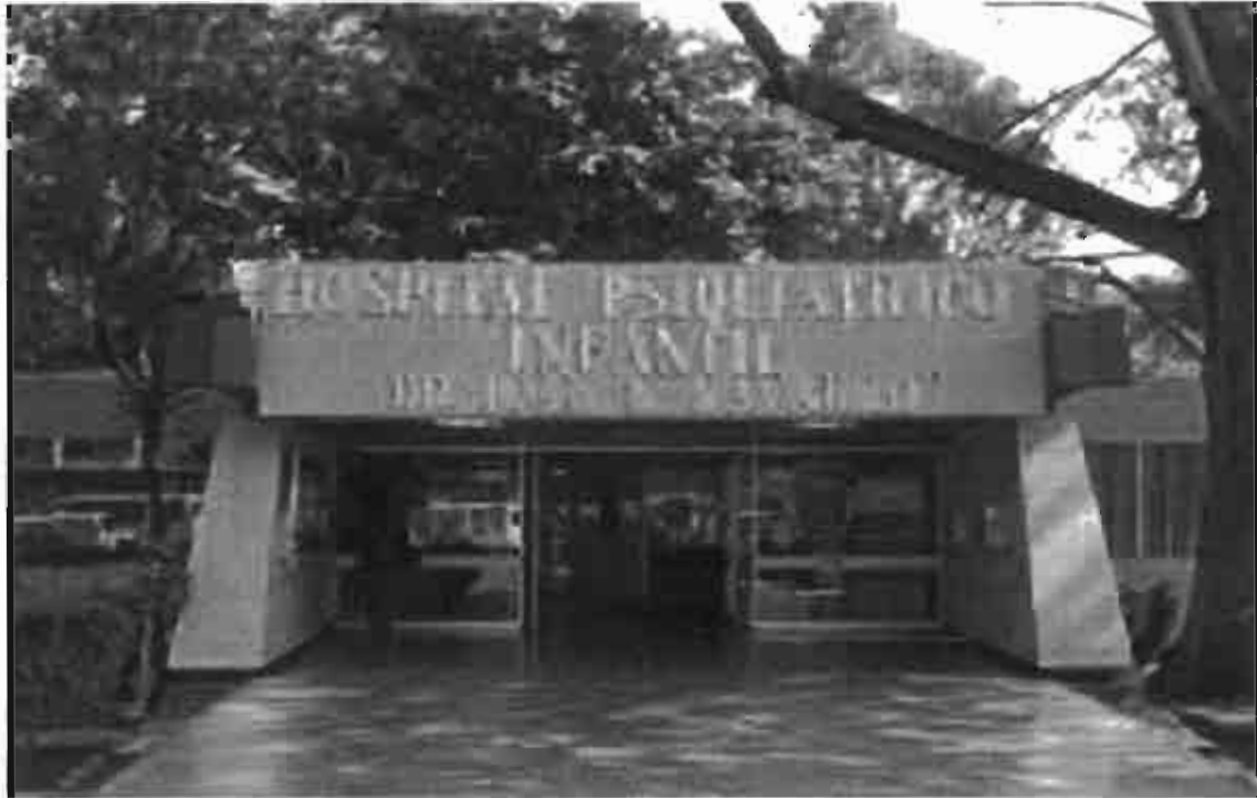
Foto 2. Puerta principal de acceso, área de consulta externa.
