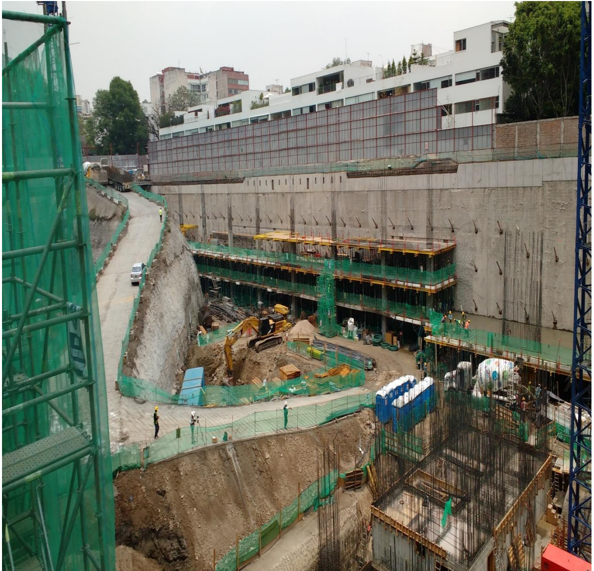
Figura 2. Levantamiento de sótanos
