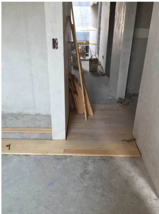
Imagen 4. Colocación de duela
