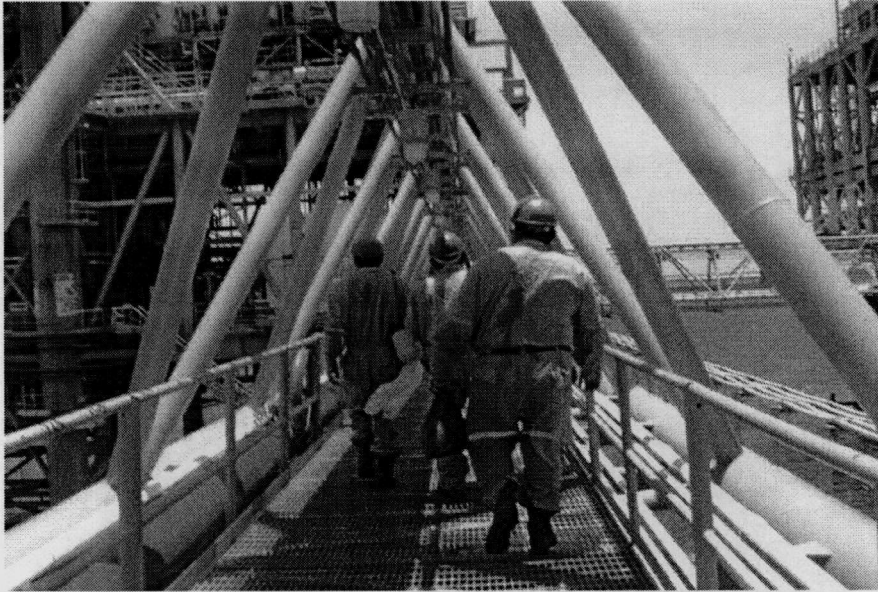
Foto. Éste es el puente por donde los trabajadores pasan todos los días para trasladarse al área de trabajo.
