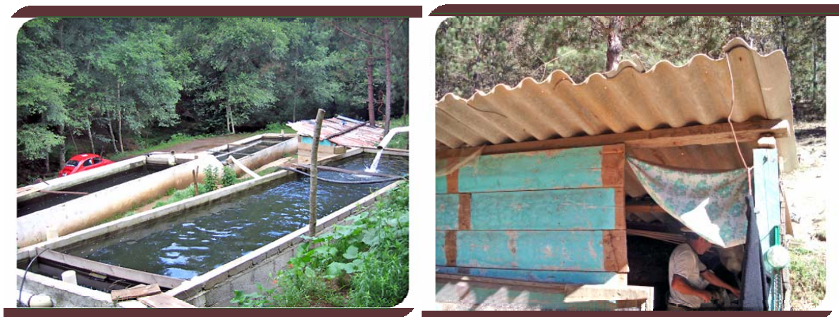
Figura 22. Estanquería y área donde almacena el alimento y la herramienta la unidad de producción C
